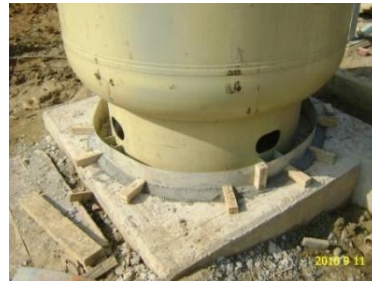
Fig. 2. Formaleta par Grout.
