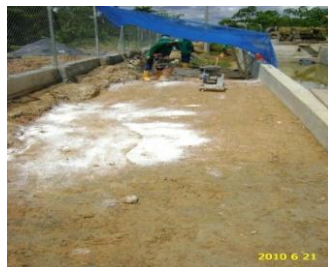
Fig. 6. Relleno para vía.
