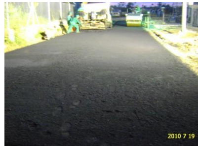
Fig. 12. Aplicación de carpeta asfáltica.
