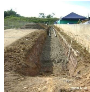
Fig. 5. Excavación para tuberías
