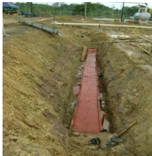
Fig. 3. Excavación para ductos.
