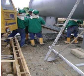
Fig. 8. Vaciado concreto.
