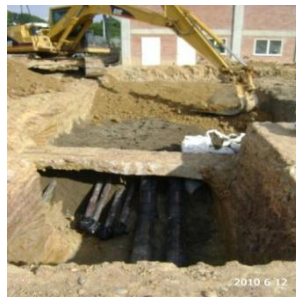
Fig. 4. Excavación para estructura
