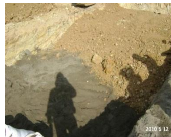
Fig. 7. Relleno para estructura.
