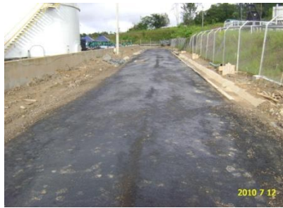
Fig. 11. Imprimación.
