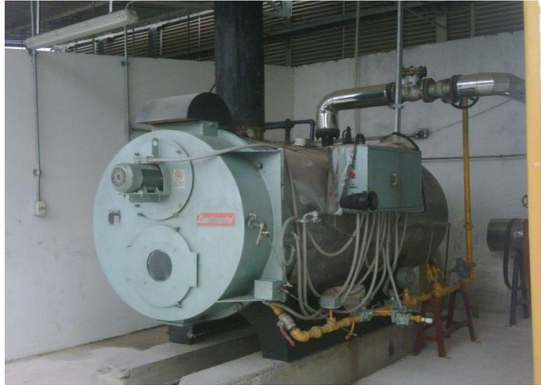
Figura 23. La caldera de vapor de la planta
