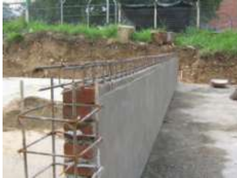
FRISO SOBRE MUROS DIVISORIOS LOCALES Figura No. 12
