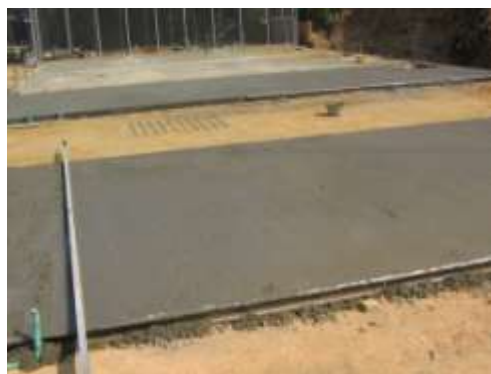
FUNDIDA DE PISO EN CONCRETO LOCALES Figura No. 14
