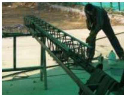
PROCESO CONSTRUCTIVO DE LAS COLUMNAS METALICAS
