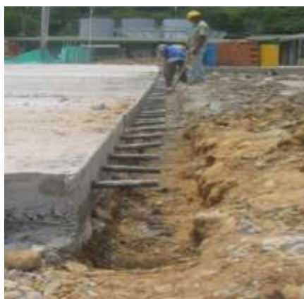
VISTA DE LA LOSA CONCRETO Y REFUERZO JUNTA EXPANSION Figura No. 18
