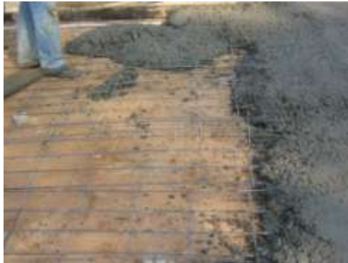
FUNDIDA DE PISO EN CONCRETO DE 3000 PSI Figura No. 13
