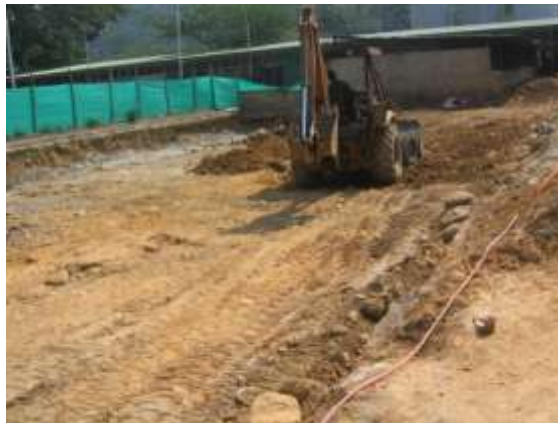
EXCAVACIONES PARQUEADERO Y VIA Figura No. 7
