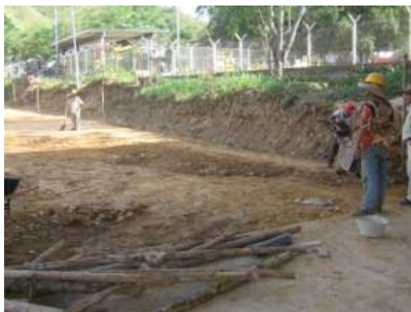
REPLANTEO MANUAL SOBRE EL AREA DE LOS LOCALES Figura No.4
