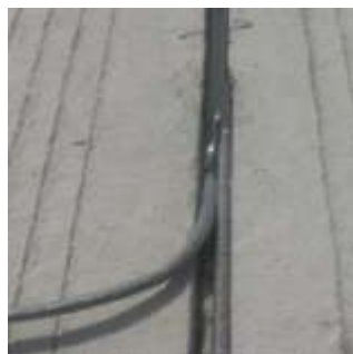
PROCESO DE INSTALACION DEL CORDON SINTETICO Y CONTINUA CON LA APLICACIÓN DEL SELLANTE SIKA
