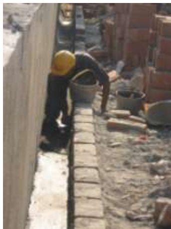
CONSTRUCCION CANALETA Figura No. 15
