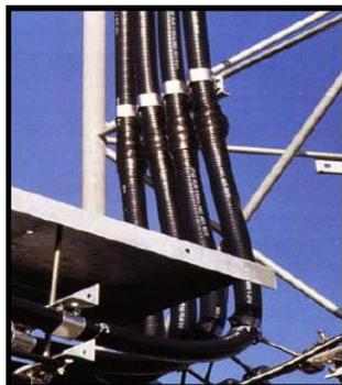
**Figura 19.** Líneas de Transmisión Coaxiales [10].
