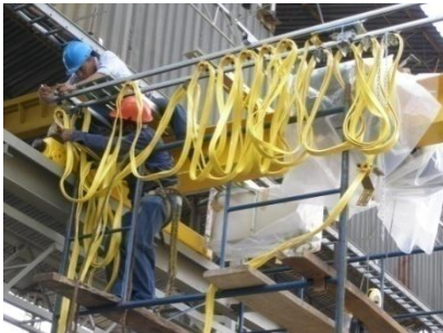
Fig. 52 Instalación del Cable Botonera
