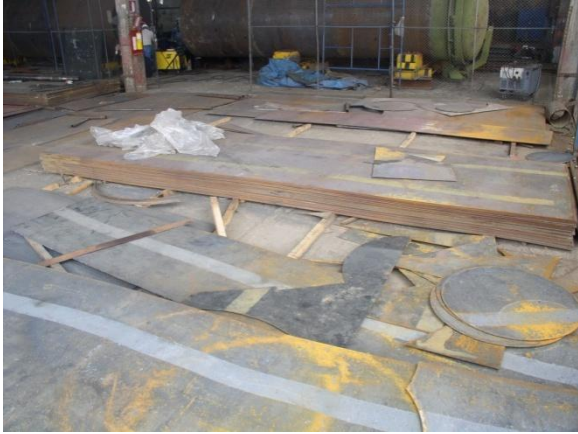
Fig. 18 Almacenamiento de Retales de Láminas
