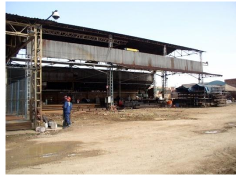
Fig. 36 Área Despejada de Perfilería
