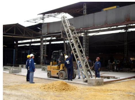
Fig. 42 Montaje de las Columnas del Puente Grúa
