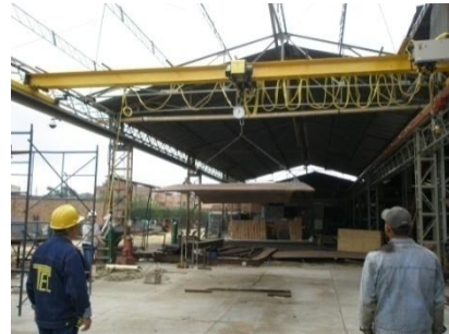
Fig. 53 Pruebas de Carga del Puente Grúa
