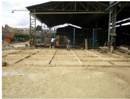
Fig. 39 Ensamble de las Tablas que darán la Forma de las Lozas
