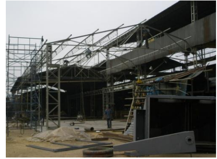
Fig. 44 Montaje de las Correas, Templete y Contravientos
