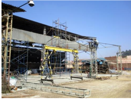
Fig. 43 Montaje de las Cerchas
