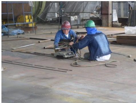
Fig. 24 Contratistas de TEC Cortando con Tortuga Láminas Nuevas
