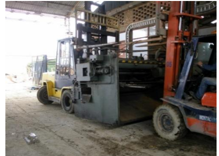
Fig. 46 Traslado y Ubicación de la Cizalla
