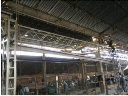
Fig. 48 Montaje de las Vigas Carrileras y Vigas de Amarre
