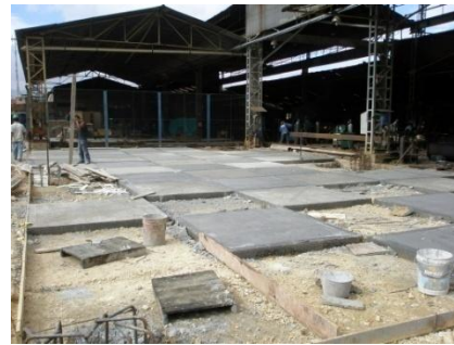
Fig. 40 Fundición del Concreto
