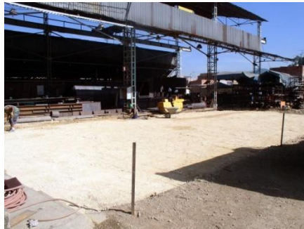
Fig. 37 Nivelación y Recebamiento de la Nueva Nave
