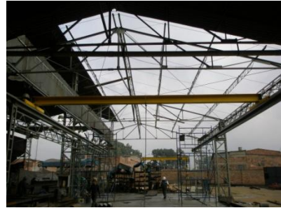
Fig. 49 Montaje de la Estructura del Puente Grúa
