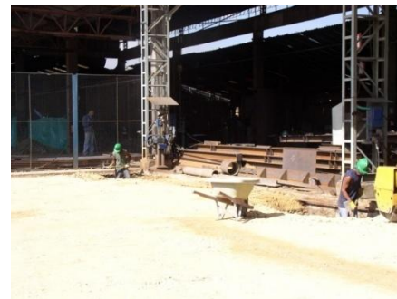
Fig. 38 Excavación de las Zapatas
