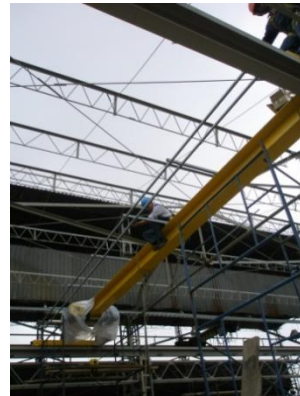
Fig. 51 Montaje de los Rieles que Transportar la Botonera Independiente
