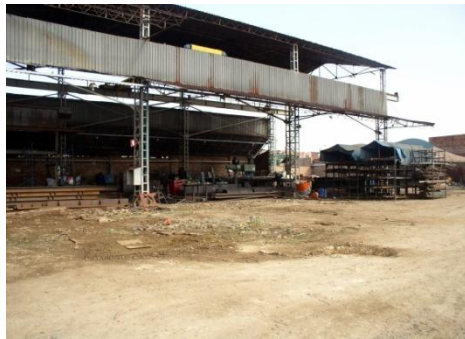
Fig. 35 Despeje de los retales de Perfilería
