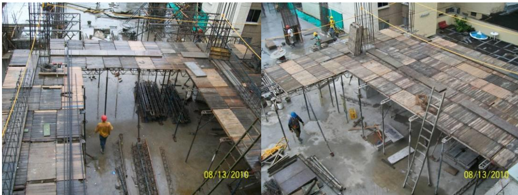
Figura 42 . Encerchado y entablado.
