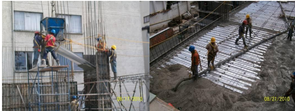
Figura 49 . Fundida de Columnas y Placa
