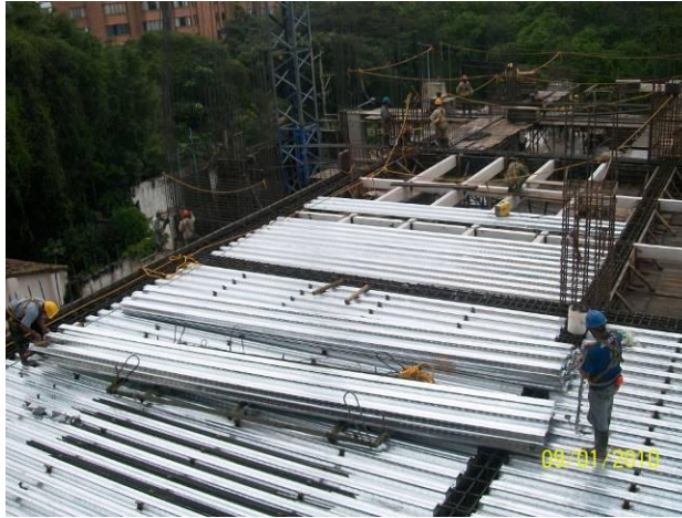
Figura 47. Instalación de Corpalosa
