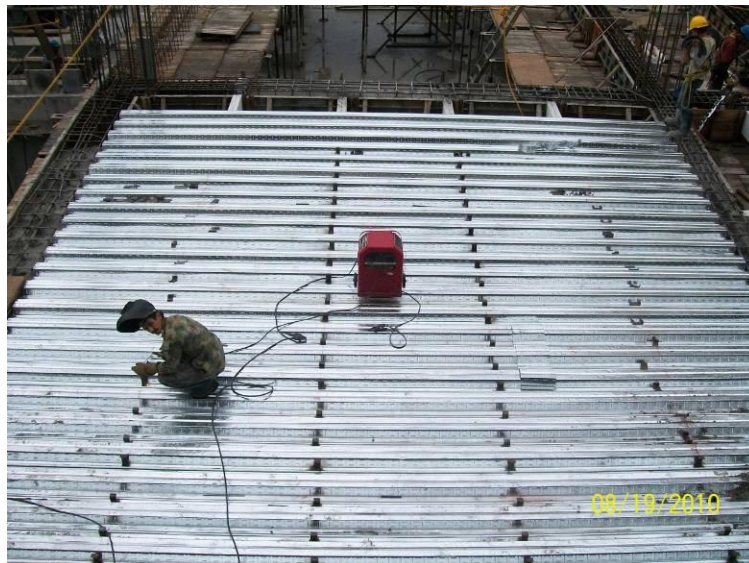
Figura 48. Soldadura de Conectores.
