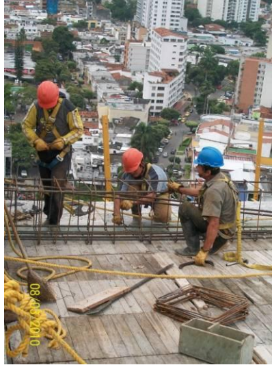
Figura 43 . Amarre de vigas.
