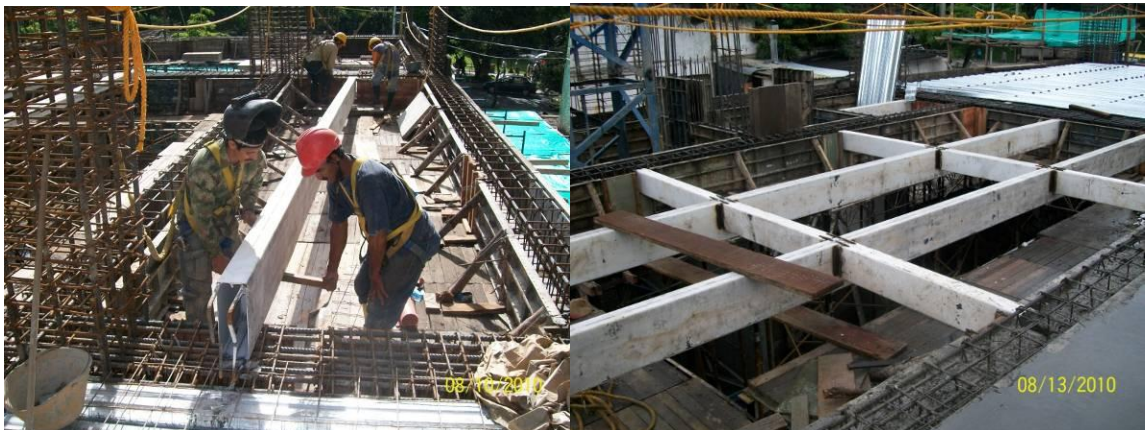
Figura 46 . Instalación de Perlina
