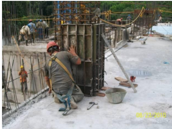
Figura 45. Encofrado de Columna
