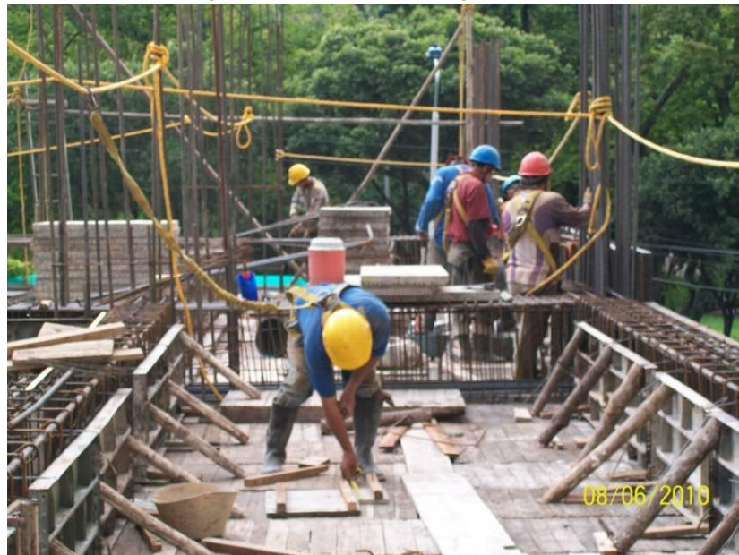
Figura 44. Embandada de viga
