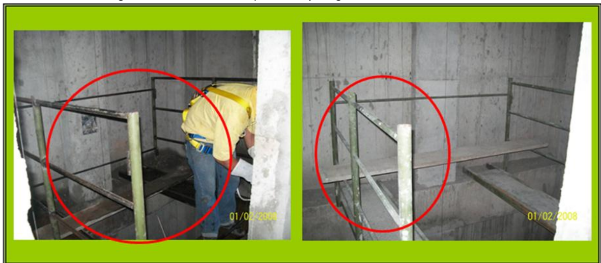
Figura 68. Sistema tubular para trabajo seguro en fosos de ascensores.
