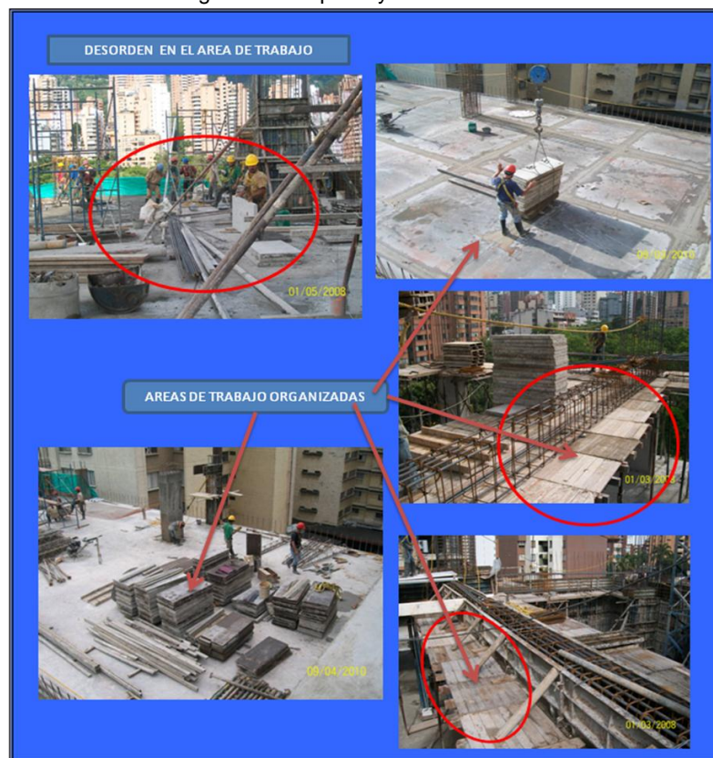
Figura 67. Limpieza y Orden en Placa.
