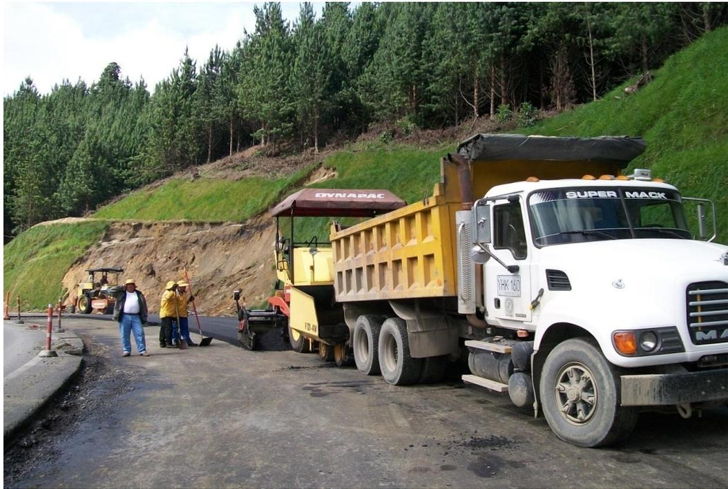
Figura 33. Descargue de mezcla asfáltica PR 20+300
