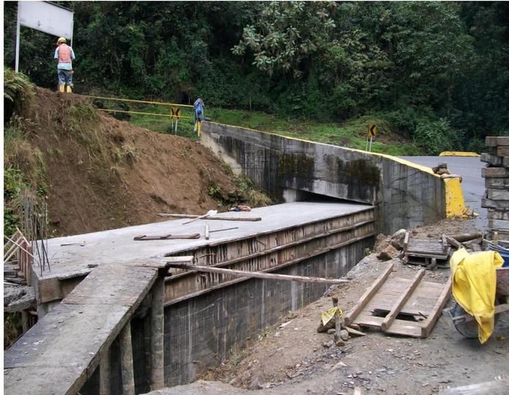
Figura 9. Construcción de extensión del cajón PR31+420
