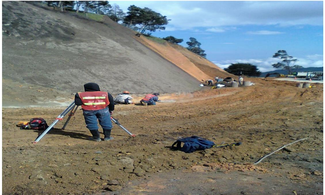
Figura 18. Levantamiento Topográfico PR 21+800
