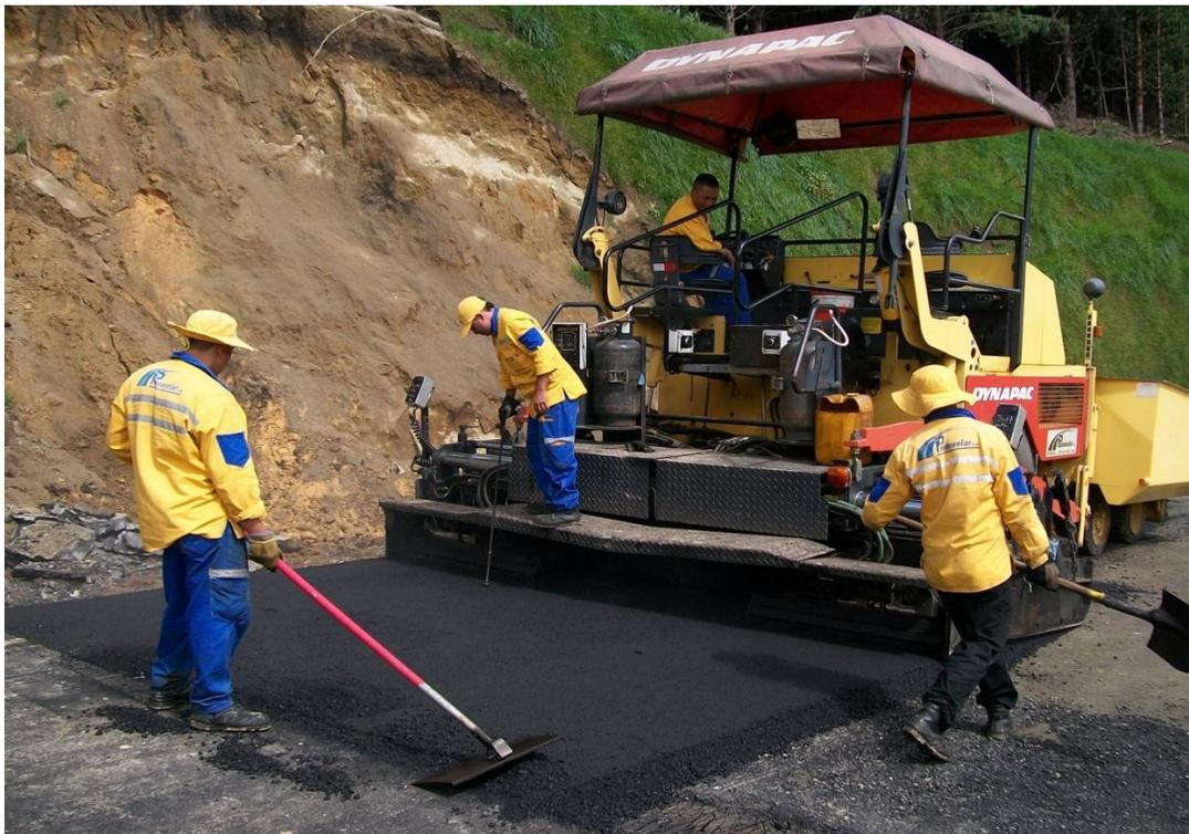
Figura 34. Extendida de mezcla asfáltica PR 20+300
