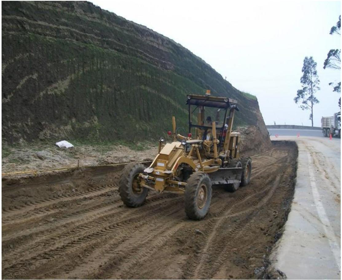
Figura 24. Nivelación de sub-base PR 20+950
