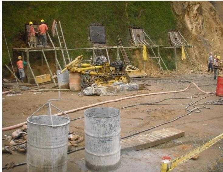
Figura 12. Pantallas ancladas PR19+800
