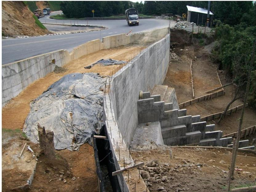
Figura 7. Construcción de Disipadores PR19+900
