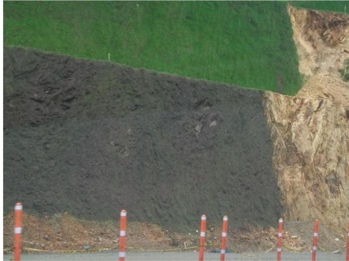
Figura 13. Colocación del Geoverde
