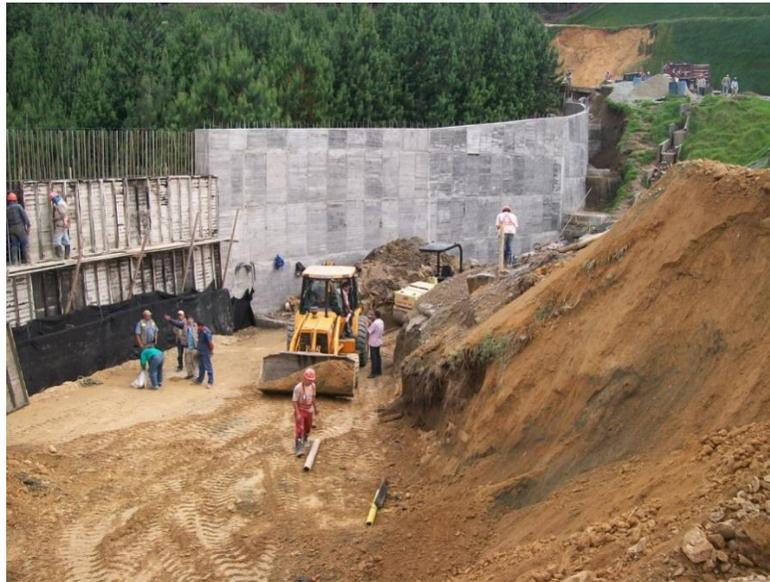
Figura 3. Construcción de taludes de relleno y muro de contención
