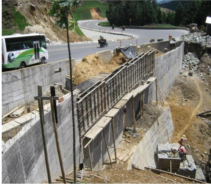
Figura 4. Construcción de muro de contención
