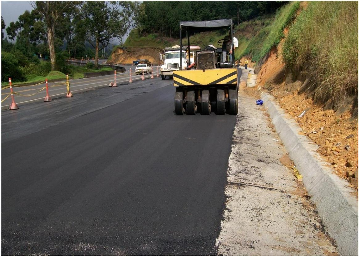
Figura 39. Sello de fisuras en PR 19+820
