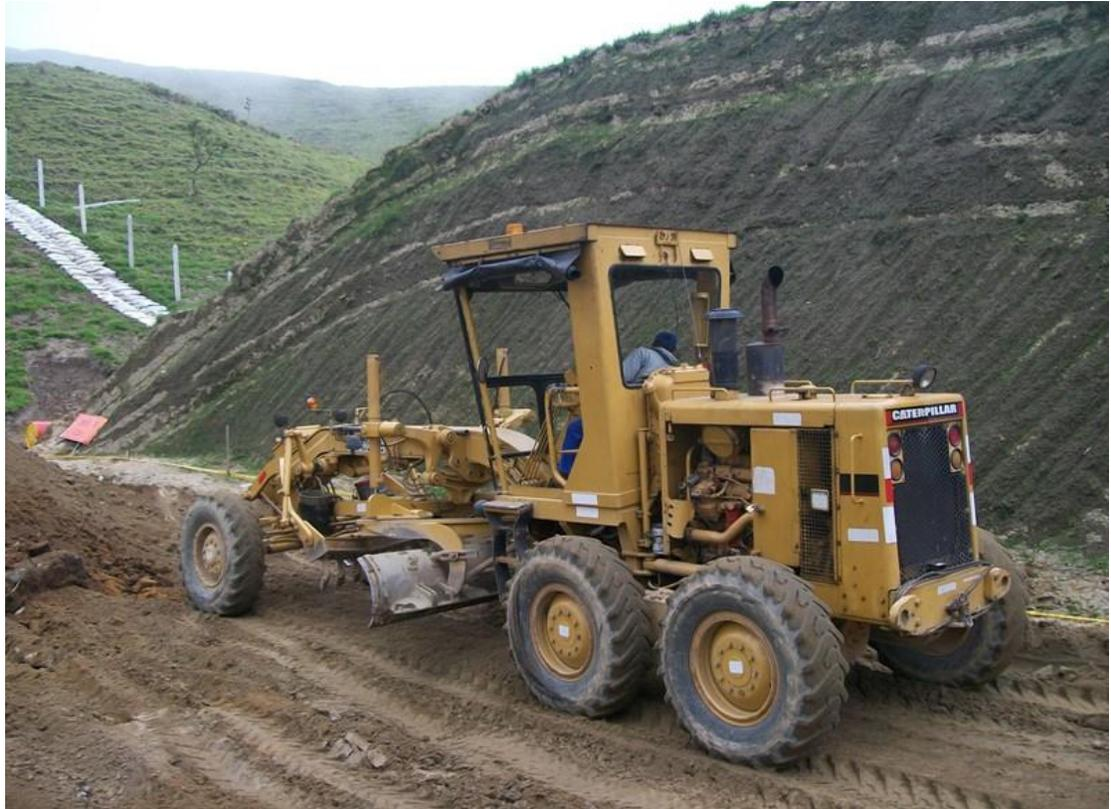
Figura 23. Nivelación de sub-base PR 20+930
