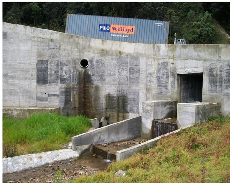
Figura 10. Construcción terminada de extensión del cajón PR31+420
