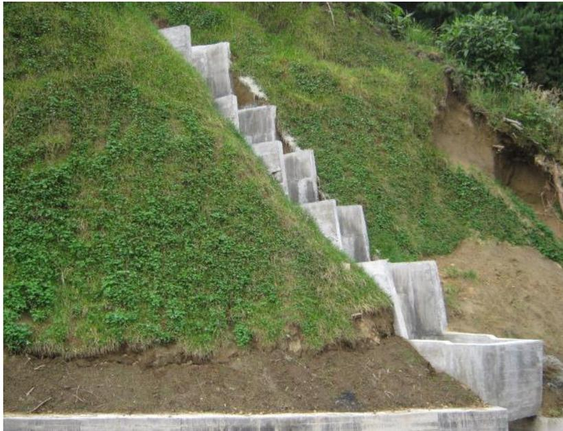
Figura 6. Construcción de Disipadores PR18+600
