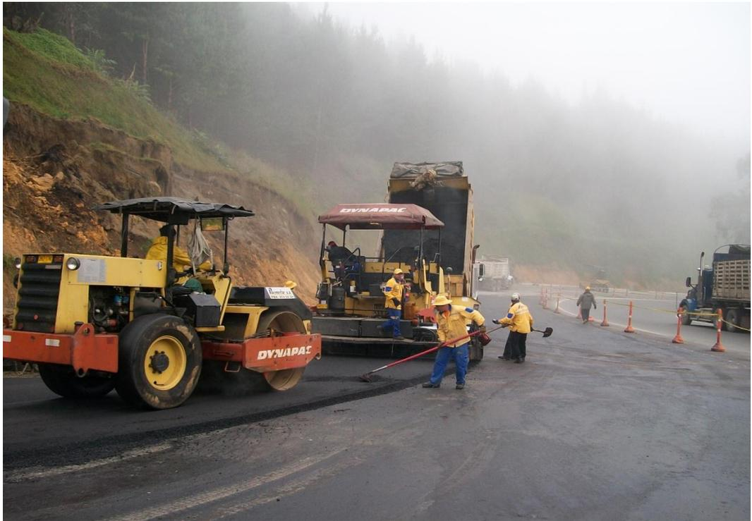
Figura 36. Vibrocompactador en PR 19+900
