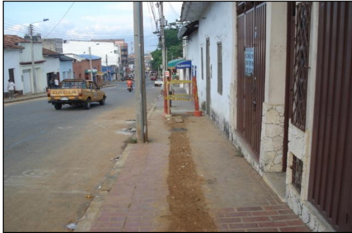
Figura 22. Instalación de Material seleccionado
