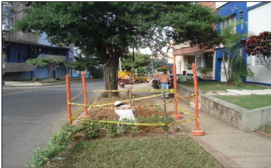
Figura 7. Trabajos en redes subterráneos
