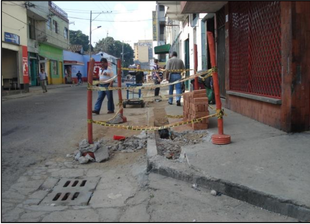
Figura 11. Señalización de Obras en redes subterráneas
