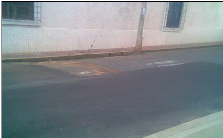
Figura 23. Reposición de pavimento flexible.
