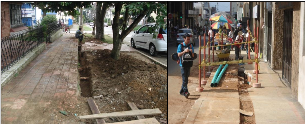
Figura 13. Canalización a Cielo Abierto
