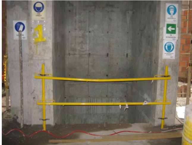
Figura 29: Protección del vacío
