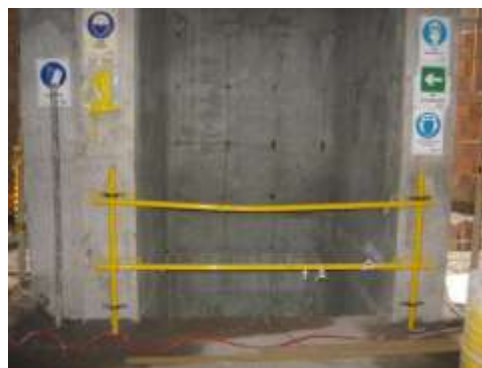
Figura 5. Protección del Vacío. ELCOSH.
