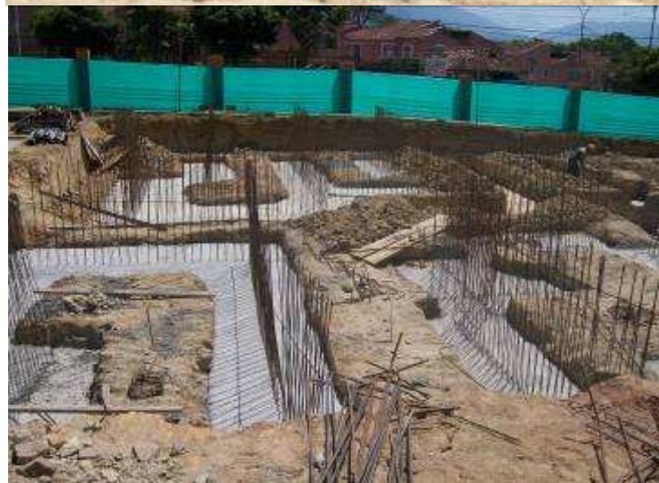
Capítulo de Cimentación torres.
