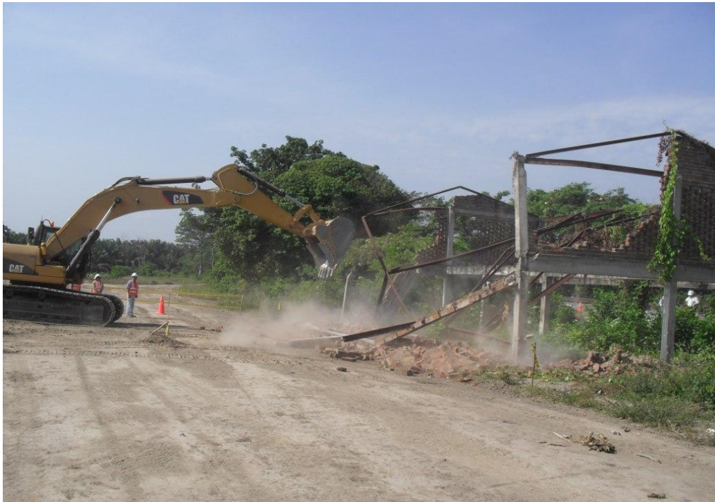
Foto 3. Demolición de una estructura
