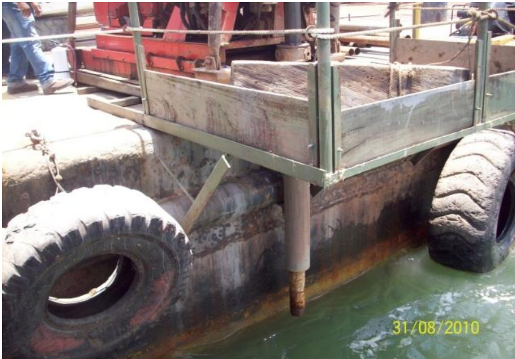
Foto 36: Perforaciones en el mar
