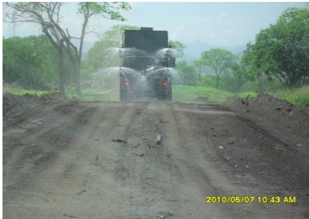
Foto 39: Riego de vías
