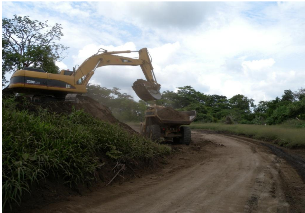
Foto 2. Movimiento de tierras
