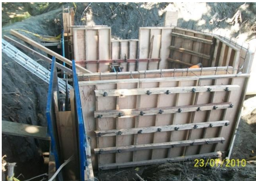
Foto 61: Construcción de formaletas con madera del aprovechamiento forestal
