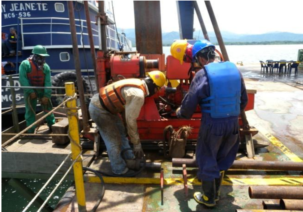
Foto 84: Equipo de perforación en uso
