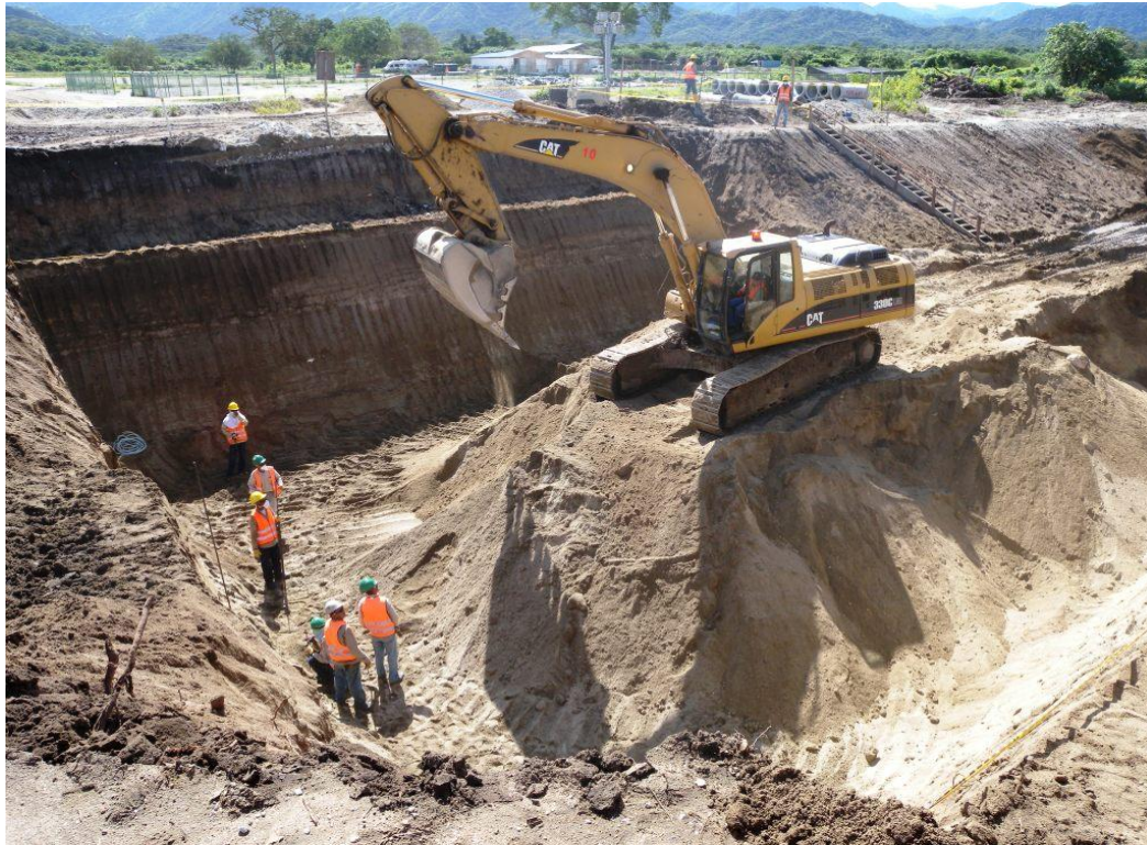
Foto 8. Excavación para construcción de puente
