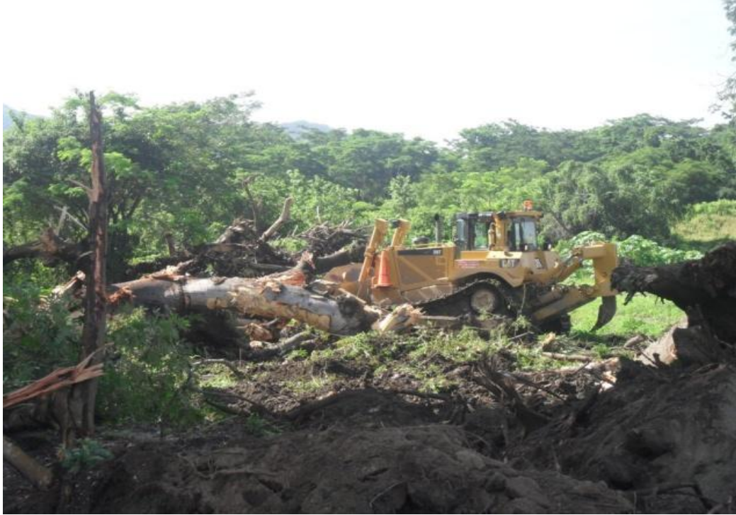
Foto 25. Almacenamiento material descapotado
