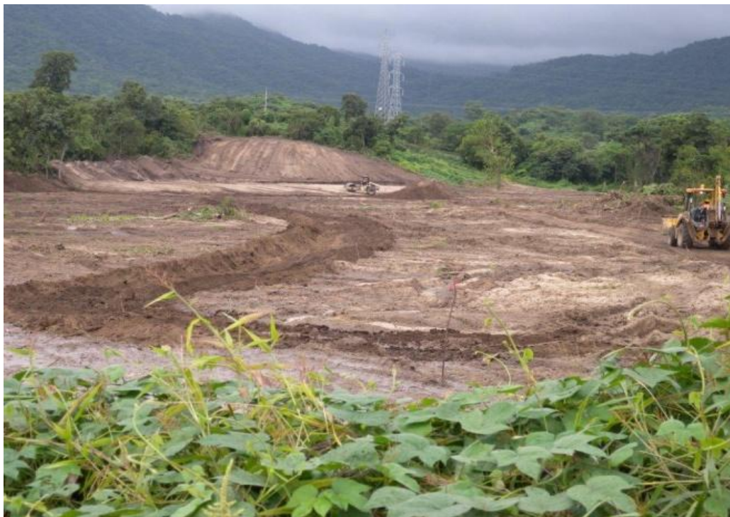
Foto 71: Futura desviación de la quebrada el Guayabo intervenida
