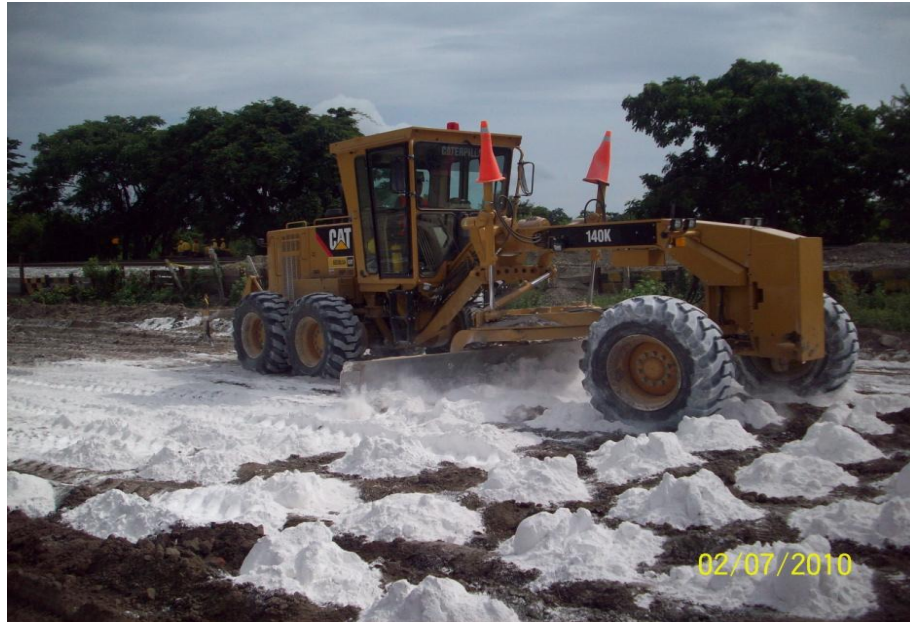
Foto 4. Esparcimiento de cal en Loop Férreo, para estabilizar terreno.
