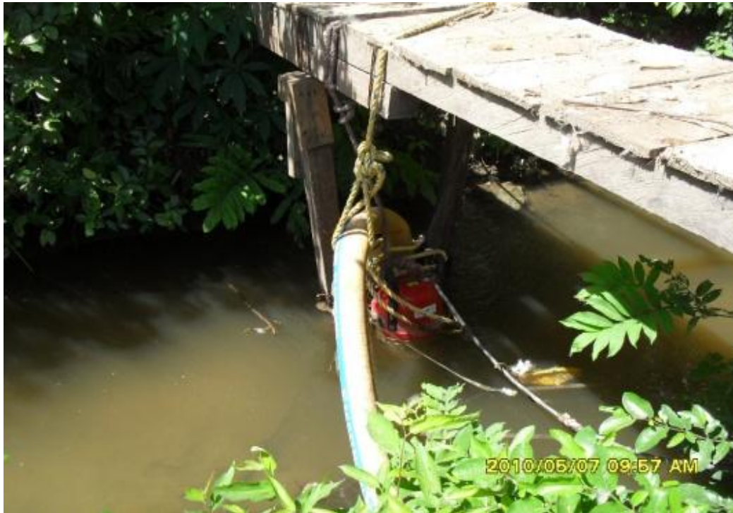
Foto 29: Captación de aguas No autorizadas
