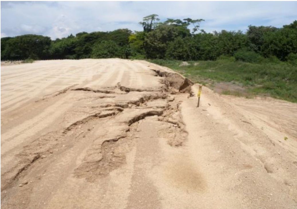
Foto 22. Erosión Zona Oeste
