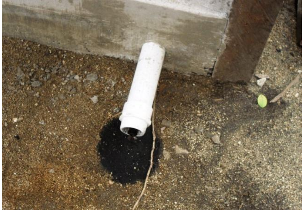
Foto 16. Vertimiento de aceite en sitio de almacenamiento de RESPEL
