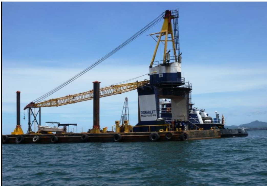
Foto 80: Plataforma Suelos Ingeniería LTDA
