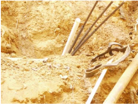
Figura 7. Manguera de protección.
