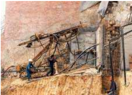
Figura 11. Colocación del Anclaje
