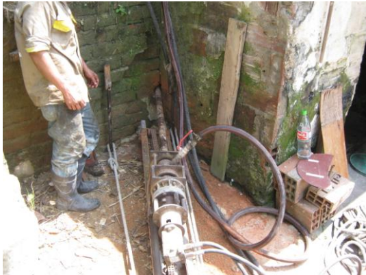
Figura 10. Equipo de perforación
