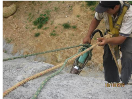
Figura 16. Equipo de Tensionamiento y colocación del gato
