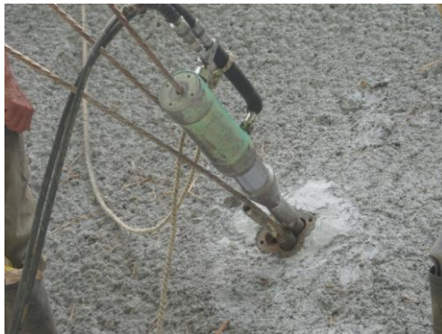
Figura 17. Tensionamiento de anclajes 3 y 5 Torones
