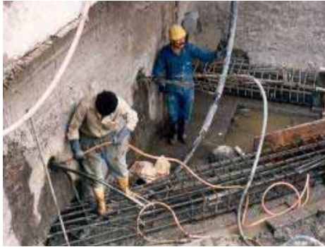
Figura 15. Lavado de la Tubería después del Proceso de Inyección
