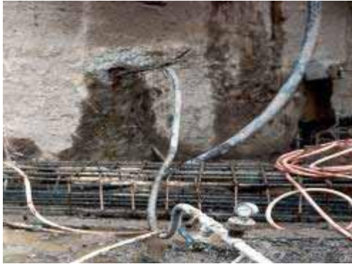
Figura 13. Inyección longitud del bulbo
