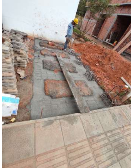
Figura 64 Fundida de cimentación de pérgolas de garaje.
