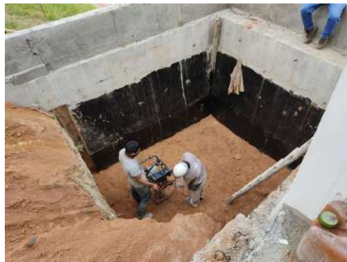
Figura 42 Relleno y compactación en área de muro de contención.
