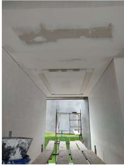
Figura 22 Nichos de luces en cielo raso.
