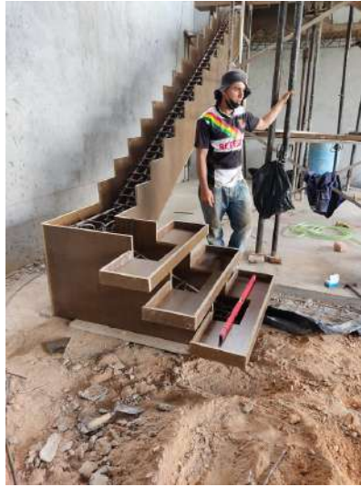
Figura 23 Armado de formaleta de escaleras.
