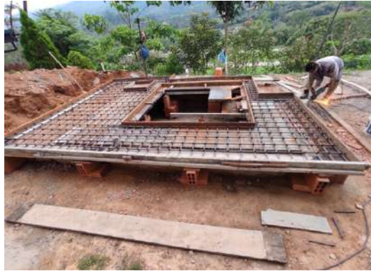
Figura 35 Armado de acero de refuerzo de placa de jacuzzi.
