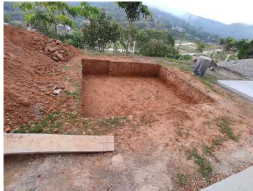
Figura 33 Excavación jacuzzi.
