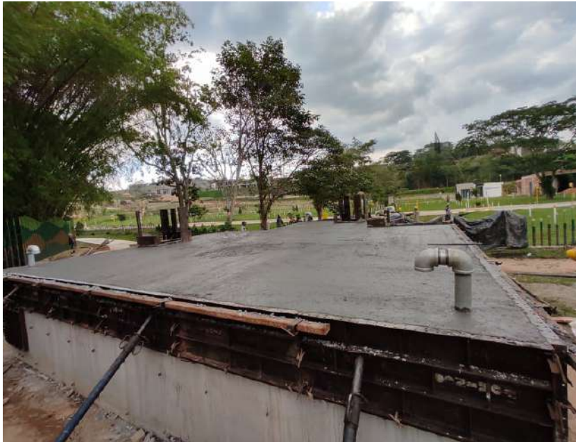
Figura 80 Fundida de placa de tanque de agua.
