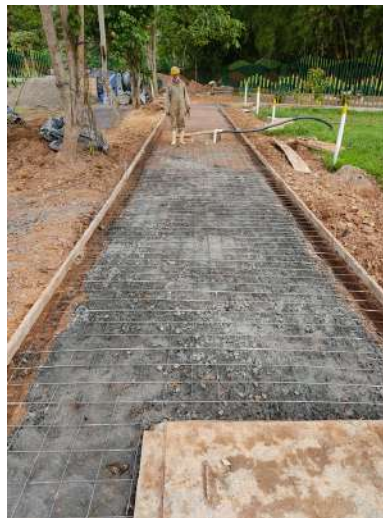
Figura 82 Colocación de malla electro soldada y armado de formaleta para fundida de tramo de ciclo ruta.
