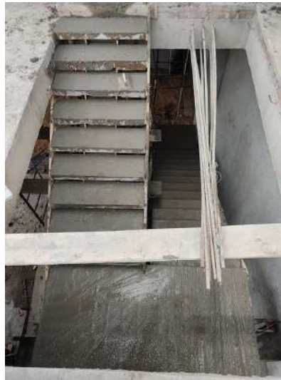
Figura 25 Fundida de escaleras.
