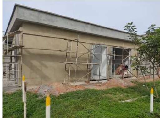
Figura 55 Pegacor como estuco en fachada.
