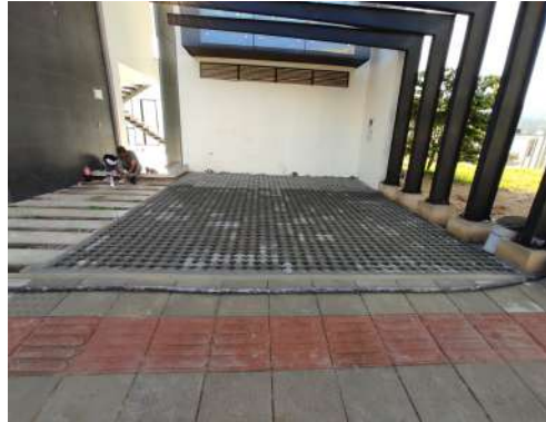
Figura 41 Instalación completa de adoquines en área de garaje.
