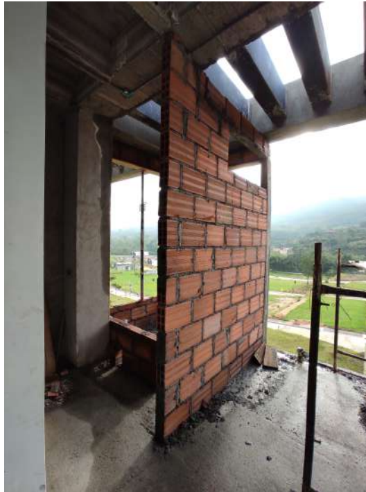
Figura 47 Muro sin friso.
