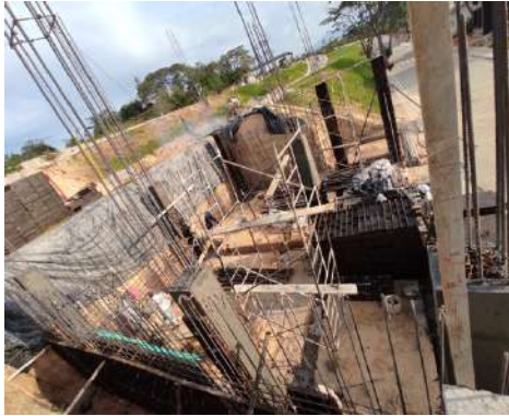
Figura 39 Armado de acero de refuerzo muro de contención.
