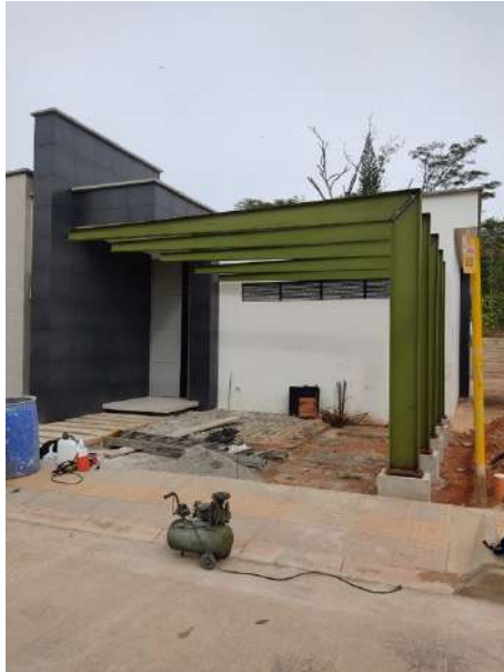
Figura 66 Colocación de pérgolas metálicas en pedestales.
