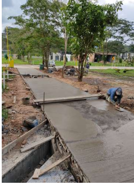
Figura 83 Fundida de tramo de ciclo ruta.
