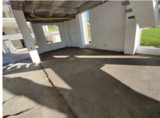
Figura 44 Mortero nivelador de piso.
