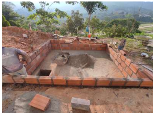
Figura 34 Bases de mampostería para placa de jacuzzi.
