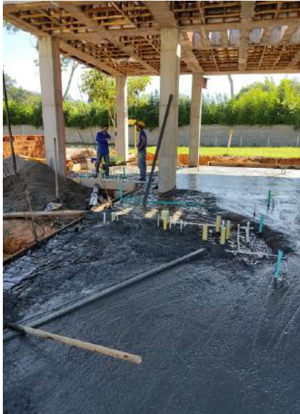
Figura 73 Fundida de placa contrapiso.
