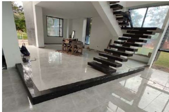
Figura 68 Revestimiento en mármol de escaleras, descansos y esquineros.
