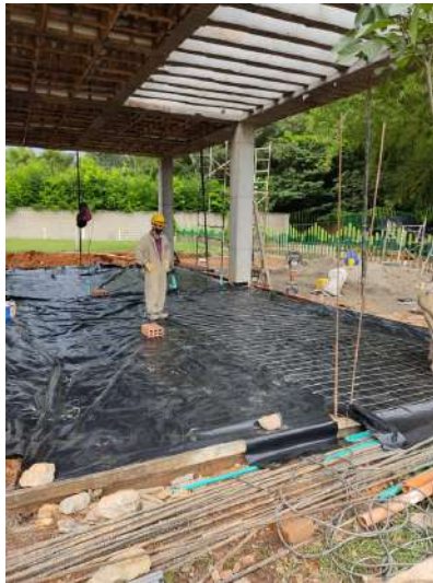
Figura 72 Colocación de malla electro soldada y plástico.
