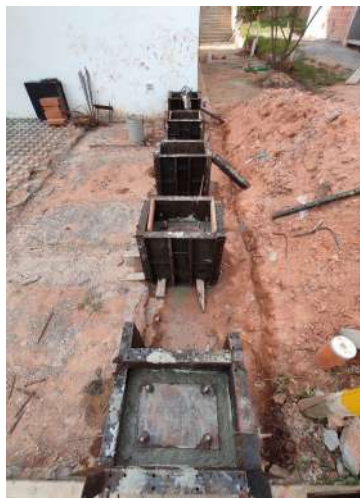
Figura 65 Fundida de pedestales de pérgolas.
