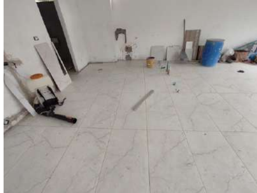
Figura 28 Enchape cerámico de piso primer nivel.
