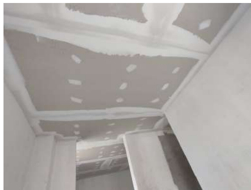
Figura 21 Placas de eterboard enmasilladas.
