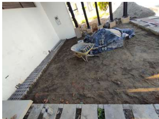
Figura 40 Instalación de adoquines garaje.
