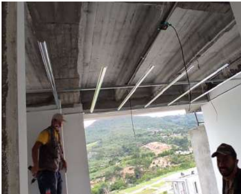
Figura 19 Armado de estructura de cielo raso.
