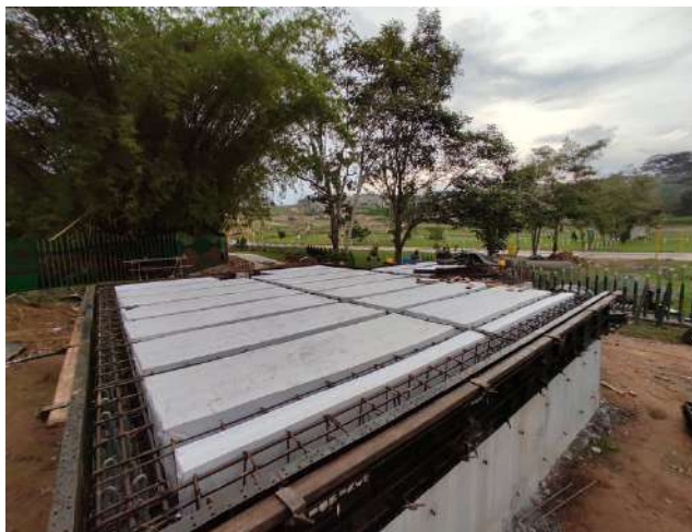
Figura 79 Placa con casetones y formalita lista para proceder con el vertimiento de concreto.
