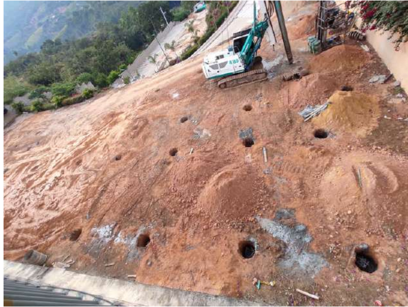
Figura 77 Área intervenida para la fundida de pilotes.
