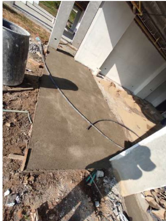
Figura 46 Mortero nivelador de piso en área de terraza.
