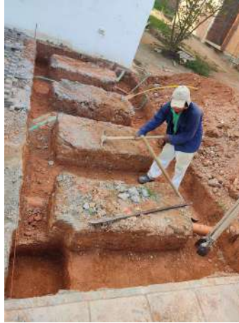
Figura 62 Excavación de cimentación de pérgolas de garaje.
