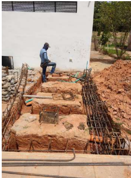
Figura 63 Amarre de acero de refuerzo cimentación de pérgolas de garaje.
