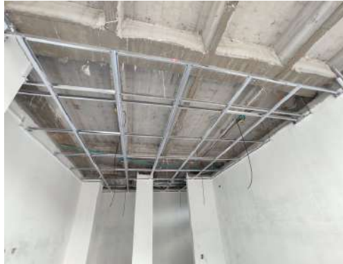
Figura 20 Estructura de cielo raso (omegas y viguetas).
