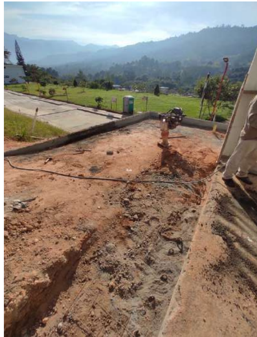
Figura 43 Área completamente rellena y compactada.
