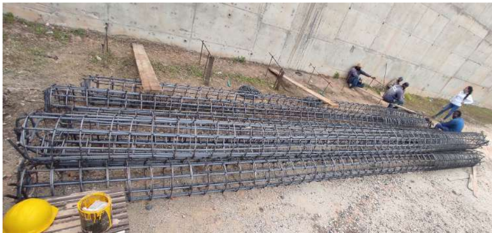
Fuente. Propia. Figura 75 Amarre de acero de pilotes.
