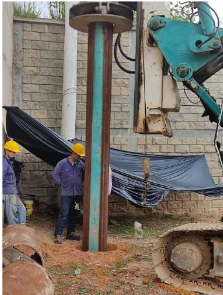
Figura 76 Perforación de pilotes con maquina piloteadora.
