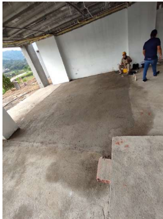
Figura 45 Mortero nivelador de piso en área de cocina.
