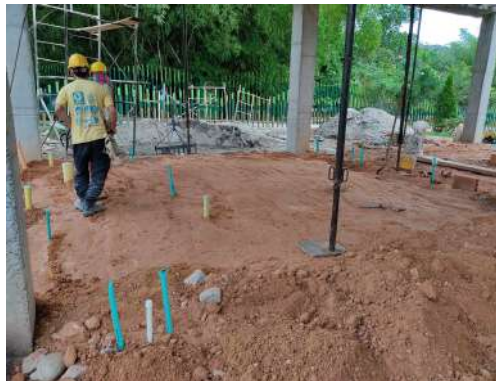
Figura 70 Placa contrapiso con tubería eléctrica previamente colocada
