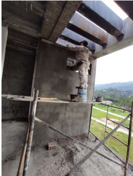
Figura 48 Muro frisado.
