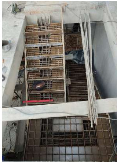
Figura 24 Detalle de acero de refuerzo escaleras.
