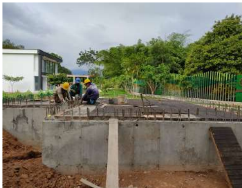
Figura 78 Armado de cerchas y tablonos para placa de tanque de agua.
