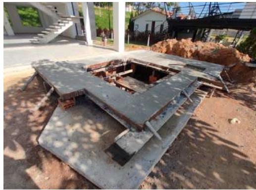
Figura 36 Placa de jacuzzi fundida.
