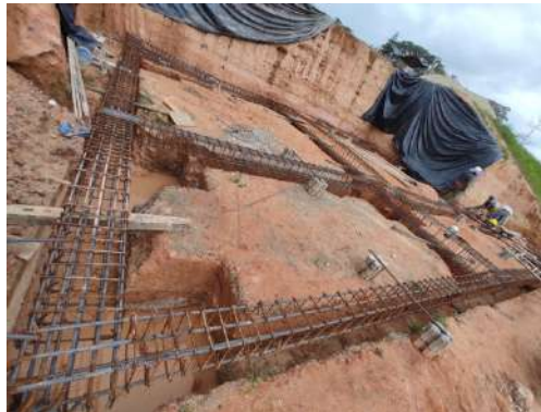
Figura 38 Amarre de acero de cimentación.
