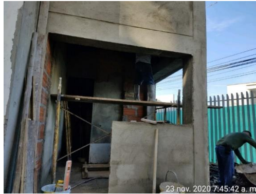
Imagen 22. Aplicación del mortero
