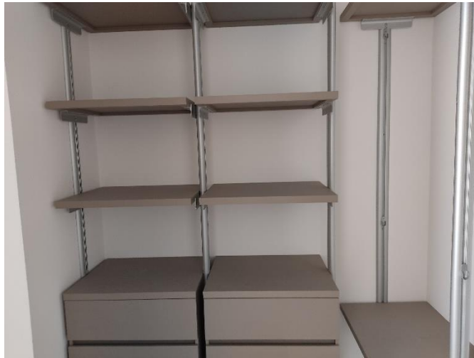
Imagen 29. Instalación carpintería: Closets
