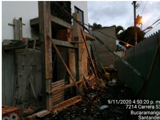
Imagen 18. Fundida de las columnas de la portería
