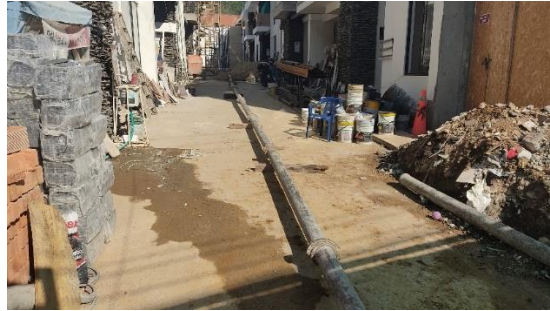
Imagen 46. Tubería para transporte de concreto
