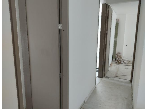
Imagen 30. Instalación de carpintería: Puertas
