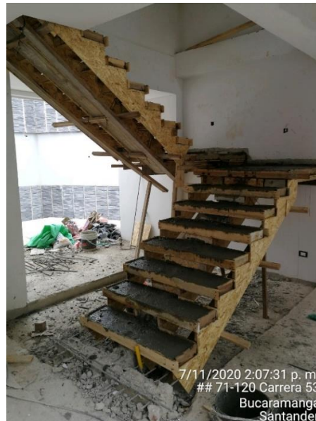
Imagen 14. Fundida de escaleras
