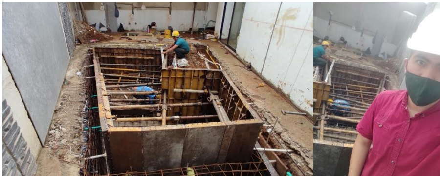
Imagen 45. Armado formaleta piscina
