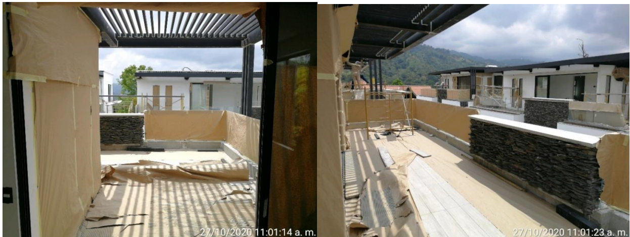
Imagen 23. Instalación de pérgolas
