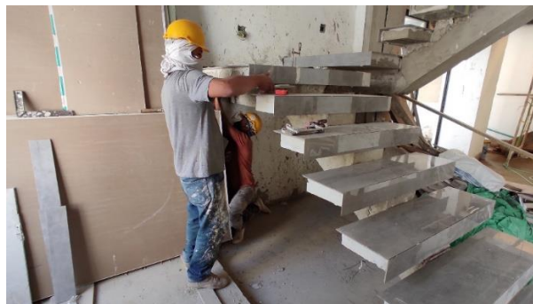
Imagen 15. Enchapado de escaleras
