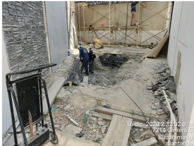
Imagen 9. Demolición de la piscina
