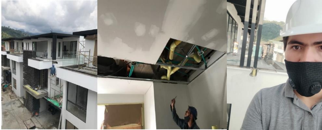
Imagen 24. Instalación de bajante de las pérgolas
