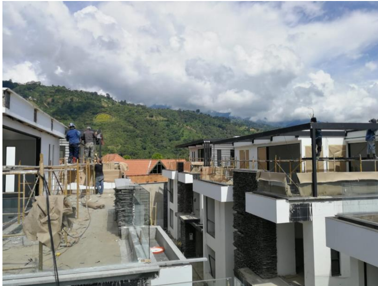
Imagen 4. Instalación de pérgolas de tercer piso
