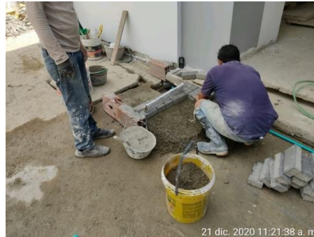
Imagen 34. Instalación de adoquines
