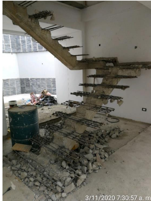
Imagen 12. Demolición de escaleras
