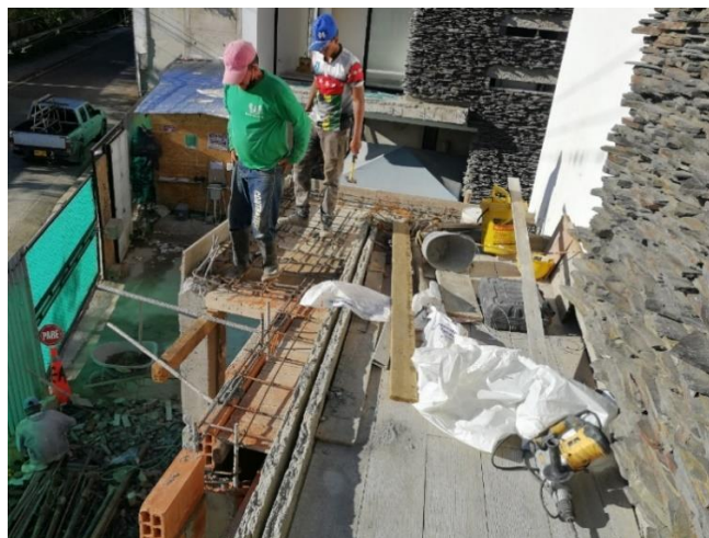
Imagen 19. Armado de formaleta de placa de portería
