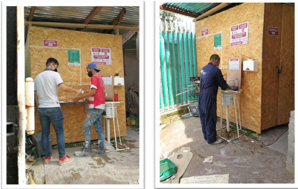
Imagen 53 Ingreso del personal a la obra
