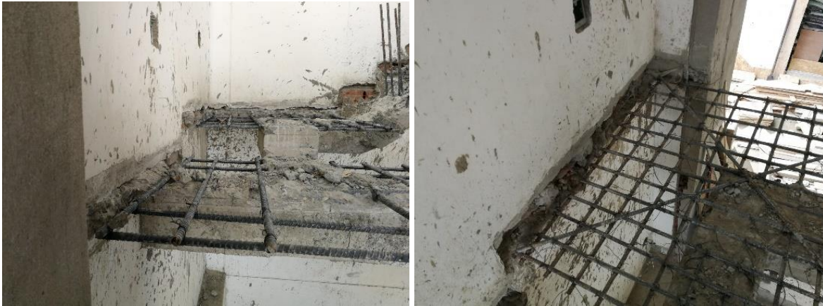
Imagen 6. Anclaje superficial de acero de escaleras
