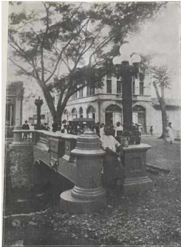
Puente "Baltasar Ochoa" en el paseo de La Playa.
