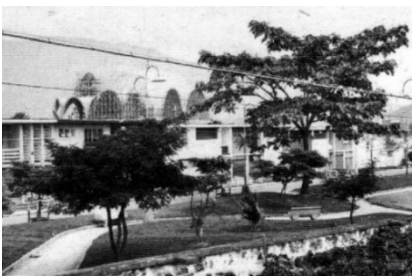
Imagen 20 Barrio Libertadores, Arquitectura moderna en Medellín 1947-1970. (Ortiz et al., 2010)
