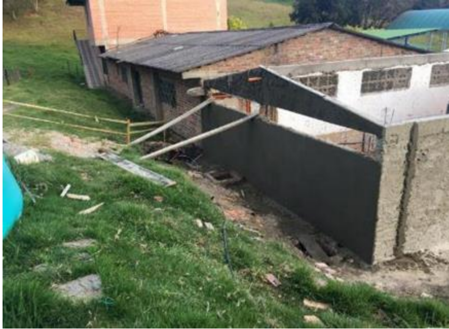
Ilustración 58. Aplicación de pañete impermeabilizado parte posterior baños.
