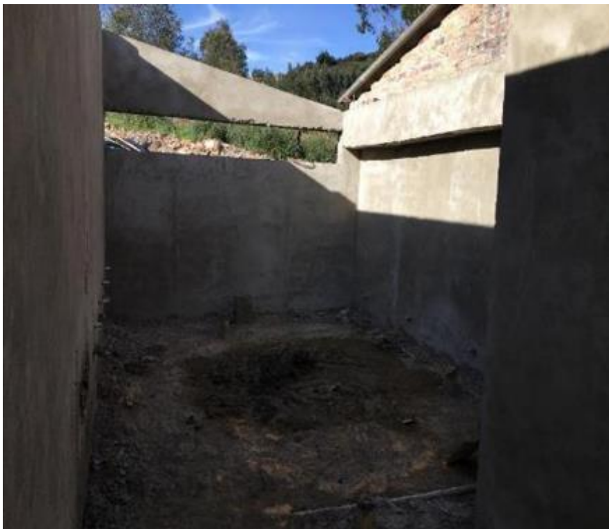
Ilustración 61. Terminación de pañete impermeabilizado baños.
