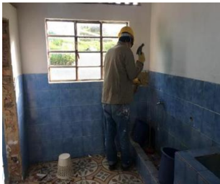
Ilustración 35. Demolición y retiro de enchapes de muros. Fuente: Propia.
