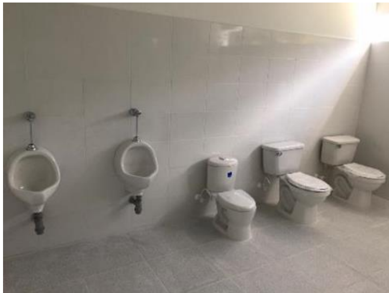
Ilustración 77. Terminaciones enchapes y aparatos sanitarios.
