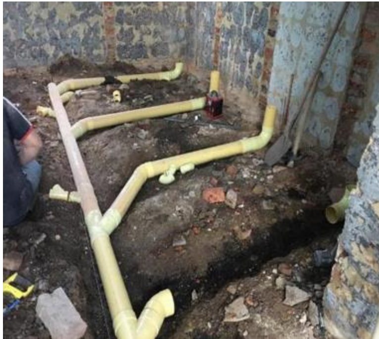
Ilustración 46. Instalación de red sanitaria hacia inodoros.
