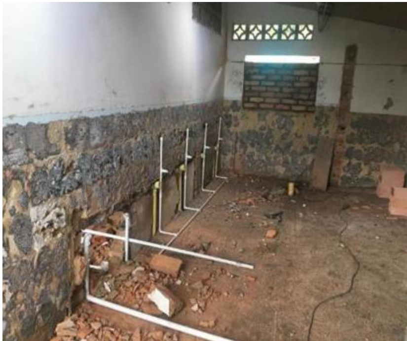
Ilustración 47. Instalación de red hidráulica.
