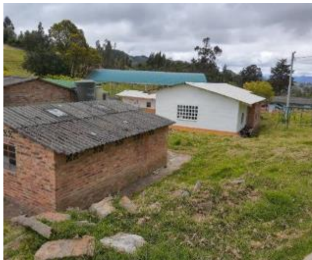
Ilustración 17. Verificación del estado de la parte posterior a la zona de los baños.
