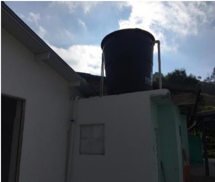
Ilustración 82. Terminaciones e instalación de servicios de agua para suministro a baterías sanitarias.
