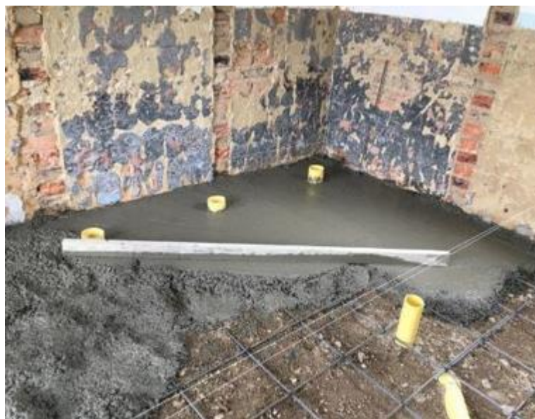
Ilustración 51. Fundida de la placa de contrapiso y nivelación.
