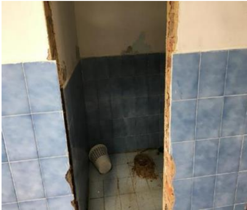
Ilustración 34. Vista del elemento retirado y salida sanitaria o desagüe.
