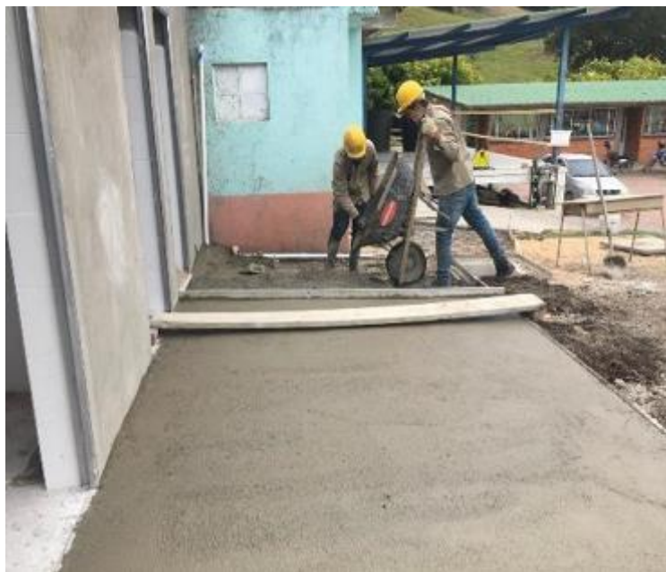
Ilustración 71. Fundida de andén externo a baterías sanitarias. Fuente: Propia.
