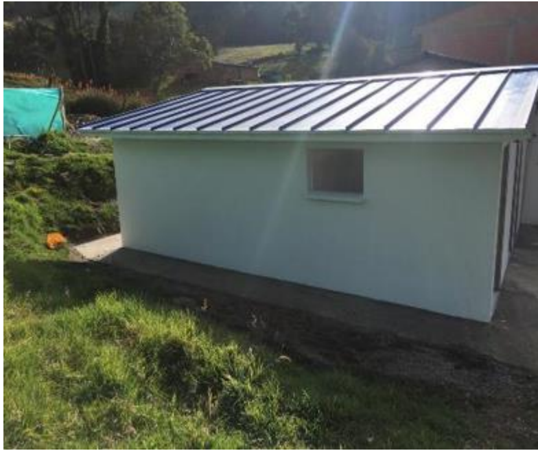
Ilustración 74. Acabado final parte lateral izquierda baterías sanitarias.
