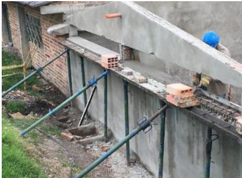
Ilustración 64. Fundida de alfaja en concreto reforzado.
