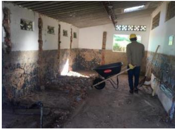
Ilustración 41. Limpieza y transporte del material de demolición.
