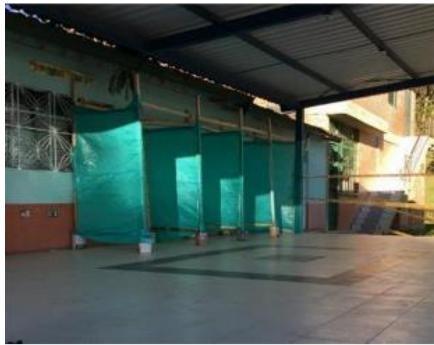
Ilustración 26. Instalación de vestieres bioseguros.
