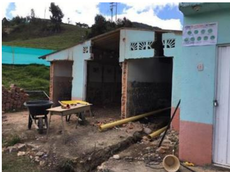
Ilustración 45. Instalación de tubería sanitaria en pvc.
