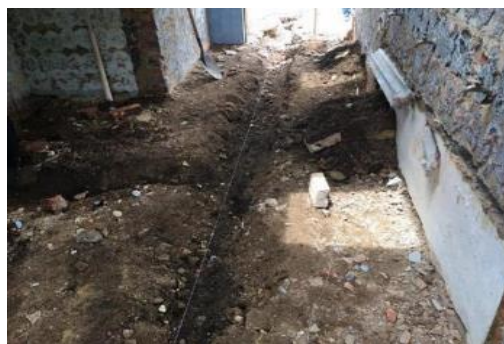
Ilustración 43. Excavación en material común de zanjas para la instalación de tubería sanitaria.
