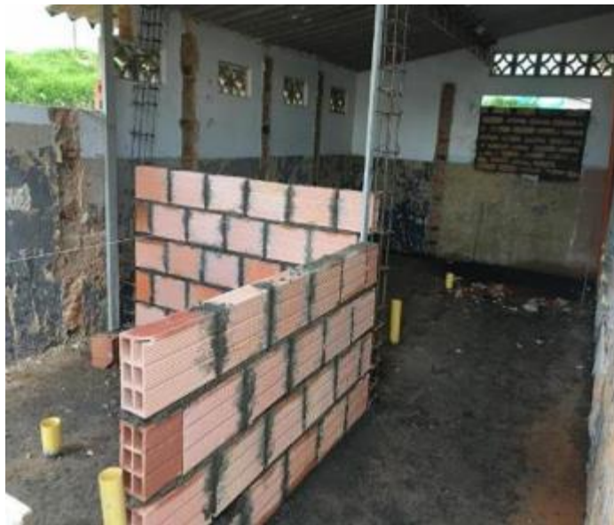
Ilustración 52. Instalación de mampostería confinada en ladrillo H-10..
