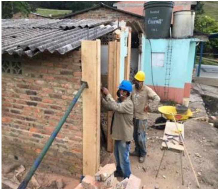
Ilustración 49. Armado de formaleta y fundida del elemento en concreto reforzado.
