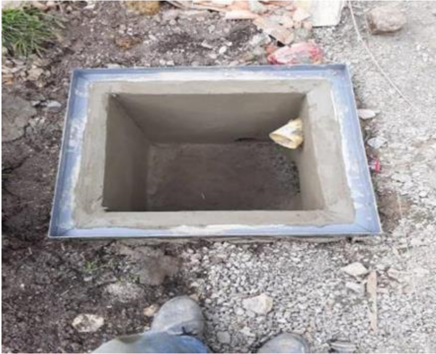
Ilustración 62. Aplicación pañete impermeabilizado caja de inspección sanitaria. Fuente: Propia.
