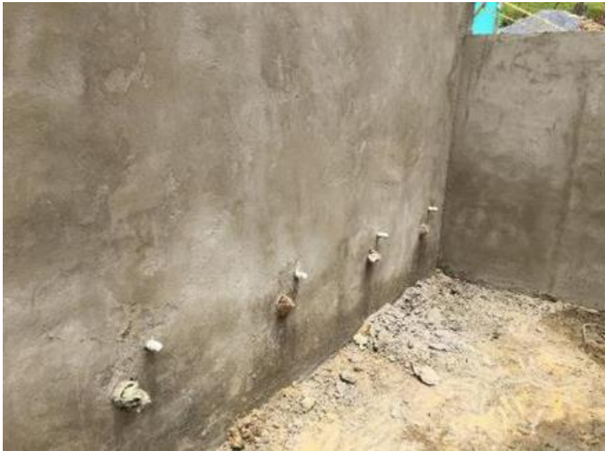
Ilustración 60. Aplicación de pañete impermeabilizado zona interna baterías sanitarias.
