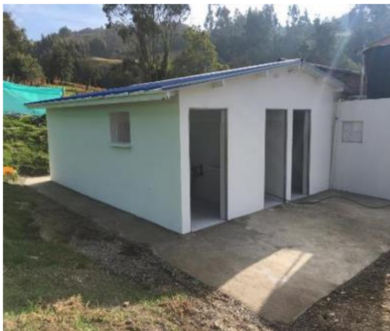
Ilustración 73. Acabado final parte frontal baterías sanitarias.
