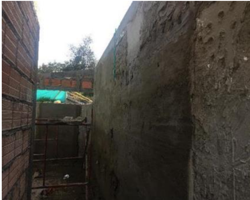
Ilustración 59. Aplicación de pañete impermeabilizado zonas internas.
