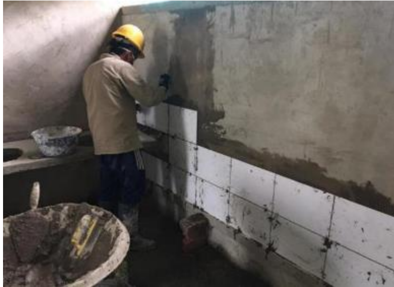
Ilustración 70. Instalación de enchapes y verificación de alineamientos. Fuente: Propia.
