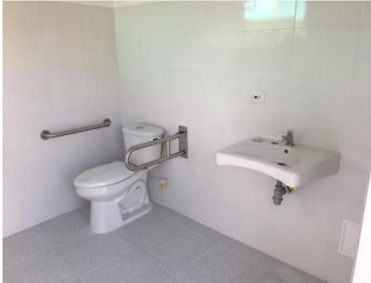
Ilustración 76. Terminaciones baño discapacitados.
