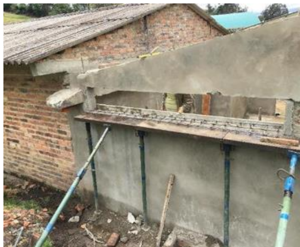
Ilustración 63. Figurado e instalación de acero de refuerzo alfajía.
