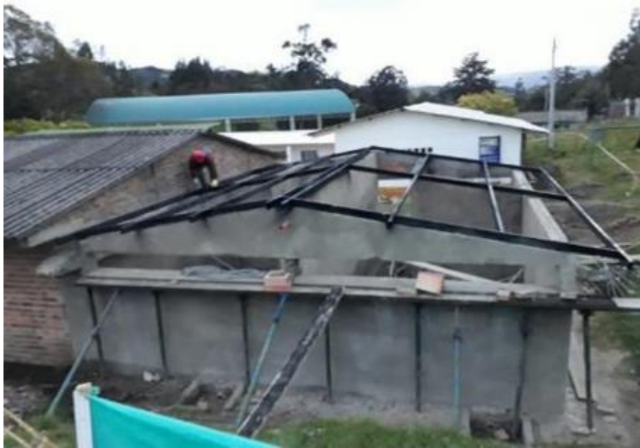
Ilustración 66. Perfiles metálicos de la cubierta o techo. Fuente: Propia.
