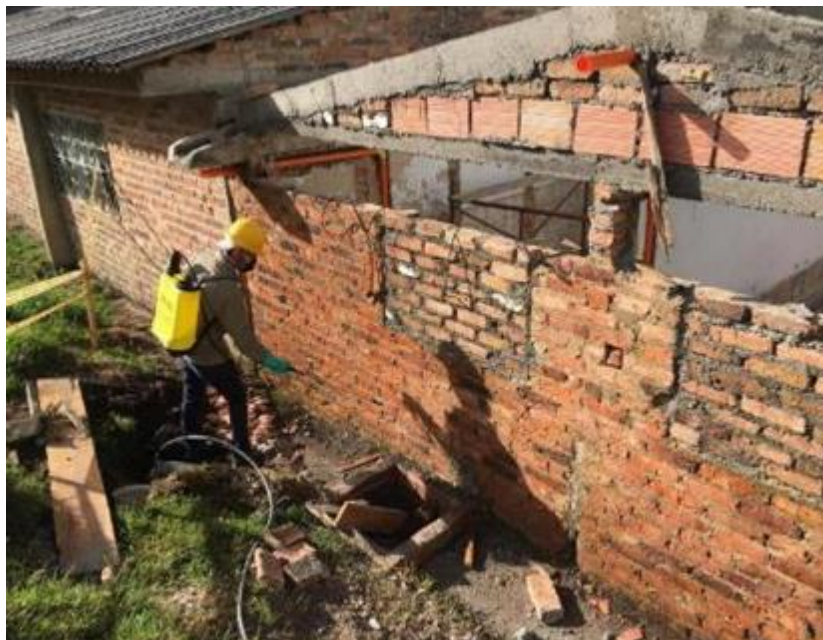
Ilustración 55. Instalación en cerramientos de mampostería en ladrillo tolete.
