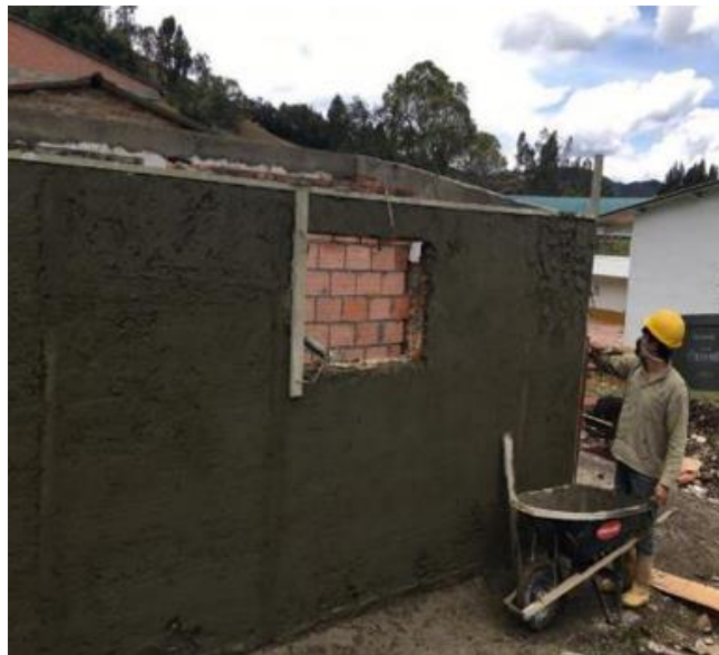
Ilustración 57. Aplicación de pañete impermeabilizado.
