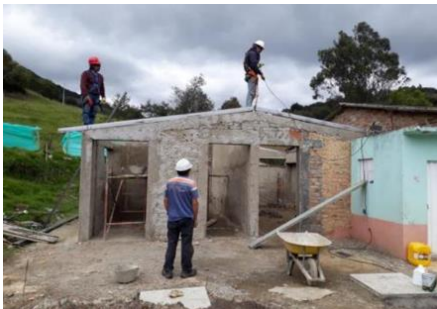
Ilustración 65. Instalación de cubierta metálica galvanizada. Fuente: Propia.
