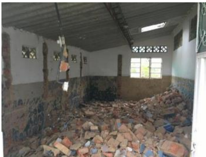
Ilustración 40. Demolición final de los elementos que conforman el baño.
