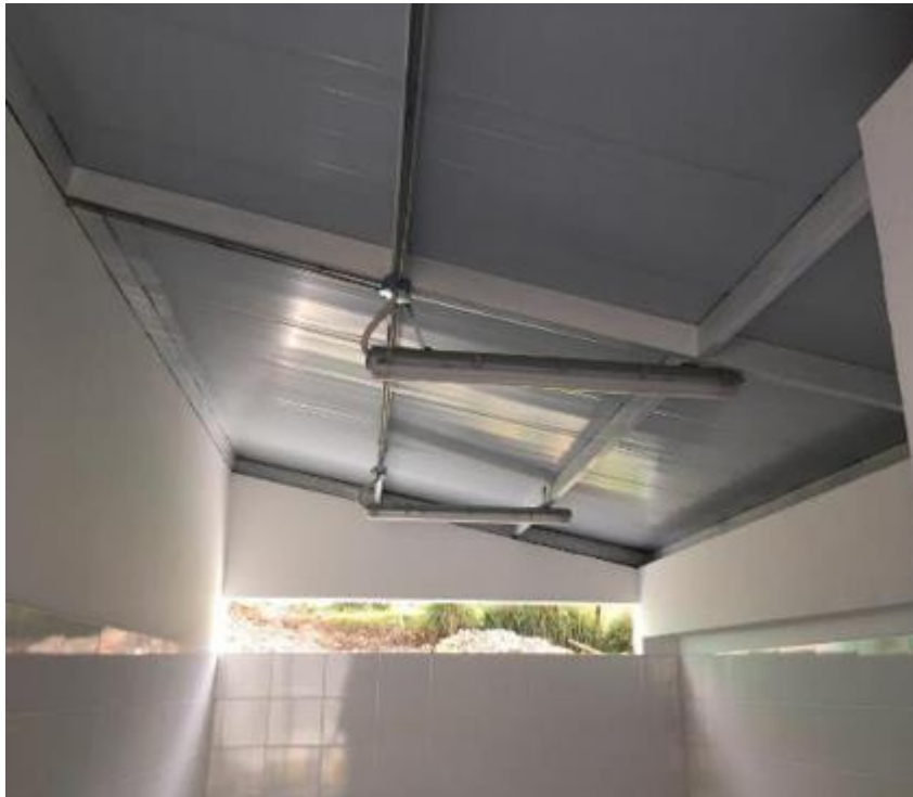
Ilustración 80. Terminaciones de cubierta e instalación de luminarias.
