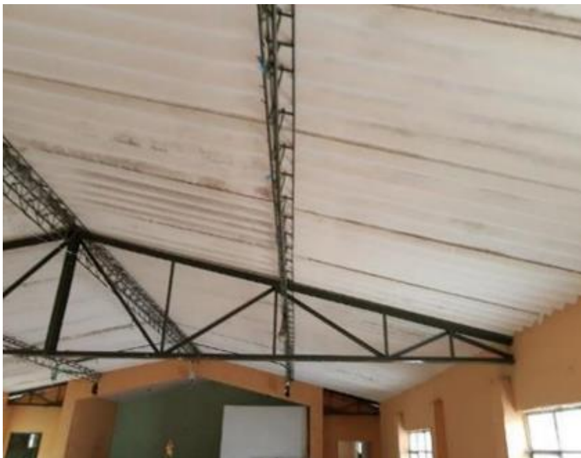
Ilustración 22. Elementos o vigas de soporte de la cubierta.
