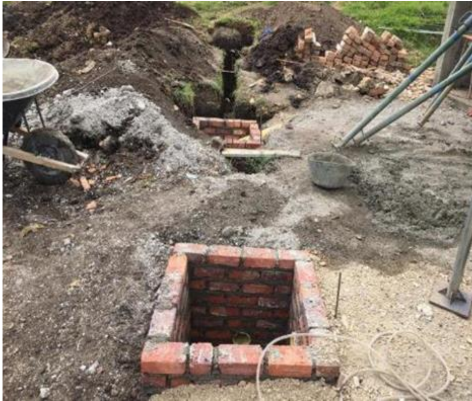
Ilustración 56. Fabricación de cajas de inspección en ladrillo tolete.
