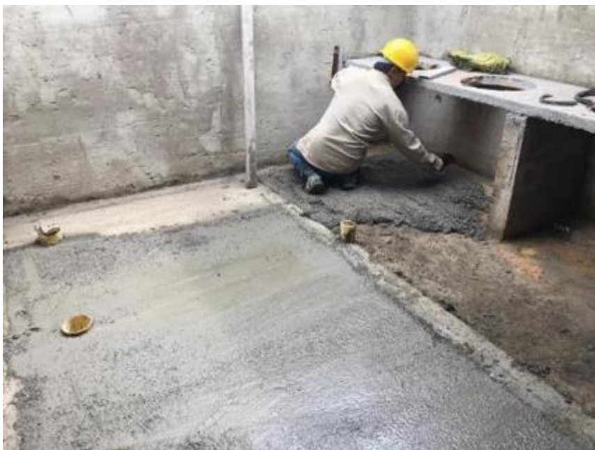
Ilustración 67. Aplicación del mortero de nivelación.
