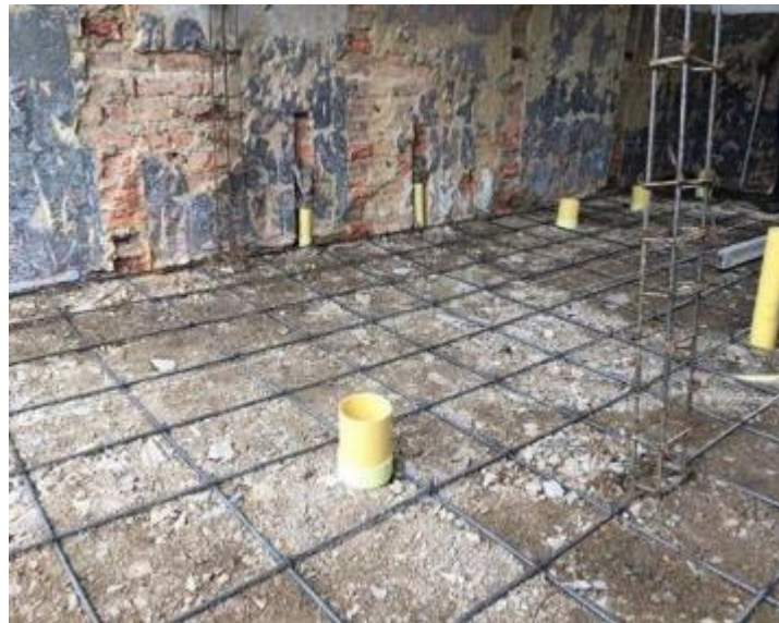
Ilustración 50. Instalación y armado del acero de refuerzo para placa de contrapiso.
