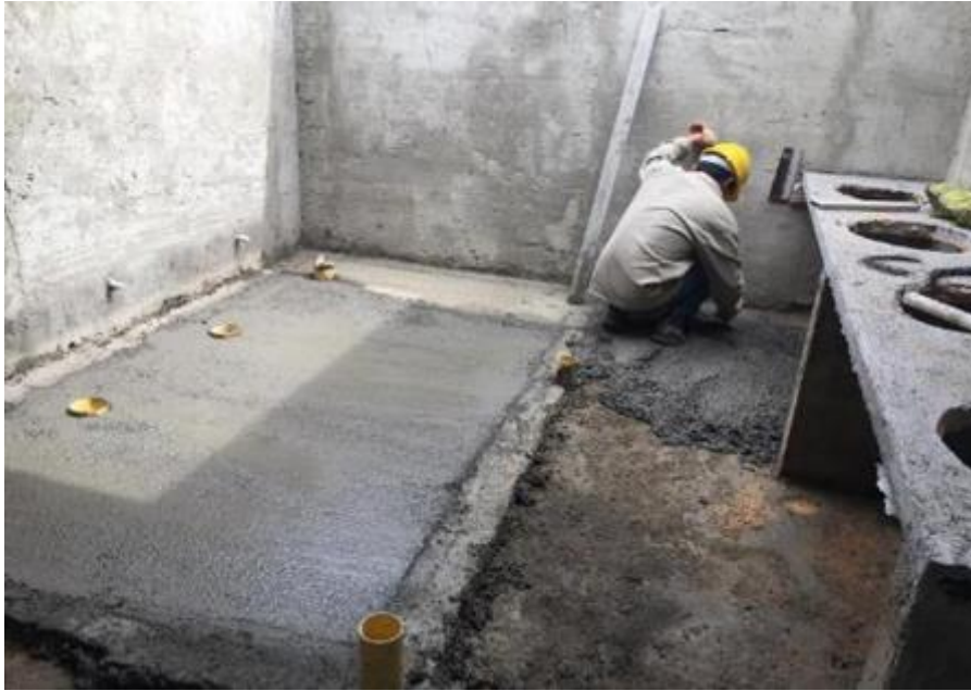
Ilustración 68. Aplicación y nivelación del mortero de piso.
