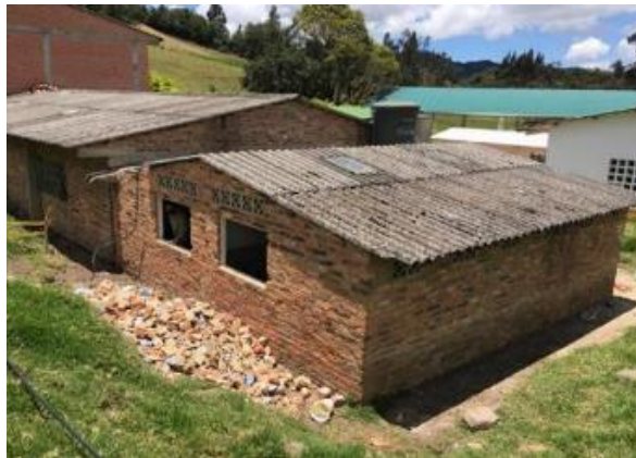
Ilustración 42. Disposición de materiales de demolición fuera del área de trabajo.
