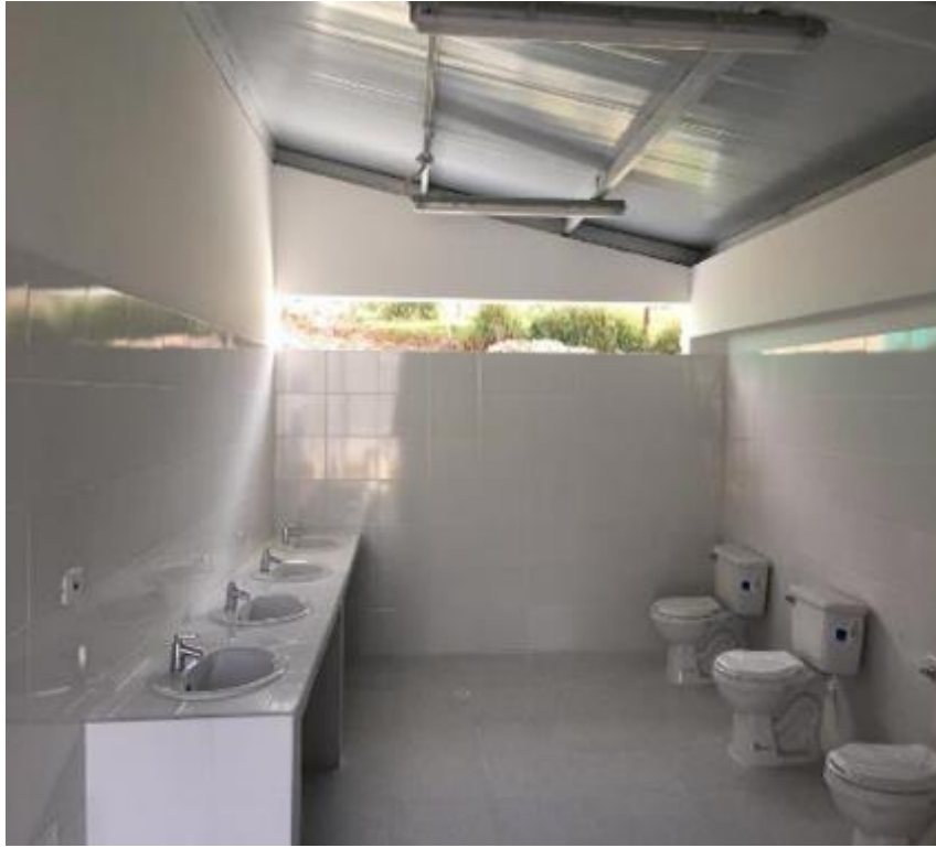
Ilustración 79. Terminaciones cubiertas metálica galvanizada.
