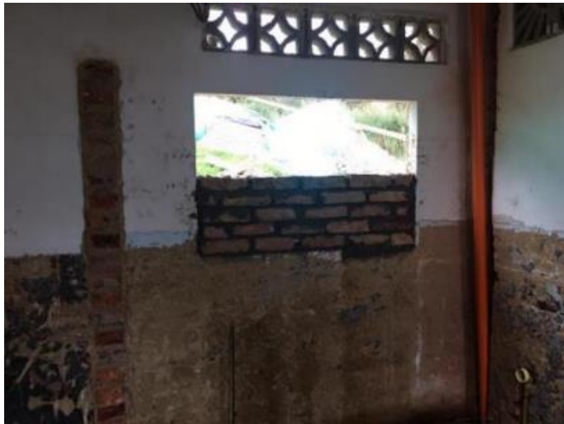
Ilustración 54. Instalación de ladrillo tolete para cerramiento.
