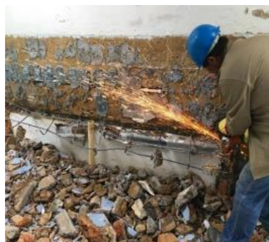
Ilustración 38. Corte de acero de elementos estructurales.
