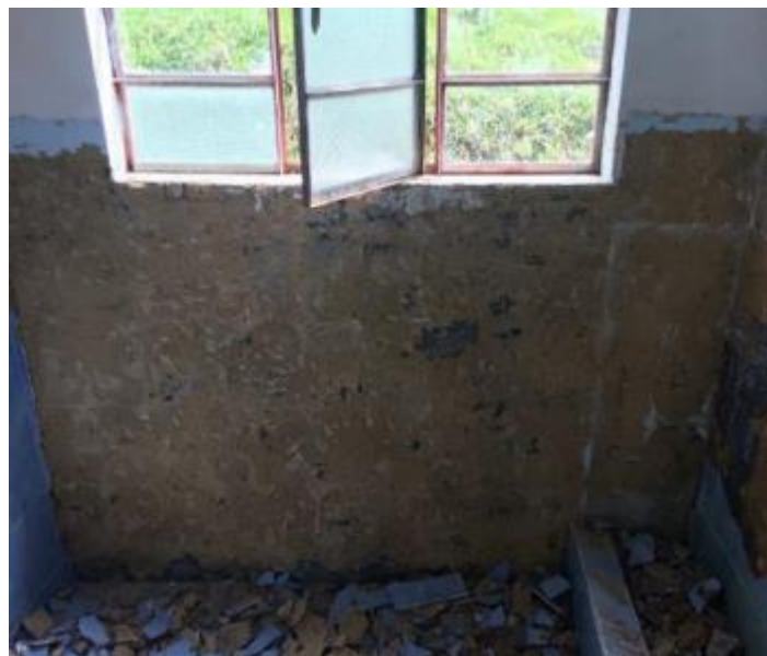
Ilustración 36. Retiro de enchapes de muros.
