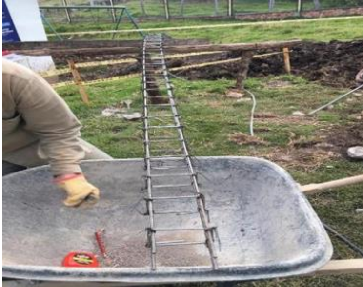
Ilustración 48. Armado y figurado de acero para columnas.
