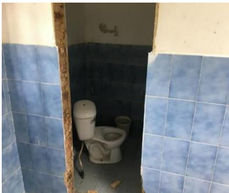
Ilustración 33. Desmonte de aparatos sanitarios baño de niños. Fuente: Propia.
