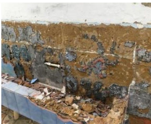
Ilustración 37. Demolición de orinales o lavamanos corrido.
