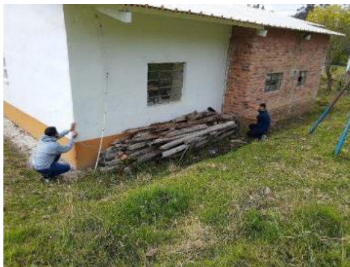
Ilustración 20. Visualización y verificación de niveles desde batería sanitaria a posible punto de pozo séptico.
