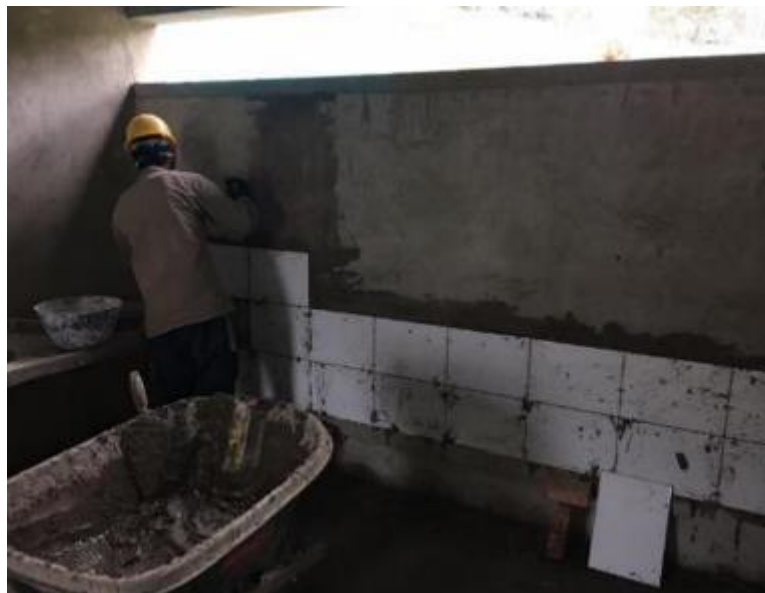
Ilustración 69. Instalación de cerámicas o enchapes. Fuente: Propia.
