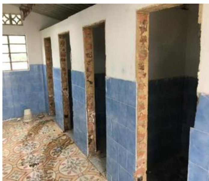
Ilustración 31. Desmonte de puertas de las baterías sanitarias.
