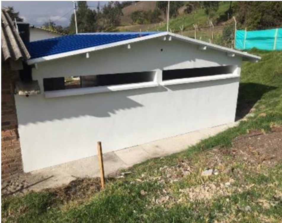
Ilustración 75. Acabado final y vista parte trasera baterías sanitarias.
