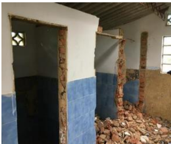
Ilustración 39. Demolición de muros en mampostería no estructural.
