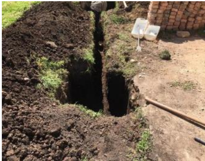
Ilustración 44. Excavación en material común para la construcción de cajas de inspección sanitarias.
