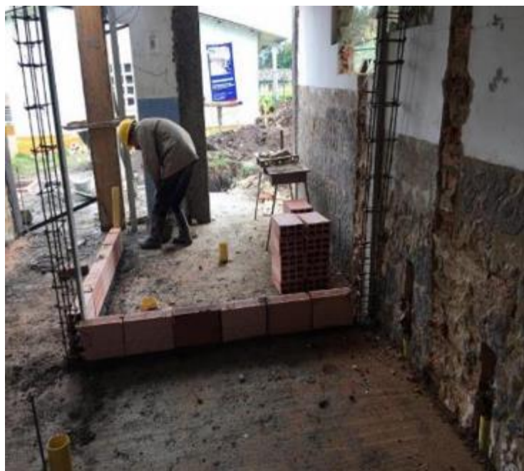
Ilustración 53. Replanteo para la instalación de mampostería confinada.
