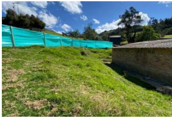
Ilustración 28. Cerramientos en lona verde para el aislamiento de las labores.
