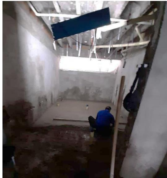
Fotografía 34. Mortero para nivelación de piso.
