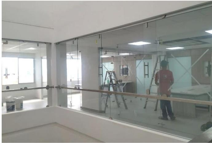
*Fotografía 19. Ventanas en cristal templado con montante inferior para cerramiento de vacío interior.*
