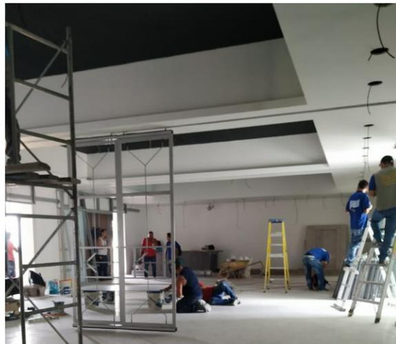
*Fotografía 7. Instalación de lámparas incrustadas en cielo raso.*
