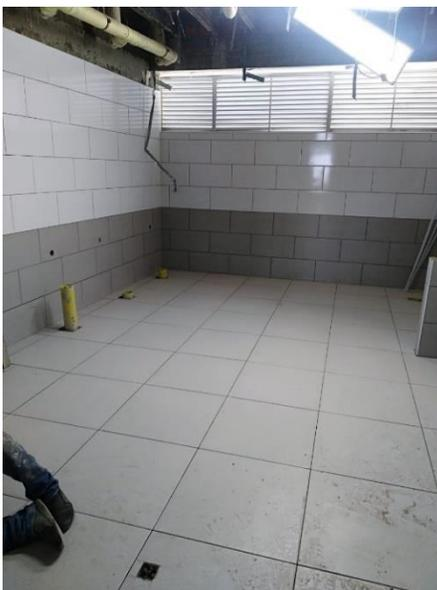
*Fotografía 37. Enchape muros y piso baño.
