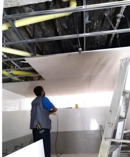
*Fotografía 42. Instalación cielo raso en Superboard. Fuente: Propia.*
