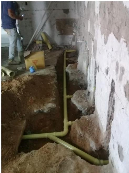
*Fotografía 31. Instalación de tubería para puntos hidráulicos aparatos sanitarios.*
