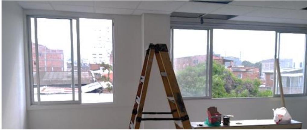
*Fotografía 20. Ventanas corredizas en aluminio y cristal de 6mm para cafetería.*
