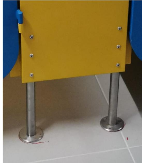
Fotografía 47. Detalle anclaje de división a piso con soporte en acero inoxidable. Fuente: Propia.
