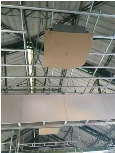
*Fotografía 3. Perfilera metálica para soporte de cielo raso auditorio mayor. Fuente: Propia.*
