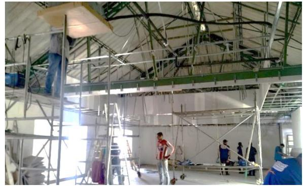
*Fotografía 2. Estructura metálica construida para soporte de cielo raso auditorio mayor. Fuente: Propia.*
