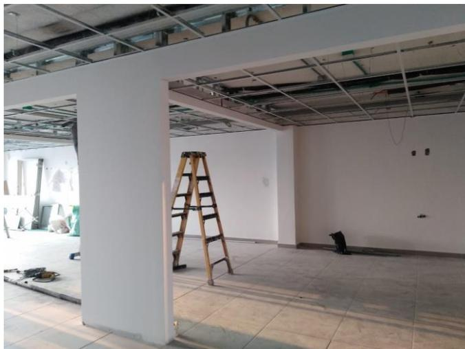
*Fotografía 11. Muro y dinteles en Drywall. Piso 3. Edificio Carrera 11*
