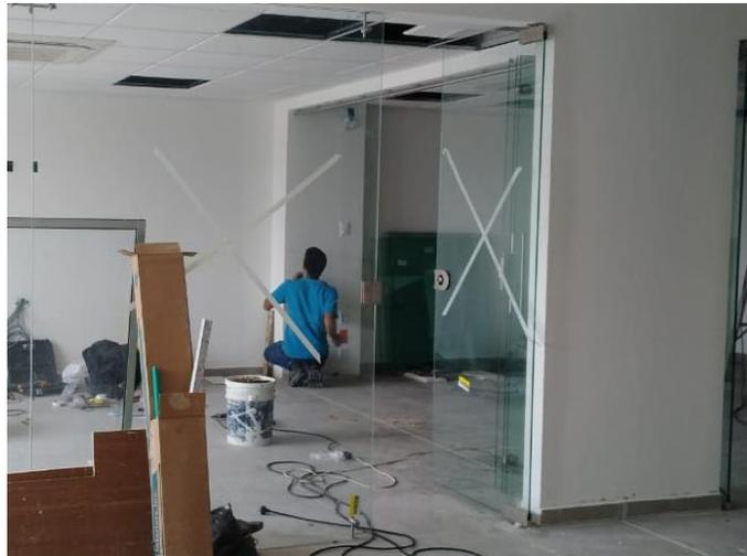
*Fotografía 17. Instalación de cristal templado para separación de salas. Fuente: Propia.*
