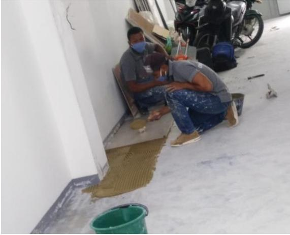
Fotografía 27. Instalación de enchape piso 1. Fuente: Propia.
