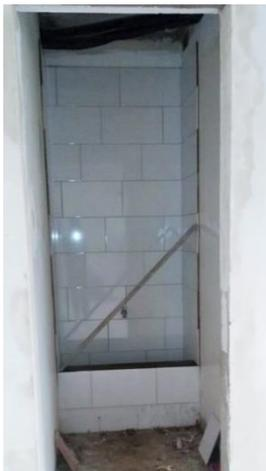
Fotografía 15. Instalación de enchape cuarto de aseo. Fuente: Propia.
