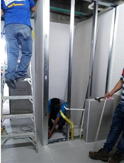
*Fotografía 41. Instalación estructura muros Superboard para baños docentes. Fuente: Propia.*
