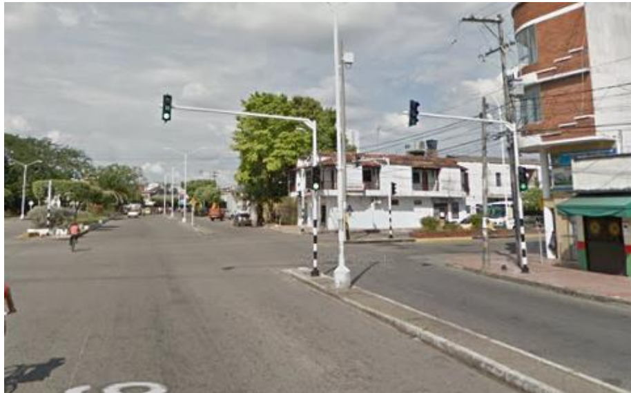
Figura 20. Semáforo cruce calle 52 con Cra 28
