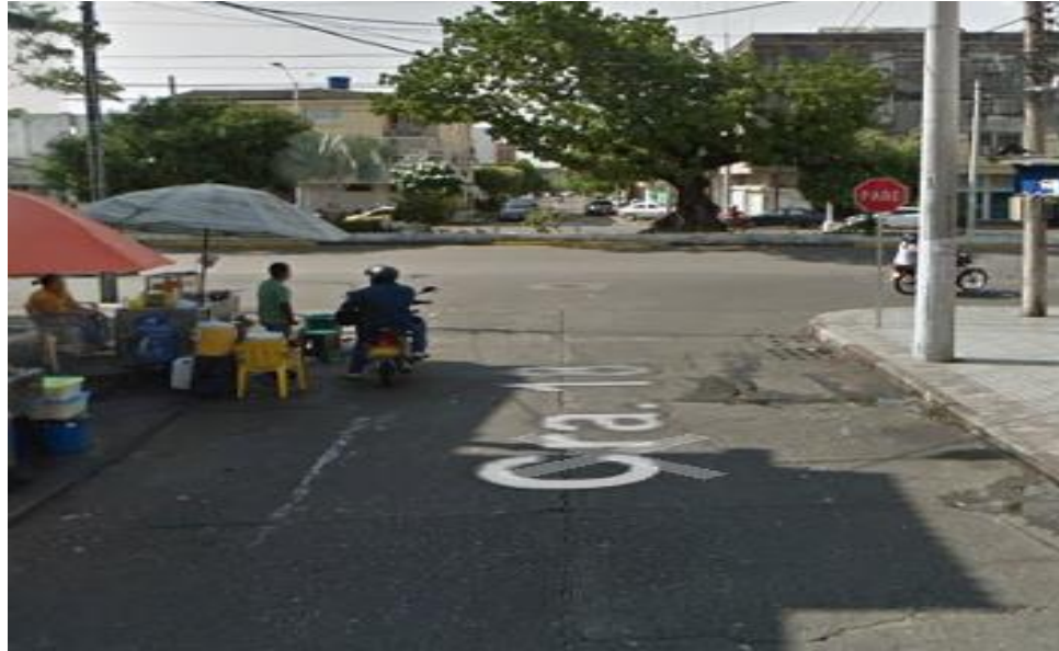
Figura 23. Semáforo cruce calle 52 con Cra 18
