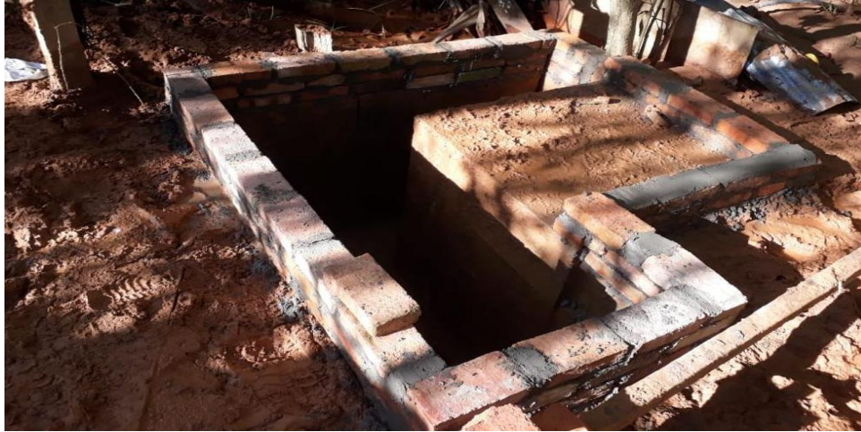
Ilustración 4 Cerramiento del pozo de agua
