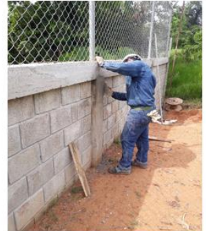
Frisado de columnas de cerramiento
