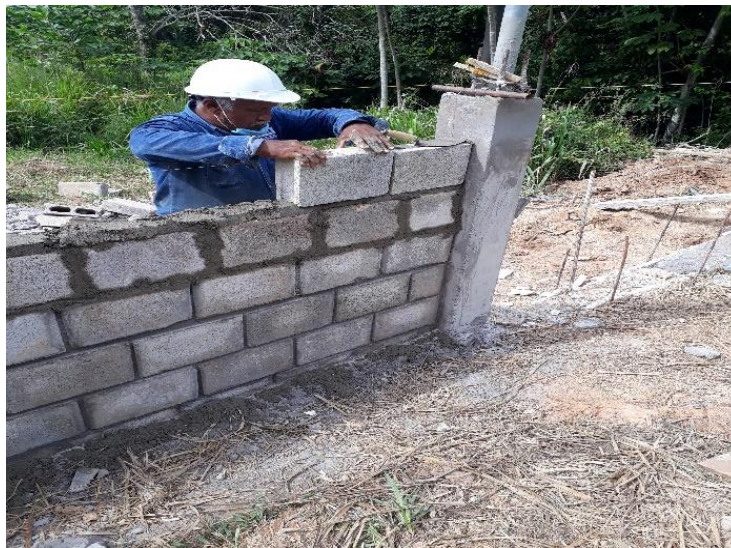
Ilustración 16 Avance de mampostería
