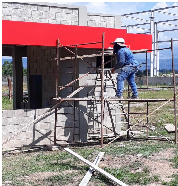
Ilustración 19 Supervisión de acabados de la caseta de acceso
