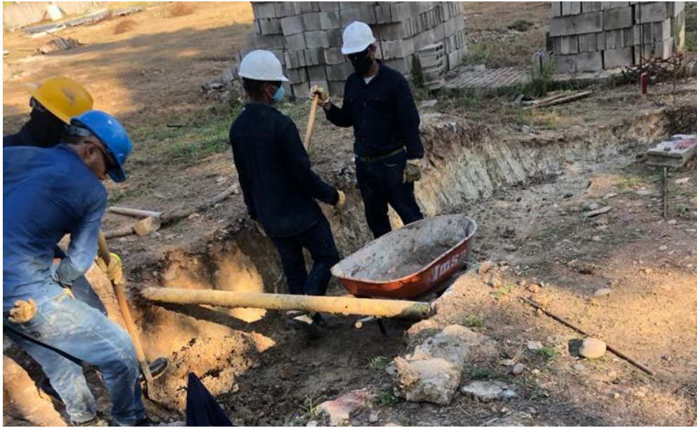
Ilustración 10 Excavación para viga de cimentación
