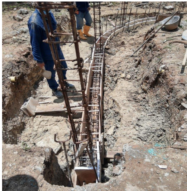
Ilustración 13 Instalación de acero en viga de cimentación, zapatas y columnas
