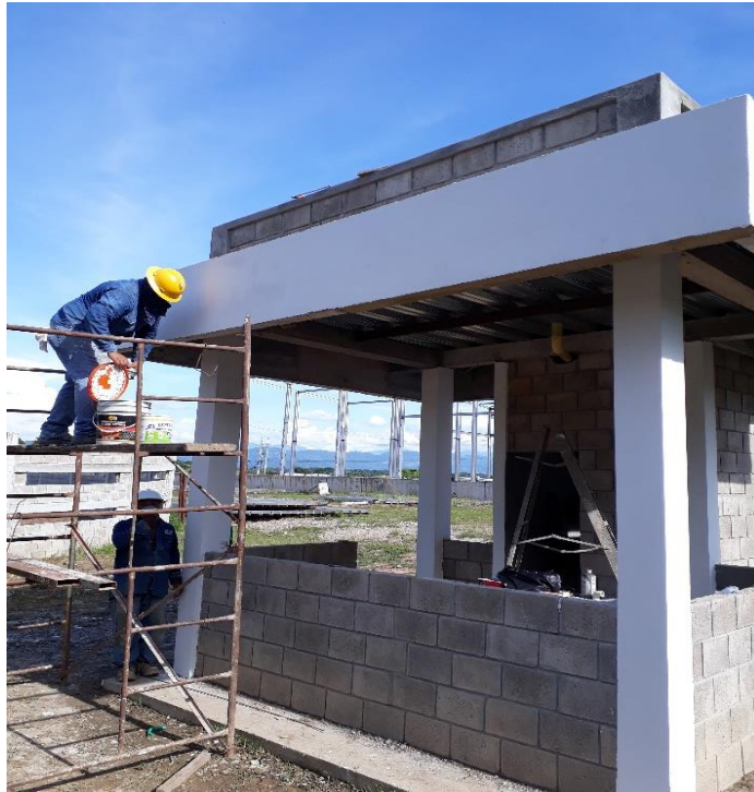
Ilustración 18 Estucado de muro pantalla y columnas
