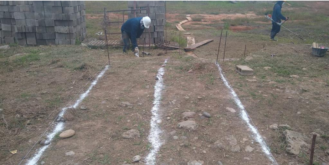
Ilustración 9 Localización y replanteo de cimentación
