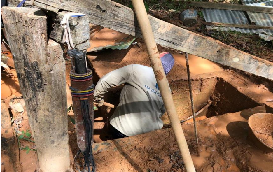
Ilustración 3 Destape del pozo de agua
