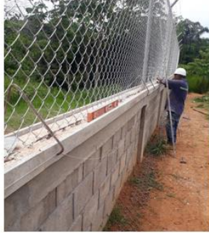
Mortero para cubrir la soldadura de la malla con la viga
