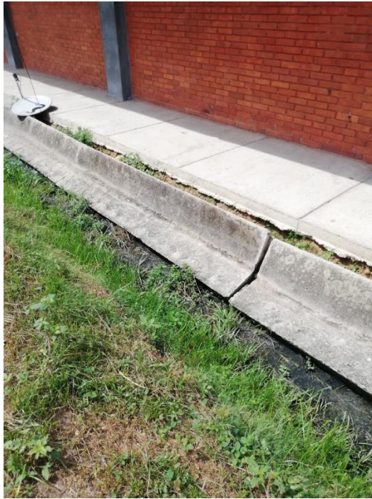
Imagen 83 - Cunetas perimetrales alojamientos BITER 5
