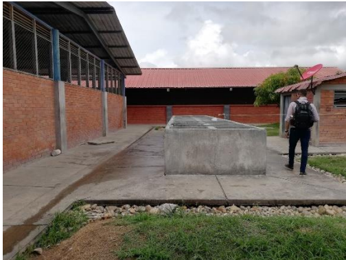
Imagen 80 - Lavaderos alojamientos BITER 5 Fuente: Sección técnica - Batallón de Ingenieros N°5 CR Francisco José de Caldas
