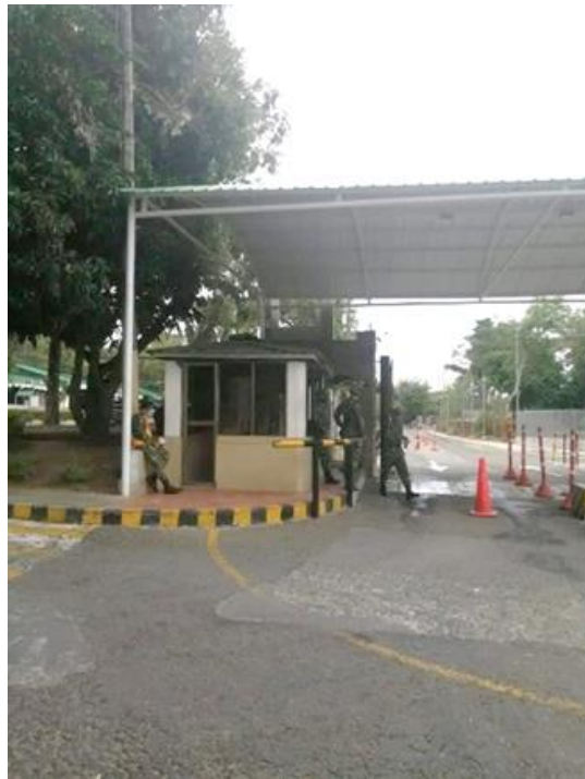
Imagen 29 – Guardia - Batallón de Ingenieros N°5 Fuente: Sección técnica - Batallón de Ingenieros N°5 CR Francisco José de Caldas
