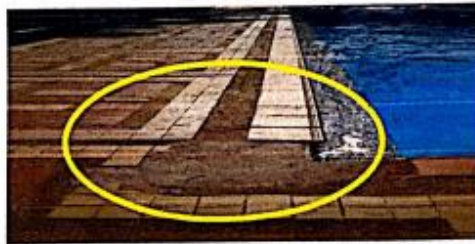
Imagen 55 - Desprendimiento de enchape interior y exterior de la piscina del Batallón Nueva Granada Fuente: Sección técnica - Batallón de Ingenieros N°5 CR Francisco José de Caldas
