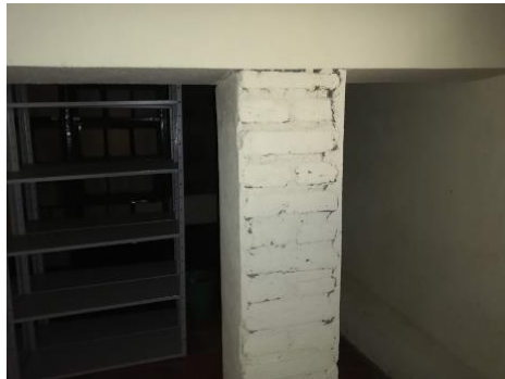
Imagen 66 - Estructura soporte de la estructura de madera del Archivo General Quinta Brigada Fuente: Sección técnica - Batallón de Ingenieros N°5 CR Francisco José de
