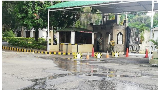
Imagen 27 - Entrada Principal de la Guardia - Batallón de Ingenieros N°5 Fuente: Sección Técnica – Batallón de Ingenieros N°5 CR Francisco José de Caldas
