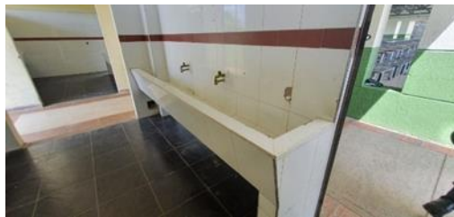
Imagen 46 - Grifería de los lavaplatos en el rancho de tropas BITER 5 Fuente: Sección técnica - Batallón de Ingenieros N°5 CR Francisco José de Caldas
