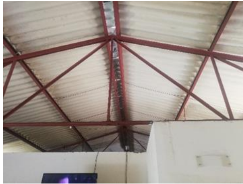
Imagen 14 - Cubierta bloque de oficinas y alojamientos - Batallón de Ingenieros N°5 Fuente: Sección técnica - Batallón de Ingenieros N°5 CR Francisco José de Caldas
