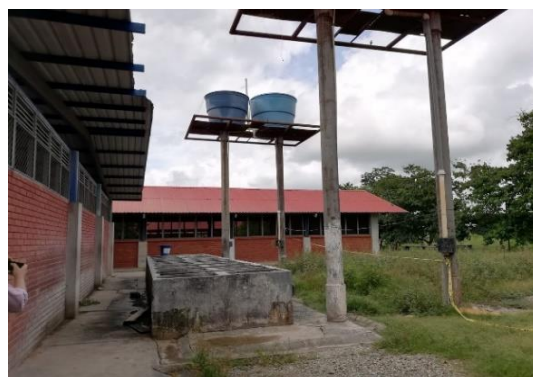
Imagen 82 - Lavaderos segundo bloque de alojamientos BITER 5 Fuente: Sección técnica - Batallón de Ingenieros N°5 CR Francisco José de Caldas
