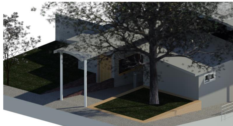
Imagen 33 - Instalaciones de la guardia ampliada con cubierta en el pasillo - Batallón de Ingenieros N°5 Fuente: Sección técnica - Batallón de Ingenieros N°5 CR Francisco José de Caldas
