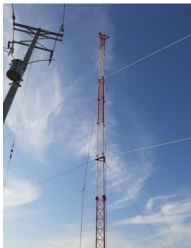
Figura 13. Montaje de la torre Puerto Mosquito, Cesar. Fuente: (Mankco S.A.S., 2021)
