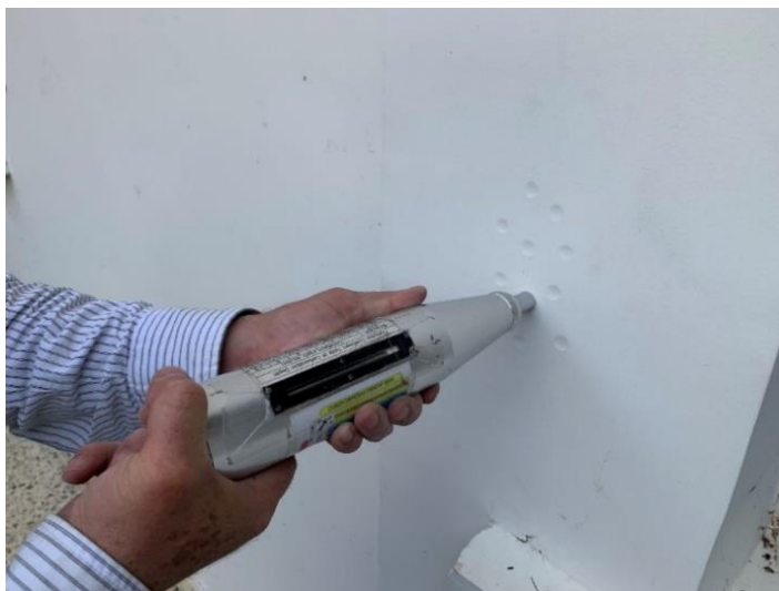
Figura 28. Prueba de esclerómetro, edificación Charalá, Santander. Fuente: (Mankco S.A.S., 2021)
