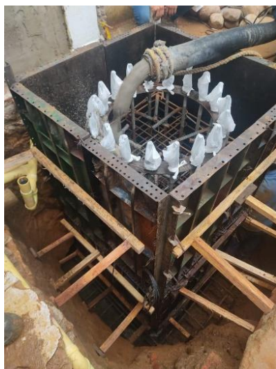
Figura 16. Armado de las formaletas y fundida de concreto. Fuente: (Mankco S.A.S., 2021)
