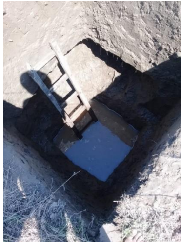
Figura 10. Excavación a 3 metros de profundidad en Gamarra, Cesar. Fuente: (Mankco S.A.S., 2021)
