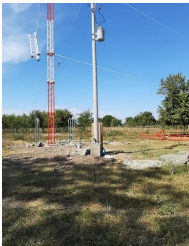
Figura 14. Obra JCES Puerto Mosquito a la fecha. Fuente: (Mankco S.A.S., 2021)
