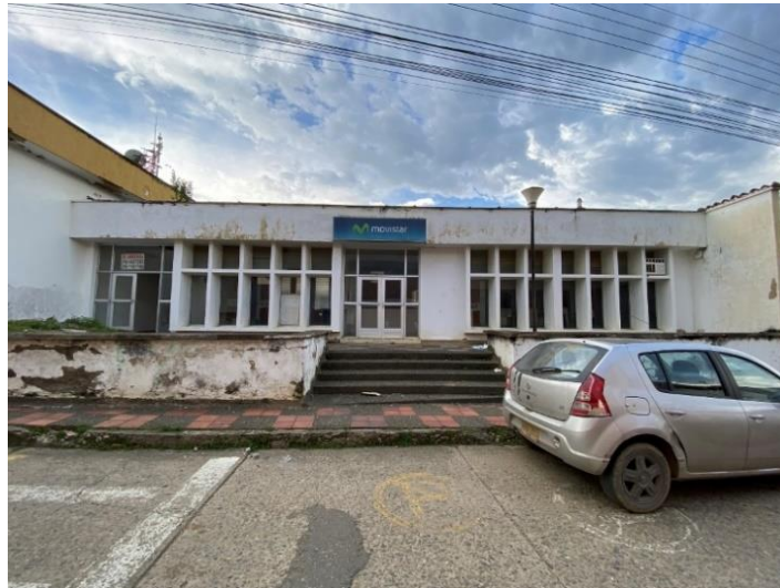
Figura 27. Edificación en Charalá, Santander. Fuente: (Mankco S.A.S., 2021)
