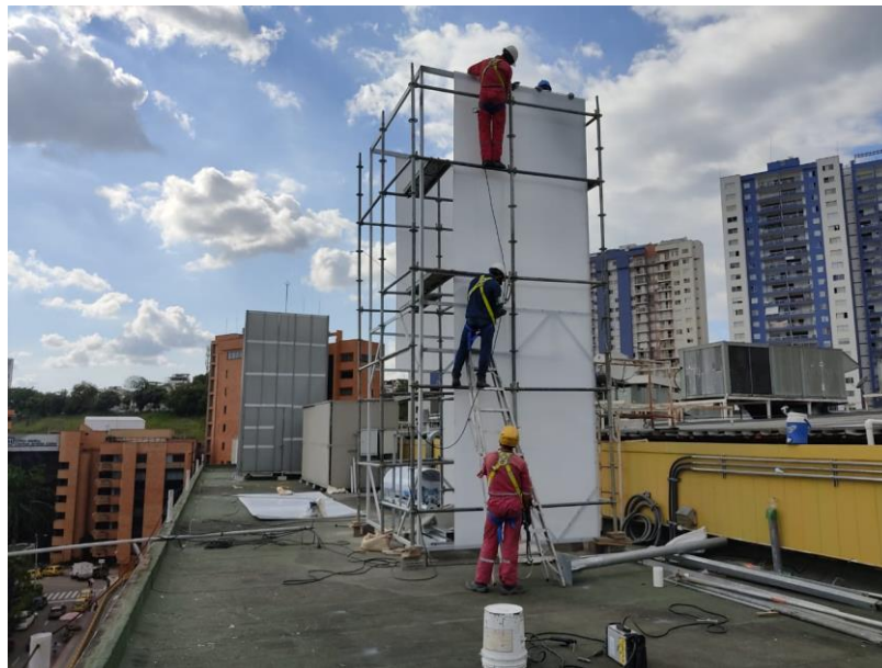
Figura 22. Montaje estructura del mimetizado. Fuente: (Mankco S.A.S., 2021)
