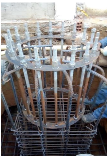
Figura 15. Armado de acero y colocación de plantillas. Fuente: (Mankco S.A.S., 2021)
