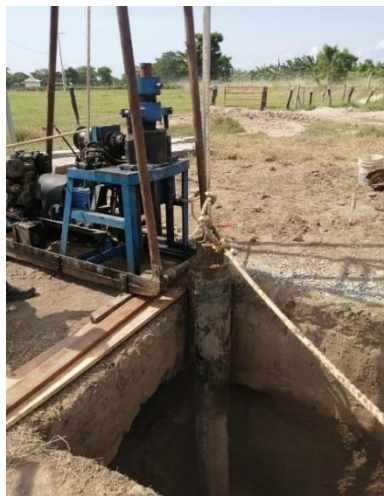
Figura 11. Proceso de hincado de los postes Gamarra, Cesar. Fuente: (Mankco S.A.S., 2021)
