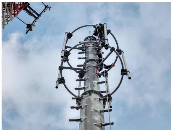
Figura 18. Instalación de soporte tipo anillo en Monopolo. Fuente: (Mankco S.A.S., 2021)
