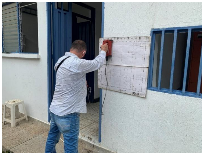
Figura 29. Prueba de ferroskan, edificación Charalá, Santander. Fuente: (Mankco S.A.S., 2021)
