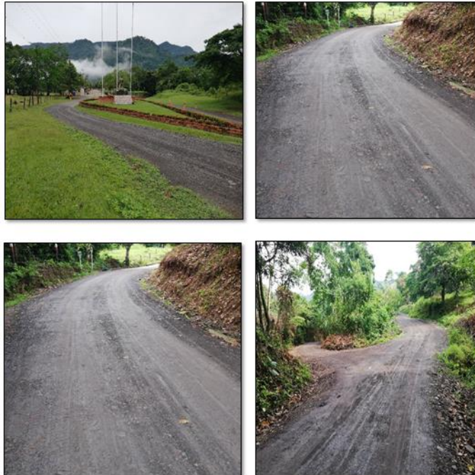
Ilustración 18. Condiciones actuales del tramo vial
