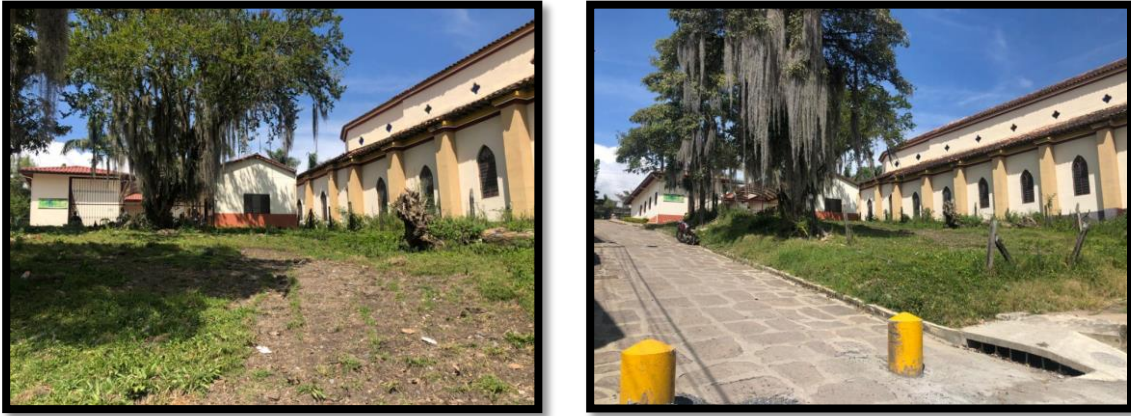
Ilustración 11. Estado actual de la zona donde se realizara el proyecto
