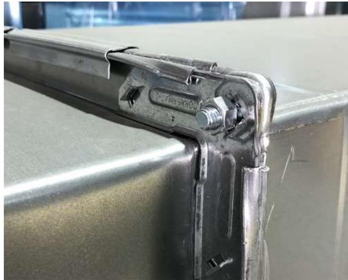
Imagen 23. Pieza esquinera en ducto de ventilación.
