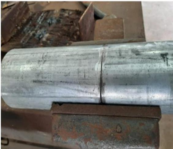
Figura No 13 Limpieza y unión de bisel antes de aplicar soldadura
