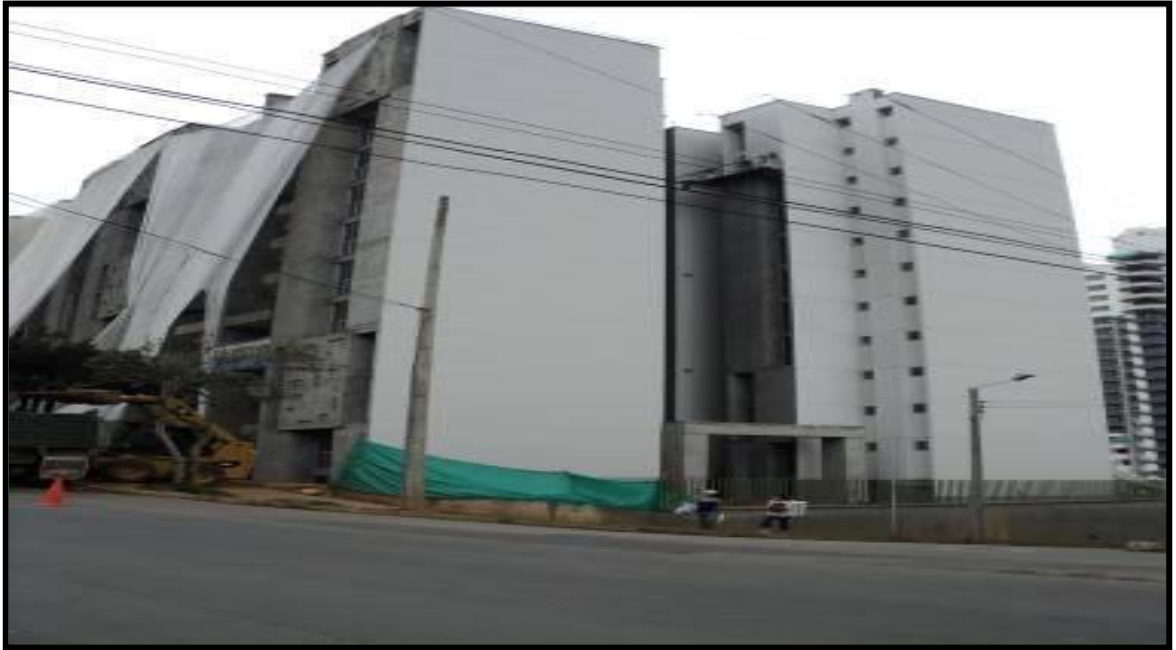
AVANCE EN GRANIPLAX EN LA TORRE 1
