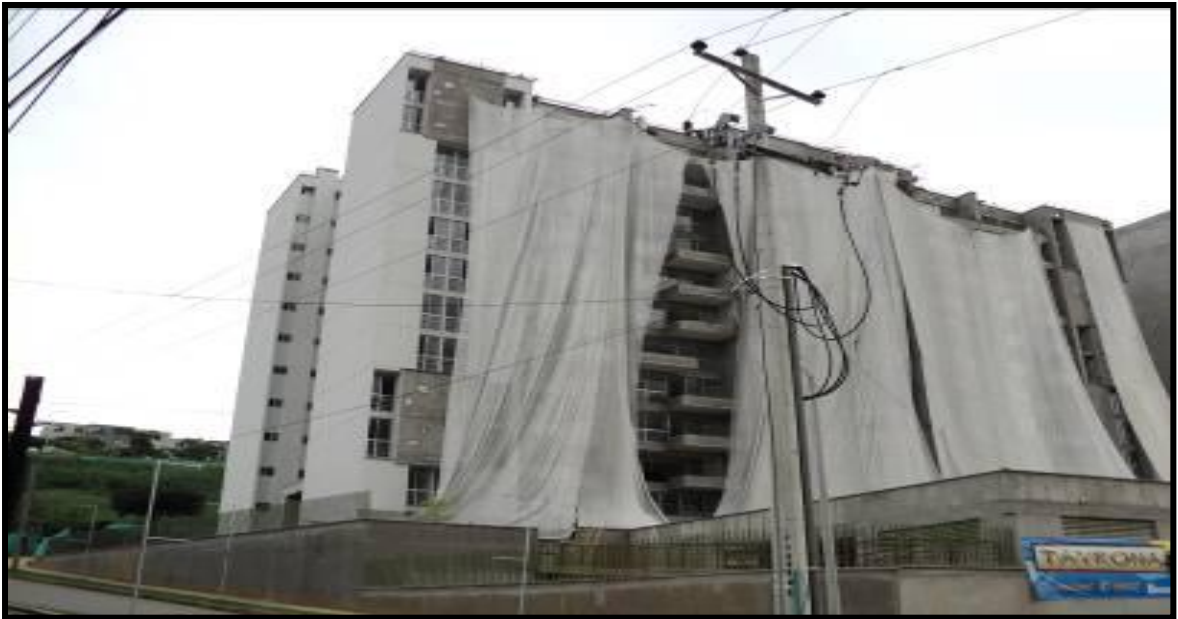
INSTALACION VENTANERIA Y PASA MANOS (AVANCE 100%) TORRES 1 Y 2 FACHADA PRINCIPAL
