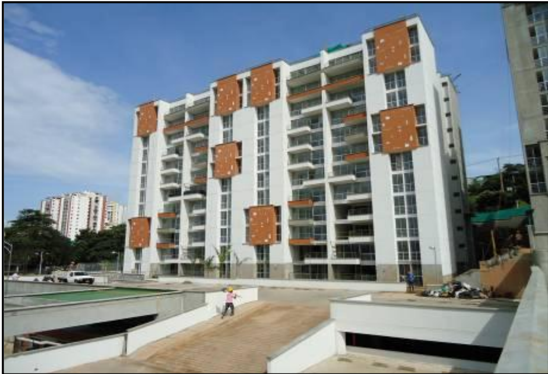
FACHADA DE LAS TORRES EN OBRA
