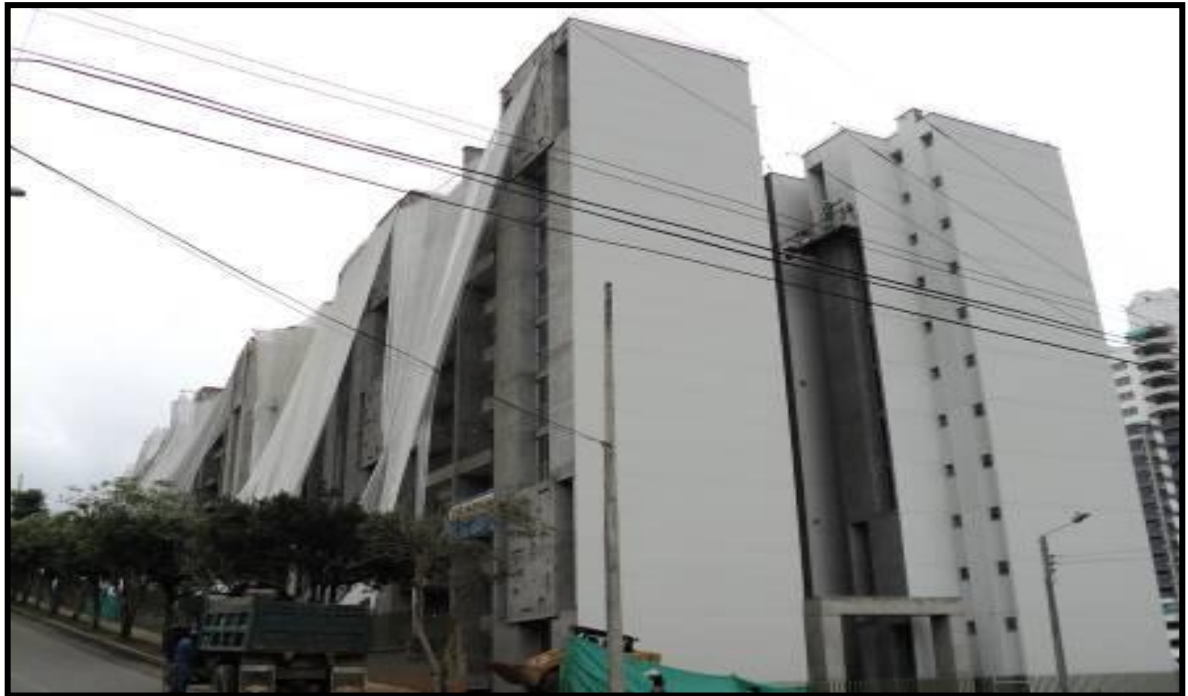
AVANCE FRISO, VENTANERIA TORRES COSTADO NOR-OCCIDENTAL
