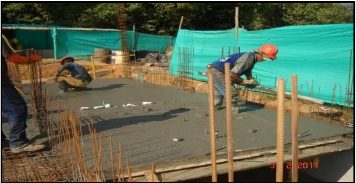
ENRASADA DEL CONCRETO
