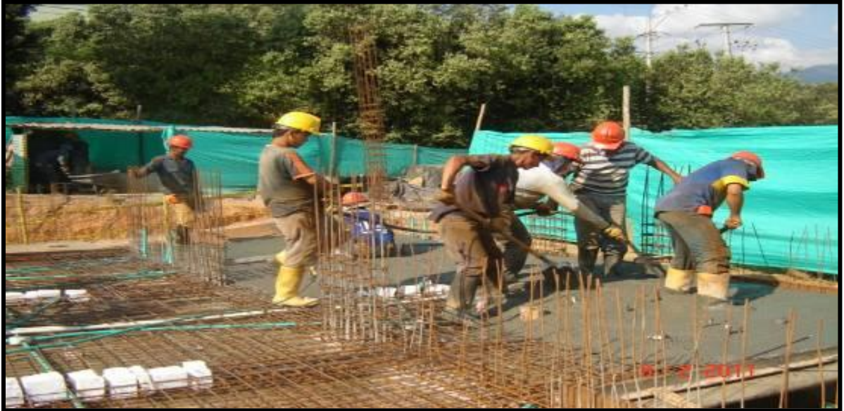
FUNDIDA PLACA DE PISO 2, DE LA TORRE 1 COSTADO NORTE.
