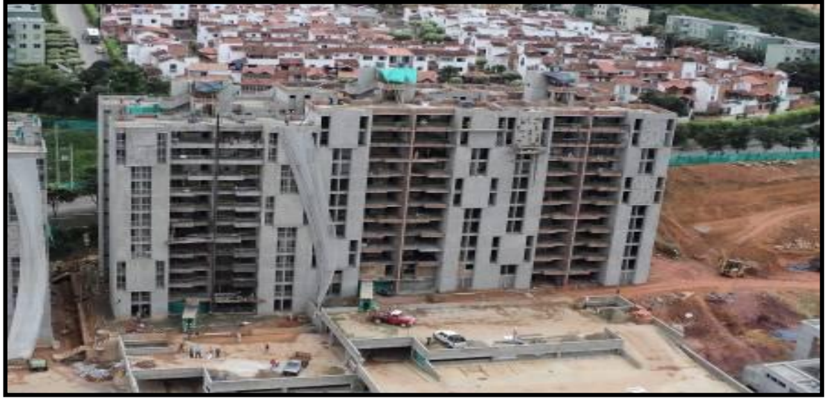
AVANCE VENTANERIA, MAMPOSTERIA Y FRISO TORRES 3, 4 Y 5 FACHADA PRINCIPAL
