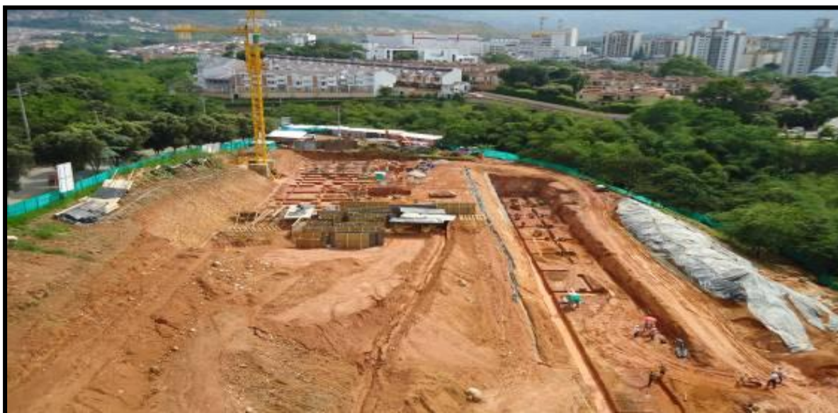
CONSTRUCCIÓN DE LA CIMENTACIÓN DE LOS PARQUEADEROS
