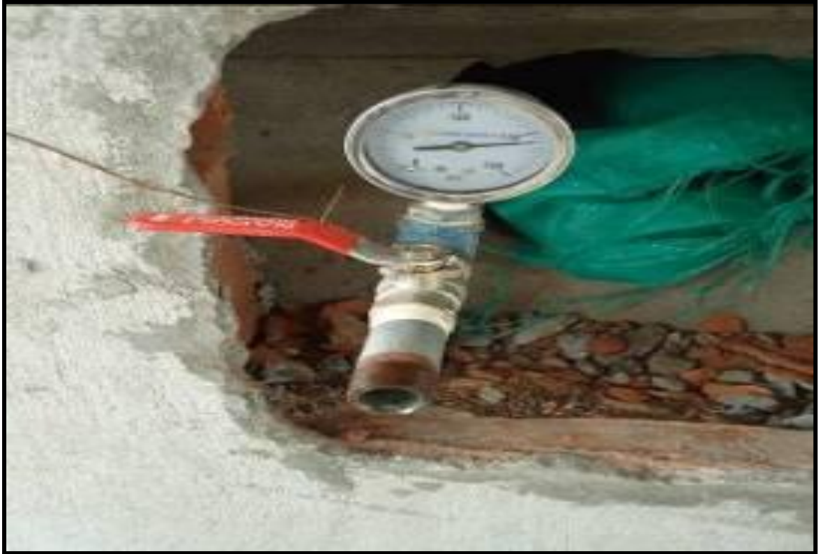
MANÓMETRO UTILIZADO EN LAS PRUEBAS HIDRÁULICAS, PRESIÓN =160PSI
