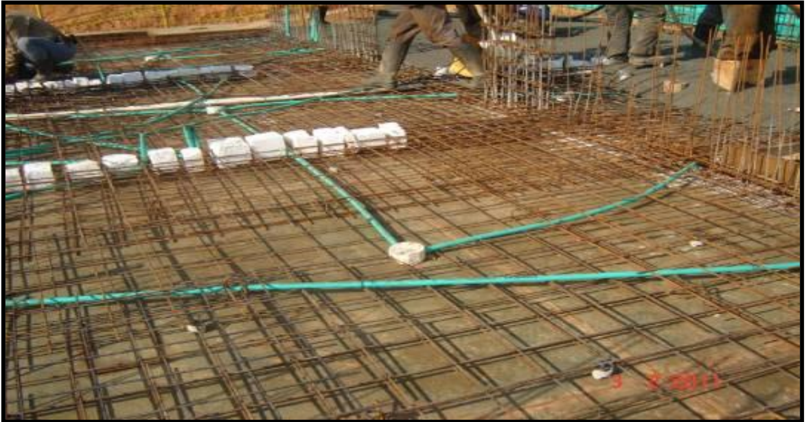
REVISIÓN DE LA TUBERÍA ELÉCTRICA Y SANITARIA ANTES DE FUNDIR, PLACA DE PISO 2
