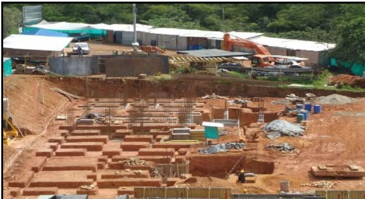
CONSTRUCCIÓN DE LA CIMENTACIÓN DE LAS TORRES.
