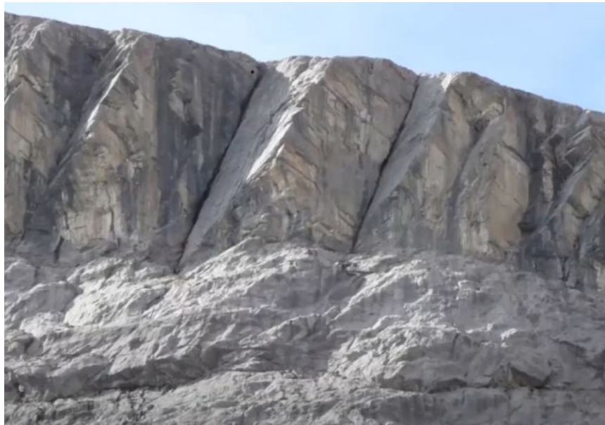
Imagen 25. Deslizamiento en cuña.
