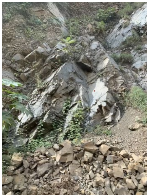
Imagen 26. Deslizamiento en cuña.
