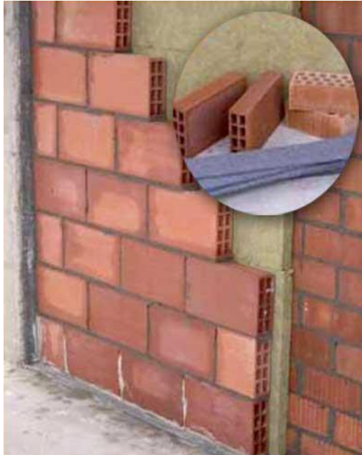
Figura 13. Muro de mampostería hueco o divisorio.
