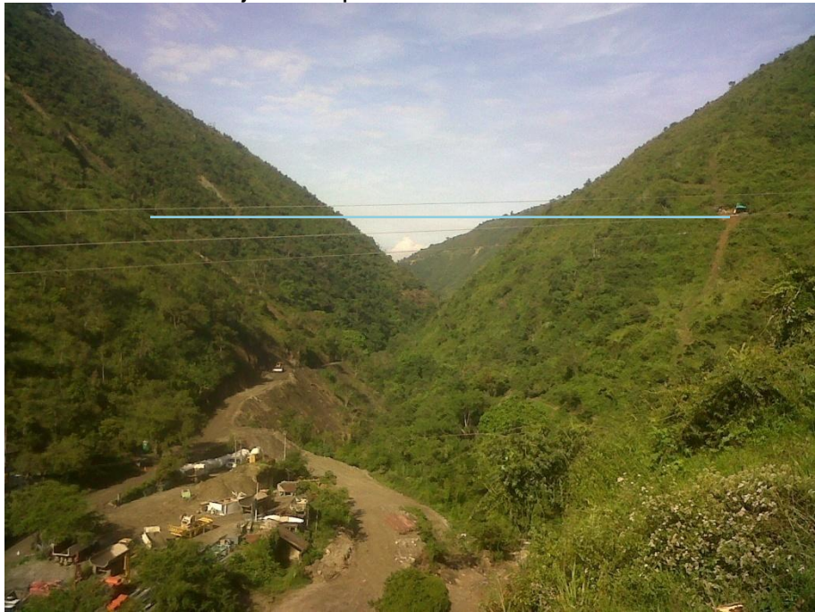
Panorámica del eje de la presa
