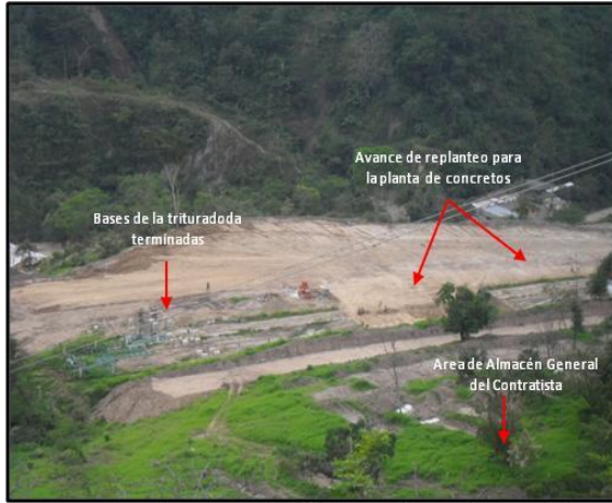
Avance en la construcción de las principales instalaciones del contratista en el área del proyecto.
