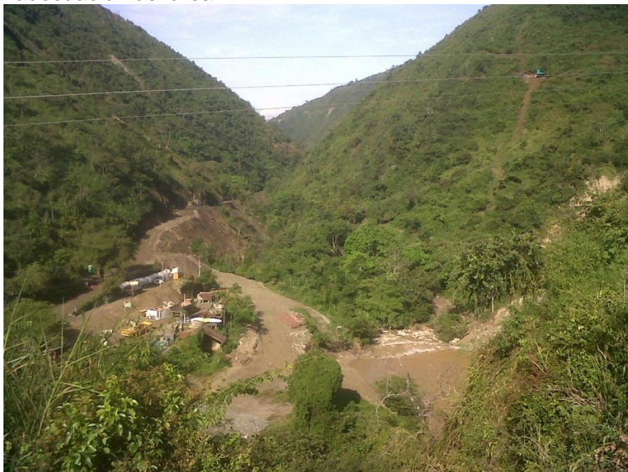
Zona de construcción de la presa y primeros trabajos de adecuación del área
