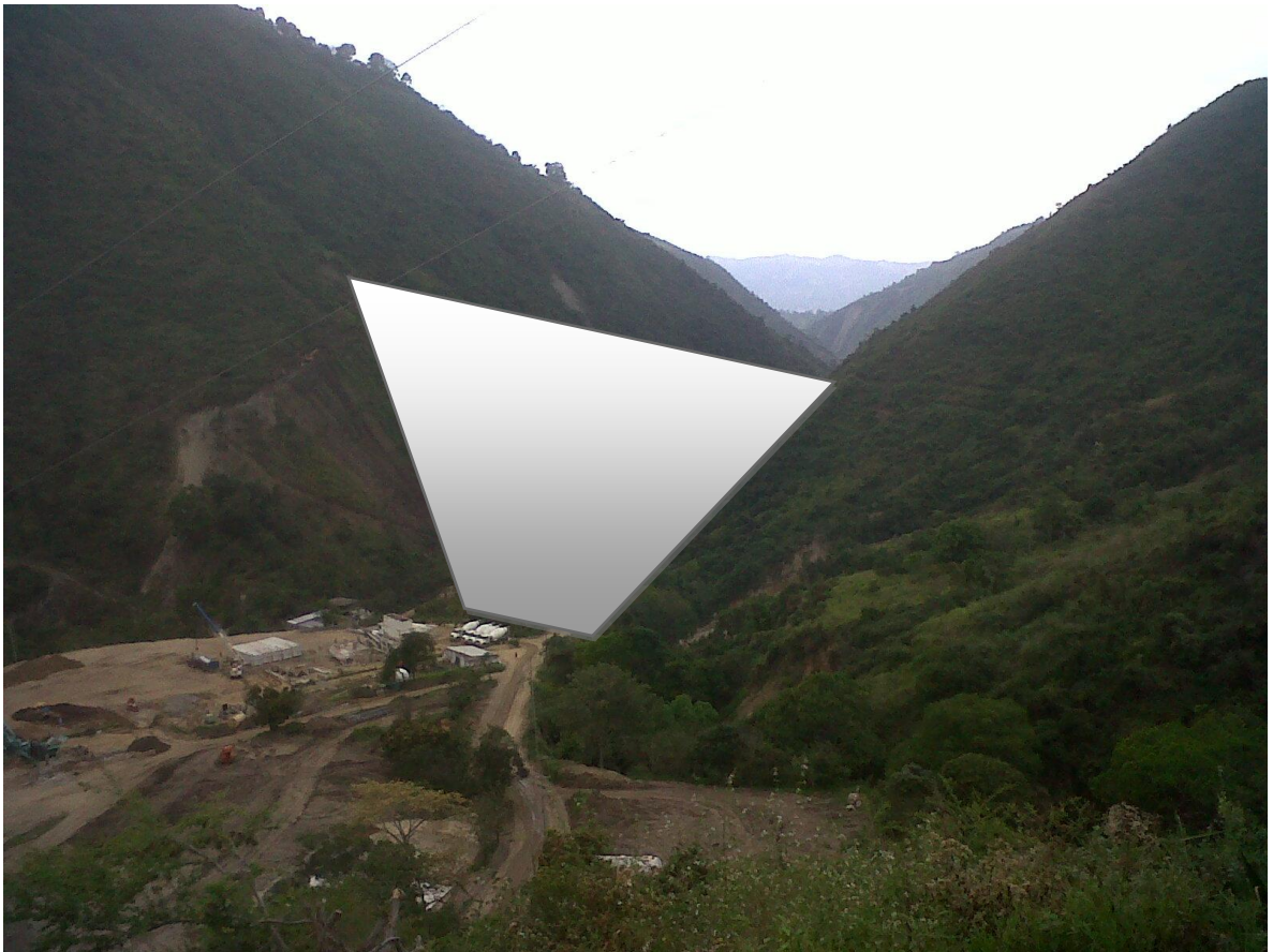
Panorámica del sitio de la obra y eje de la presa, altura máxima 103 metros.
