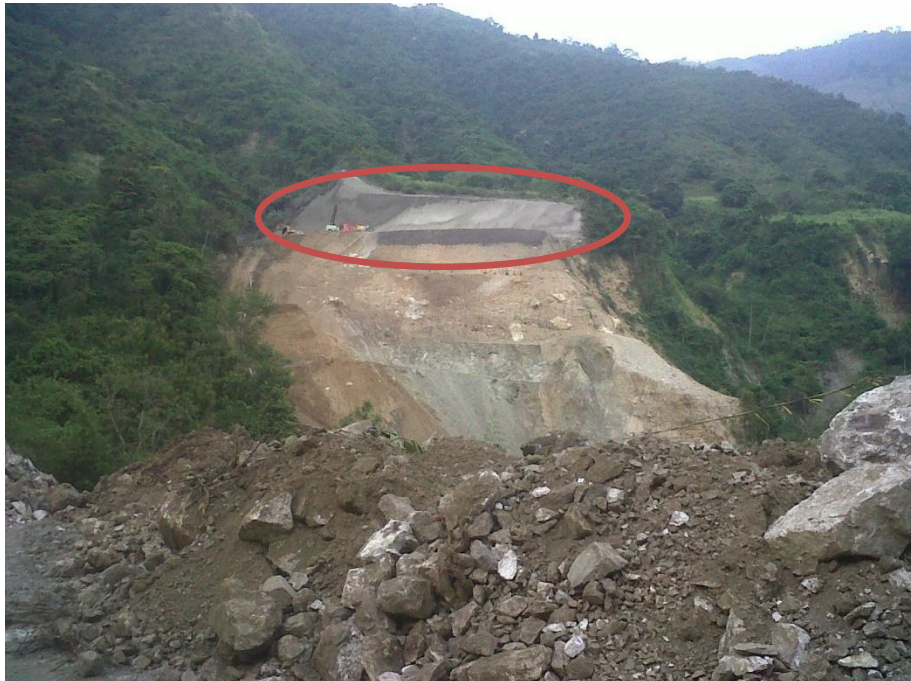
Aplicación de mortero en los taludes sobre la zona del portal del túnel de desvío
