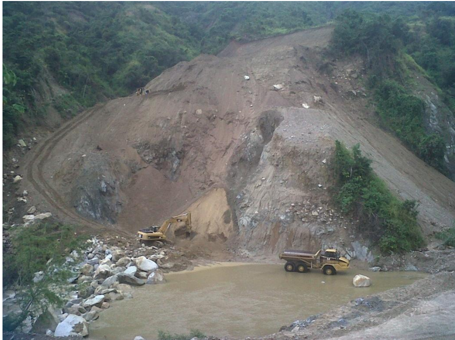
Terraceo para evitar derrumbes durante la construcción del túnel
