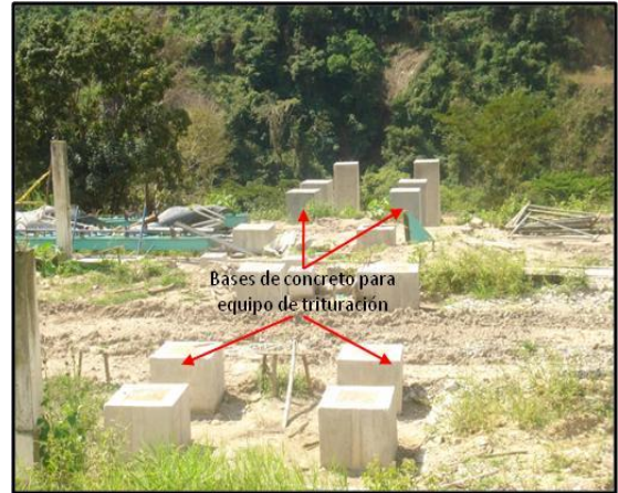
Avance en la construcción de las bases de concreto para la secundaria del equipo de trituración de agregados pétreos.
