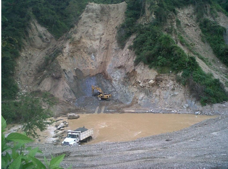
Movimiento de tierra para despejar la zona del portal del túnel de desvío
