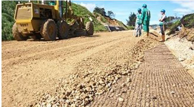
*Imagen 1 Utilización de geosintético. Imagen extraída de PAVCO. (Geotextil Biaxial)*
