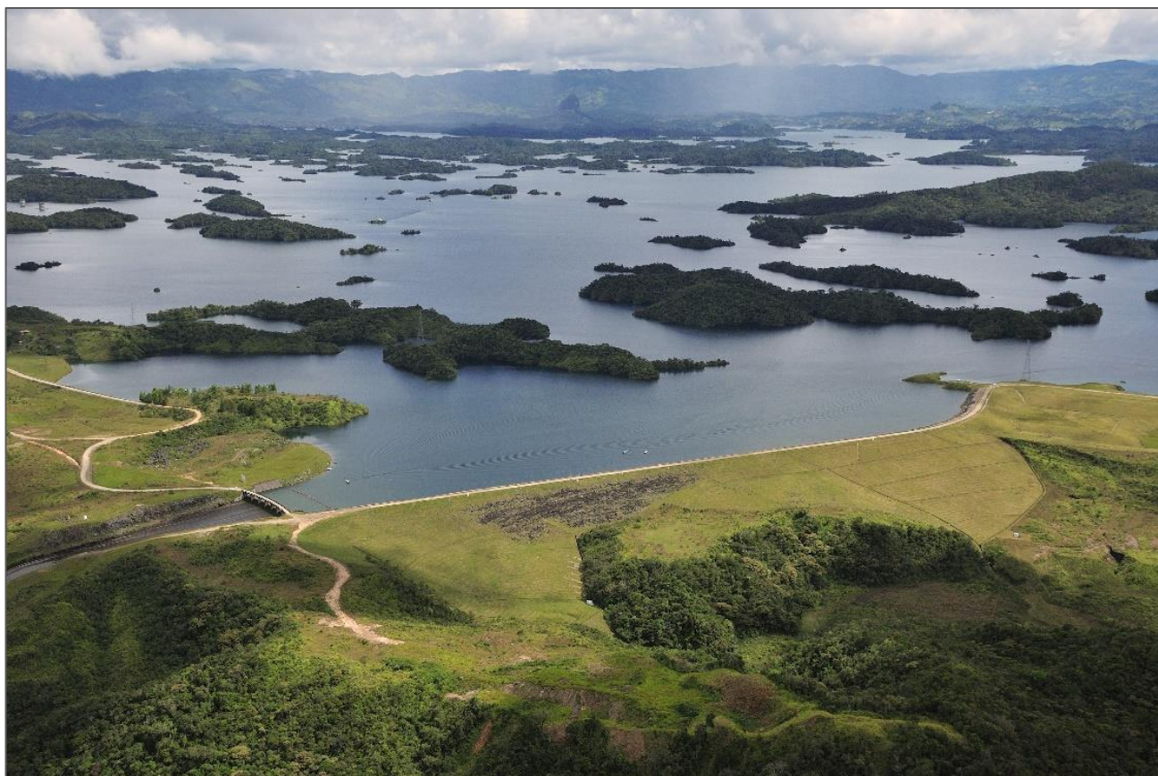
Figura 11. Vista presa Santa Rita. Fuente: Ingeniería de presas EPM [5]
