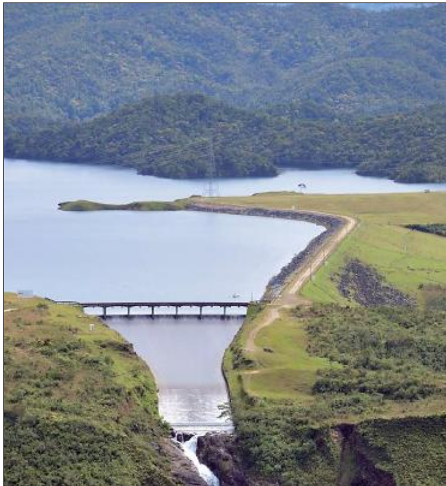
Figura 12. Vertedero de la presa Santa Rita en operación. Fuente: Ingeniería de presas EPM [5]
