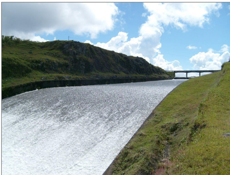
Figura 18. Canal de descarga del vertedero de la Presa Santa Rita. Fuente: https://mapio.net/pic/p-16281287/
