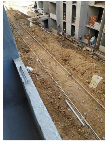
Ilustración 36. Malla electrosoldada para los senderos peatonales.
