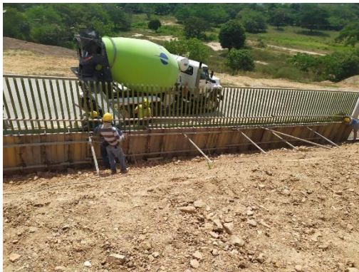
Ilustración 32. Encofrado listo para fundir.
