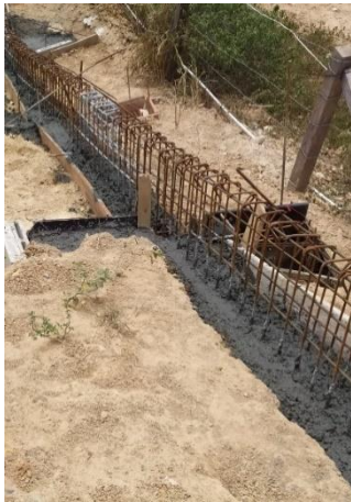
Ilustración 30. Acero armado para el cerramiento.
