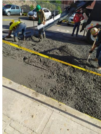
Ilustración 27. Vertimiento del concreto
