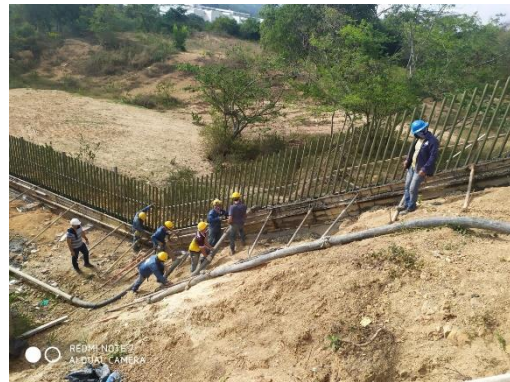
Ilustración 33. Fundida con bombeo por las dificultades del terreno.
