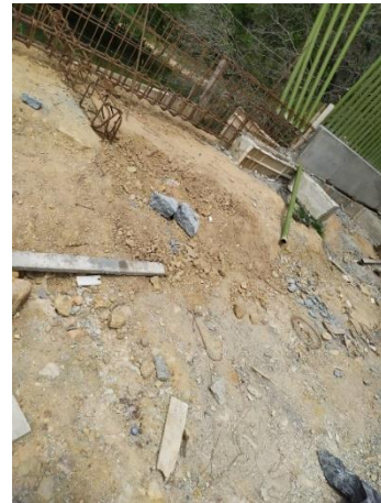
Ilustración 31. Acero armado para Bordillo y viguetas
