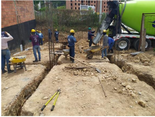
Ilustración 41. Fundida de las vigas y zapatas del local comercial
