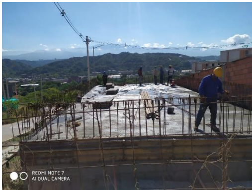
Ilustración 55. Armado de formaleta para bordillo sobre el local comercial
