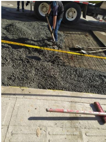
Ilustración 28. Esparcimiento del concreto en toda el área del parqueadero de motos..
