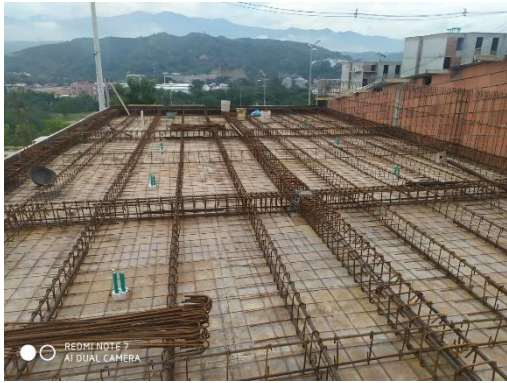
Ilustración 49. Armado de Vigas, viguetas de la placa aligerada
