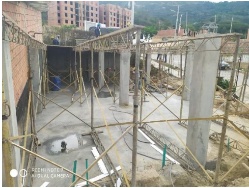
Ilustración 47. Instalación de cerchas y parales para fundir la placa aligerada
