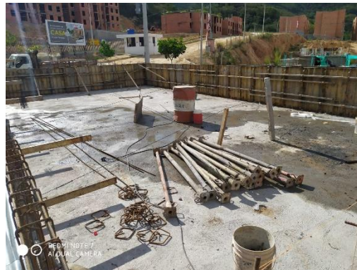
Ilustración 56. Armado de formaleta para bordillo sobre el local comercial
