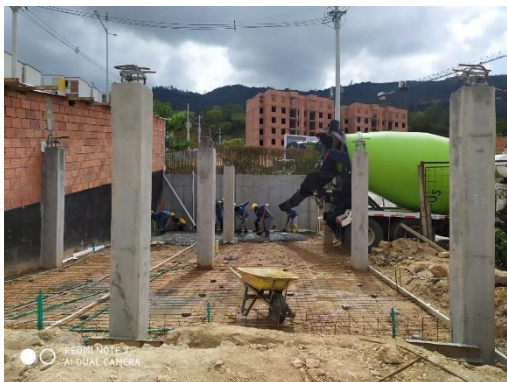
Ilustración 45. Fundida de la losa de contrapiso
