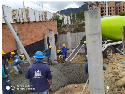
Ilustración 46. Fundida de la losa de contrapiso
