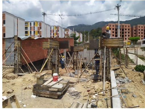
Ilustración 42. Armado de formaleta de columnas
