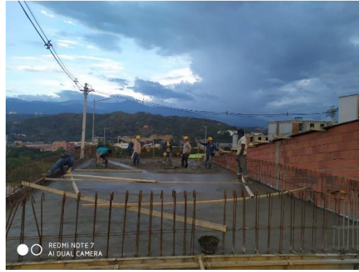
Ilustración 54. Fundida de la placa aligerada
