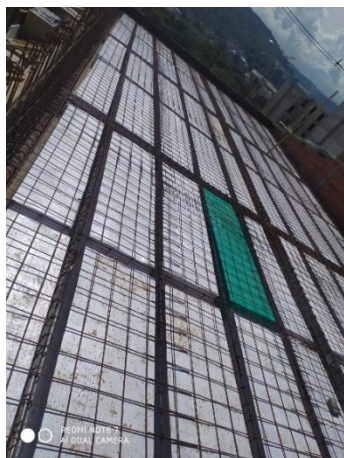
Ilustración 51. Instalación de casetones
