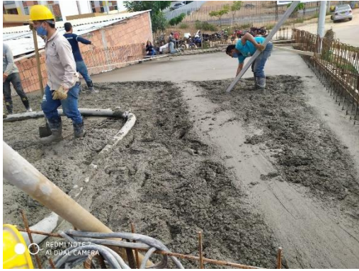
Ilustración 53. Fundida de la placa aligerada
