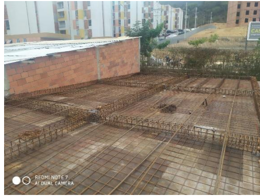
Ilustración 48. Armado de Vigas, viguetas de la placa aligerada
