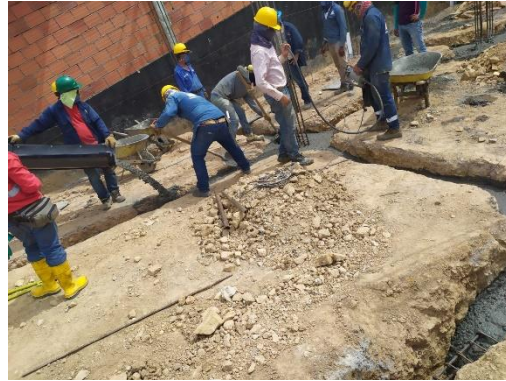
Ilustración 40. Fundida de las vigas y zapatas del local comercial
