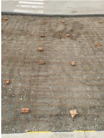
Ilustración 26. Se instala la malla electrosoldada con separación C .15
