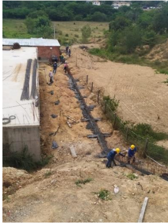
Ilustración 34. Armado del acero para el cerramiento
