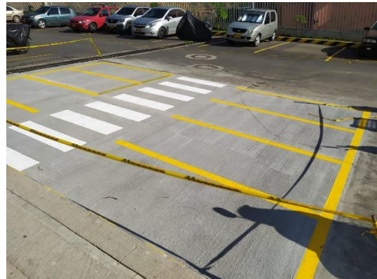
Ilustración 29. Parqueadero pintado y acabado
