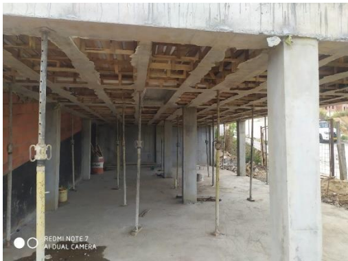
Ilustración 57. Desencofrado de la placa aligerada.
