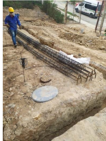
Ilustración 38. Vigas armadas
