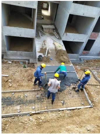
Ilustración 35. Fundida con viajes del concreto en carretilla.
