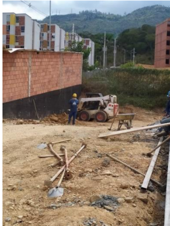
Ilustración 37. Descapote y limpieza del terrero a construir.
