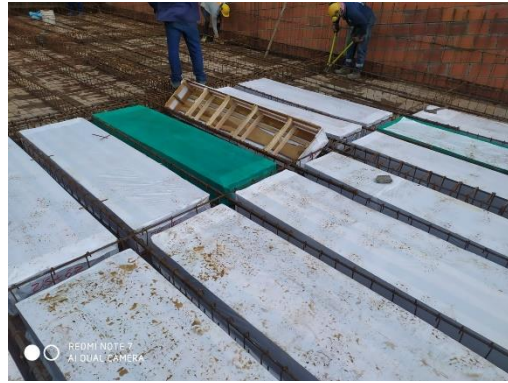
Ilustración 50. Instalación de casetones
