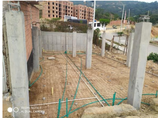
Ilustración 44. Instalación de redes eléctricas e hidrosanitarias.
