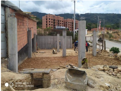
Ilustración 43. Suelo nivelado para fundir la losa de contrapiso
