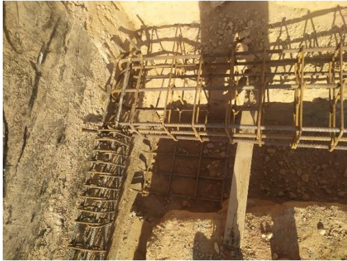
Ilustración 39. Zapatas armadas
