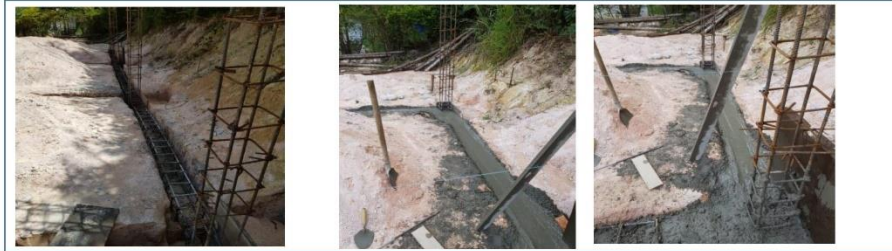
Excavación y Fundida de Vigas de amarre
