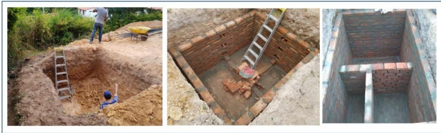
Excavación con retro, en material común y/o conglomerado - Concreto pobre para solados e = 5 cm - Muro en ladrillo temosa
