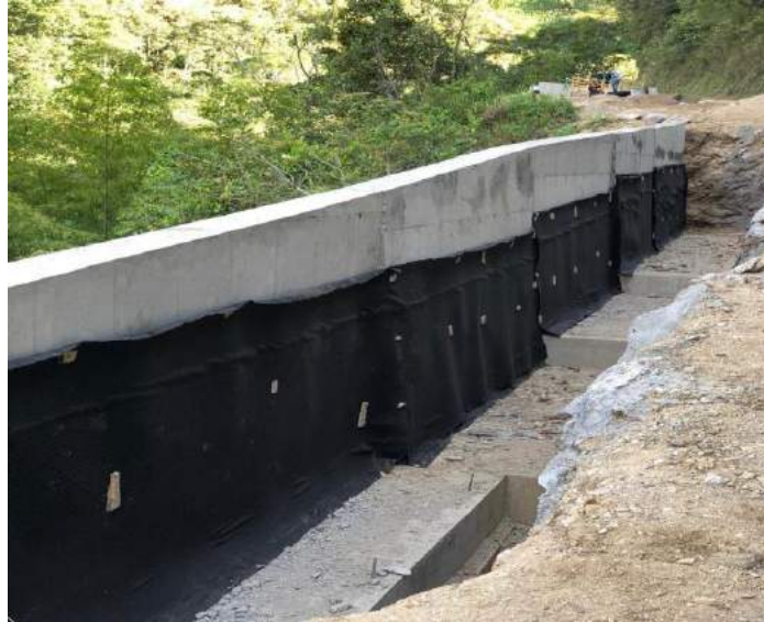
Figura 48. Instalación del geodrén en el muro anclado convencional
