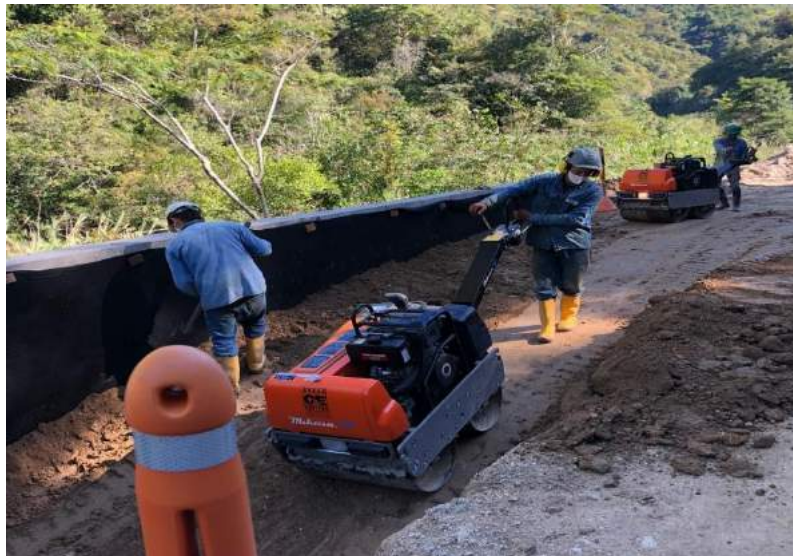
Figura 41. Relleno y compactación muro anclado convencional
