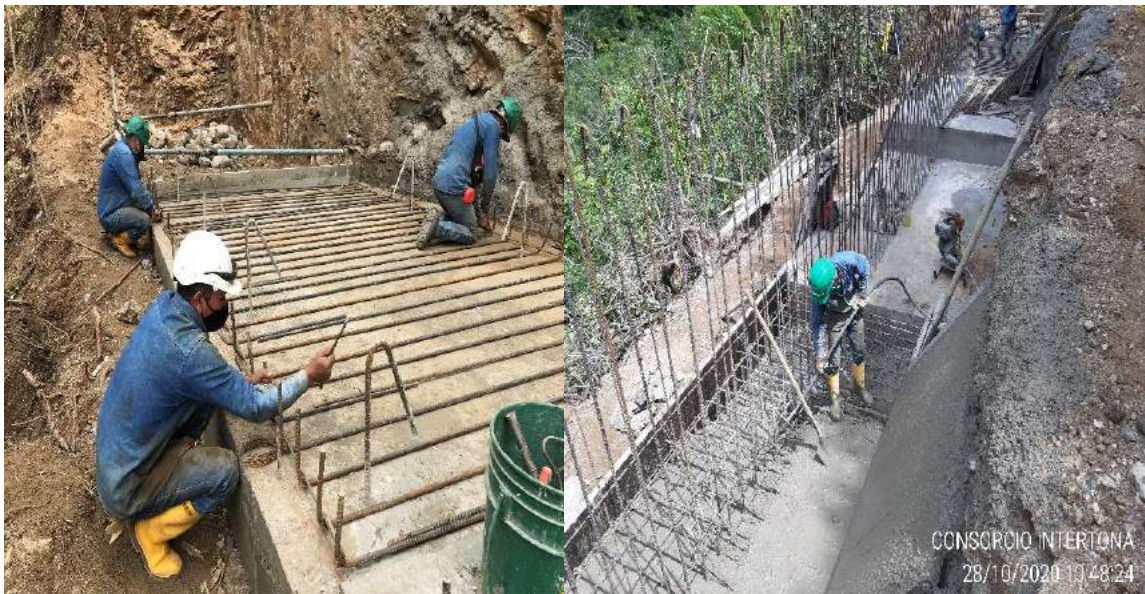
Figura 37. Armado de acero y vaciado de concreto del muro anclado convencional
