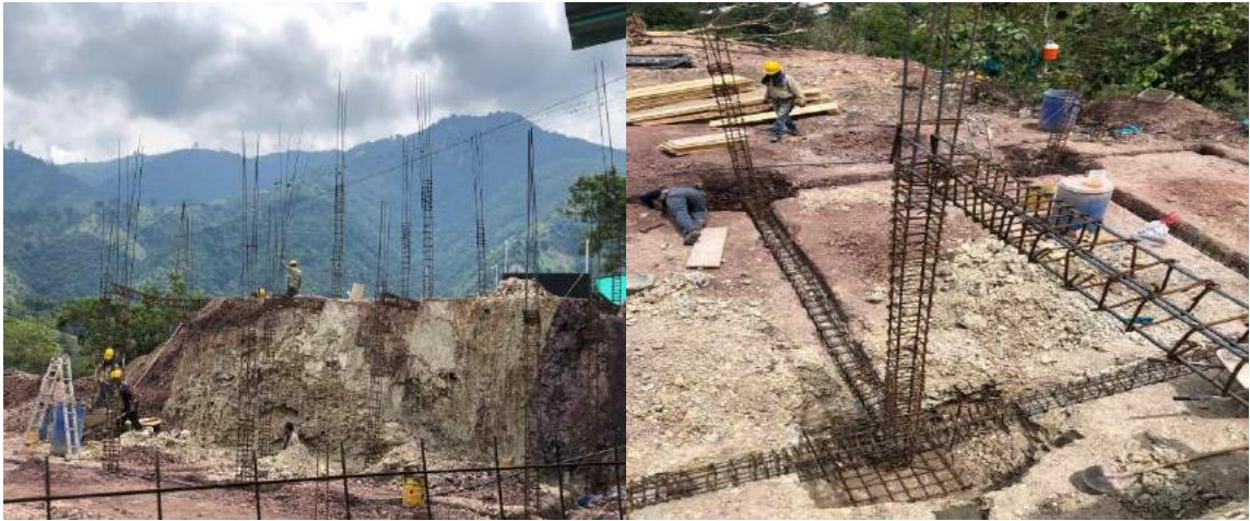
Figura 9. Armado de columnas
