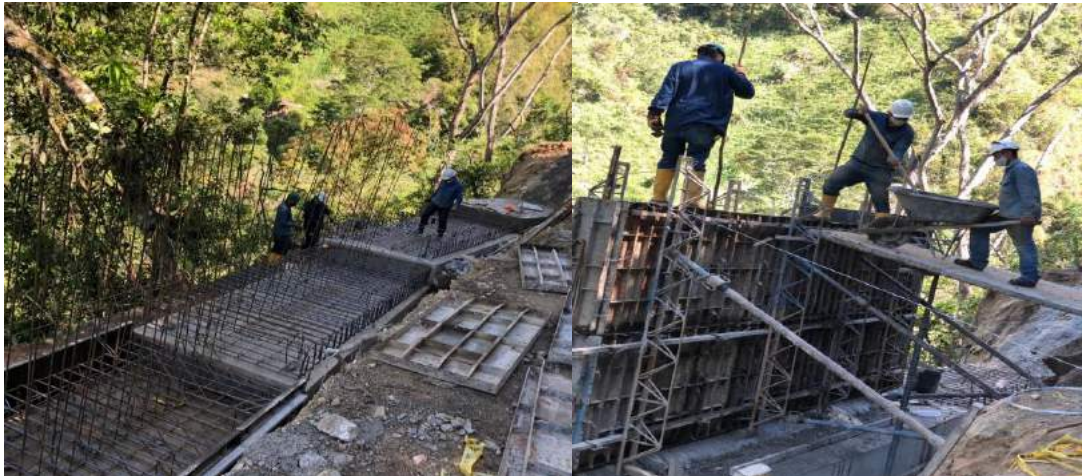
Figura 43. Armada de acero y fundida de muro anclado convencional
