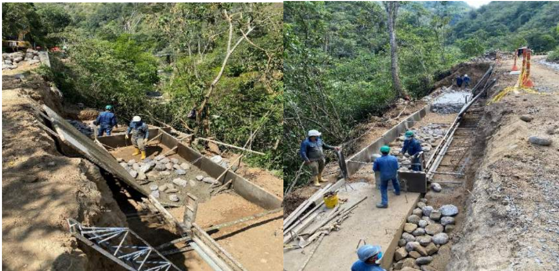
Figura 29. Mejoramiento de suelo en concreto ciclópeo muro anclado convencional
