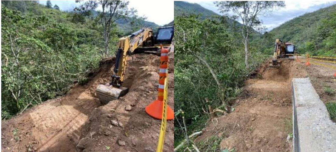
Figura 28. Excavación y nivelación muro anclado convencional
