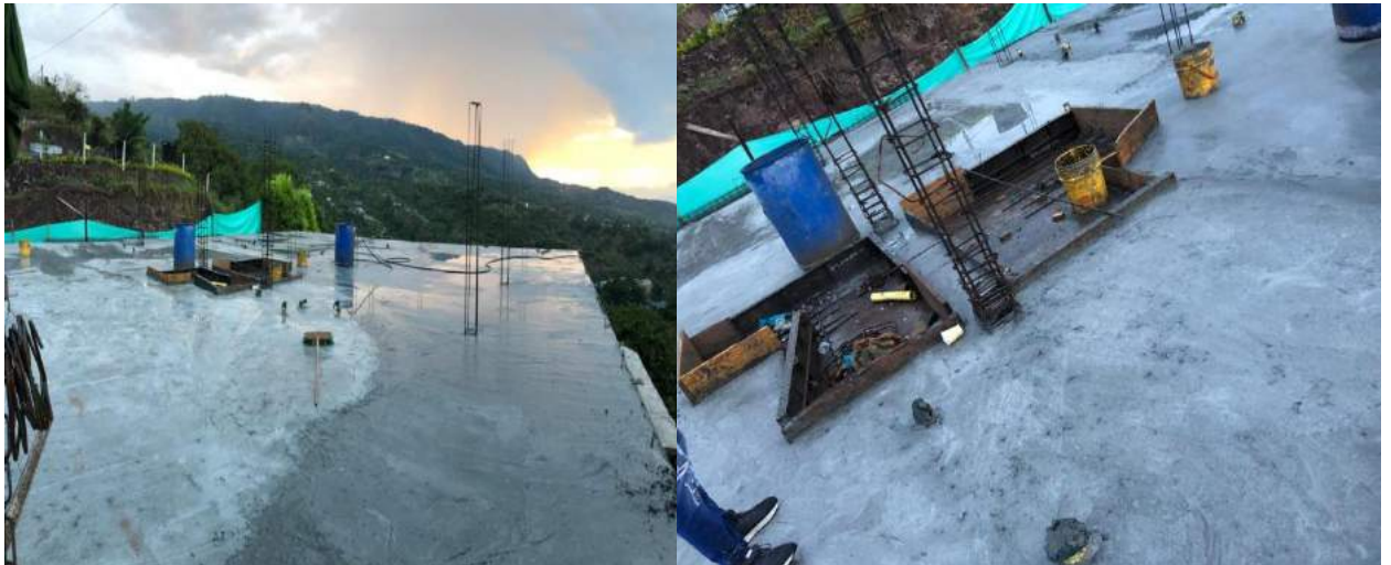
Figura 19. Fundida placa del segundo piso.
