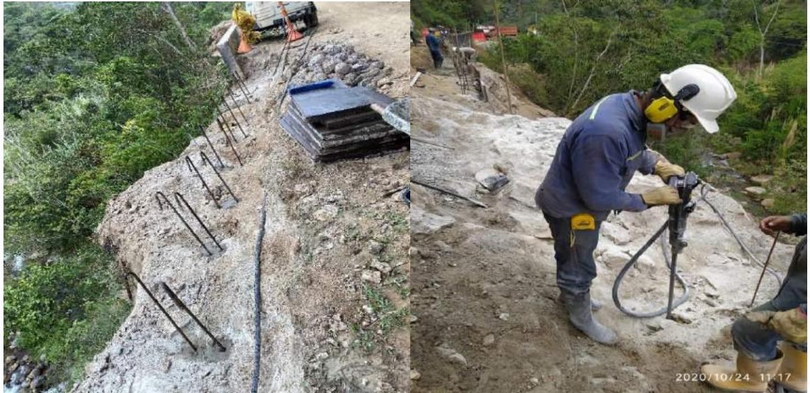
Figura 26. Perforación e instalación de anclajes viga 60x60
