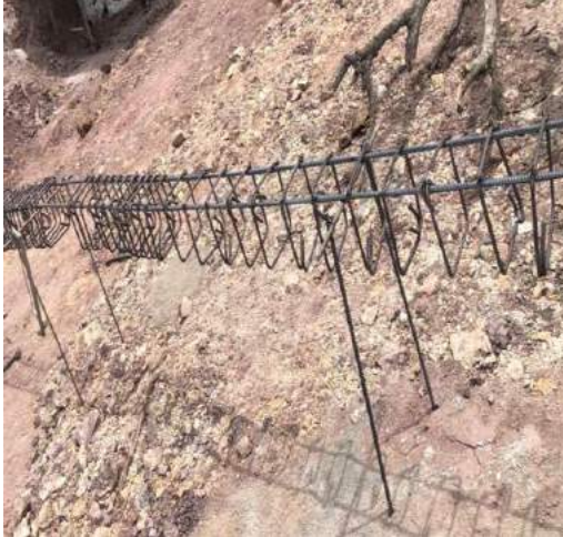
Figura 7. Amarre hierro de vigas
