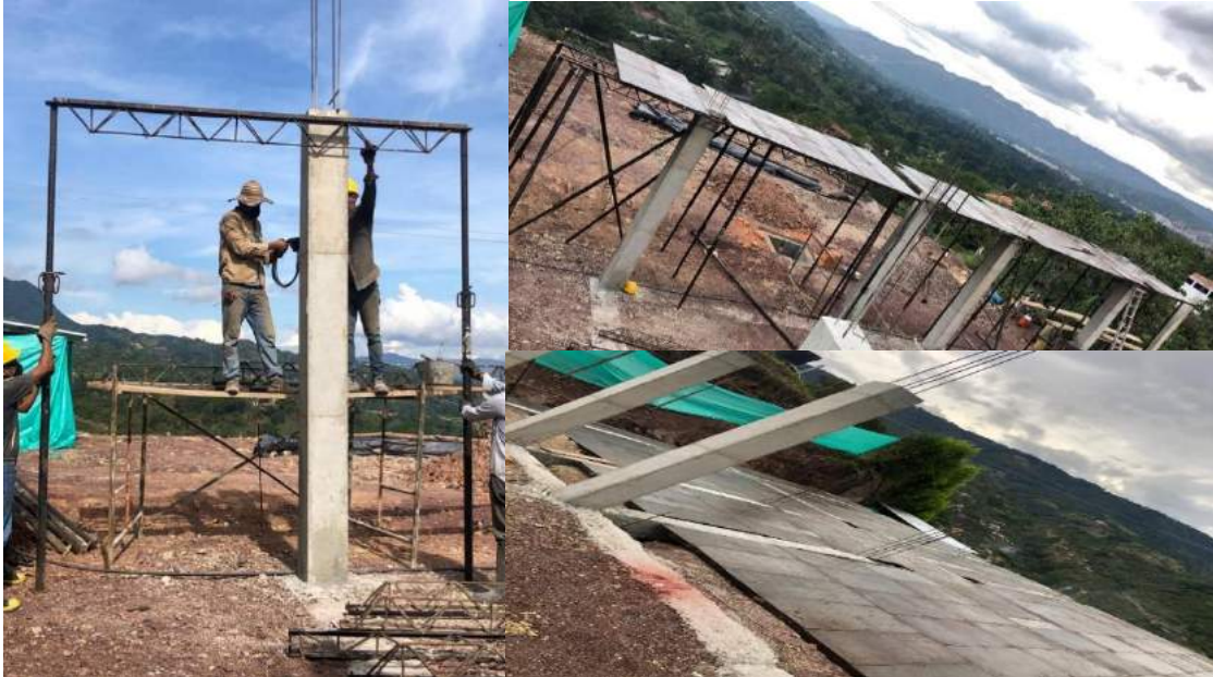
Figura 13. Armado placa del primer piso
