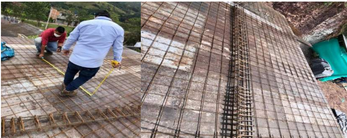
Figura 14. Colocación acero del primer piso
