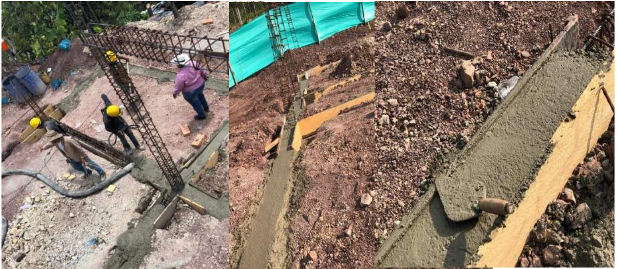
Figura 10. Fundida de cimentación
