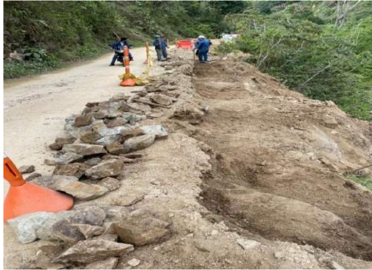
Figura 24. Excavación y nivelación de viga 60x60
