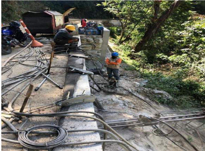
Figura 38. Perforación e instalación de anclajes pasivos muro en voladizo anclado
