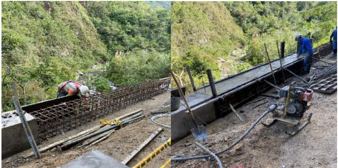
Figura 27. Armado de acero por módulos y su respectivo vaciado de concreto de 4000 PSI
