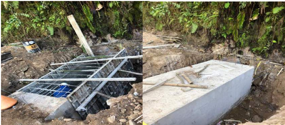
Figura 45. Armado de acero de refuerzo y fundida del módulo 2 box culvert
