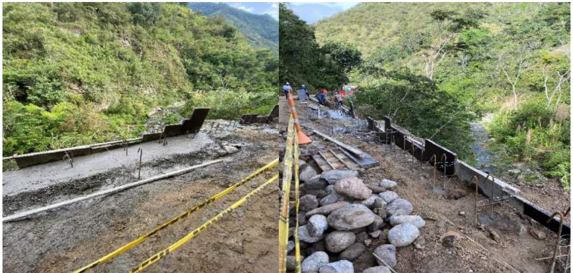
Figura 25. Mejoramiento en concreto ciclópea viga 60x60
