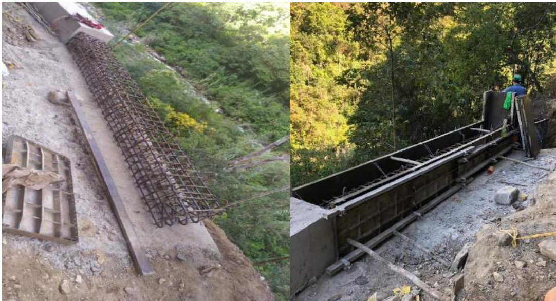
Figura 42. Armado de acero de refuerzo y fundida de viga de cimentación
