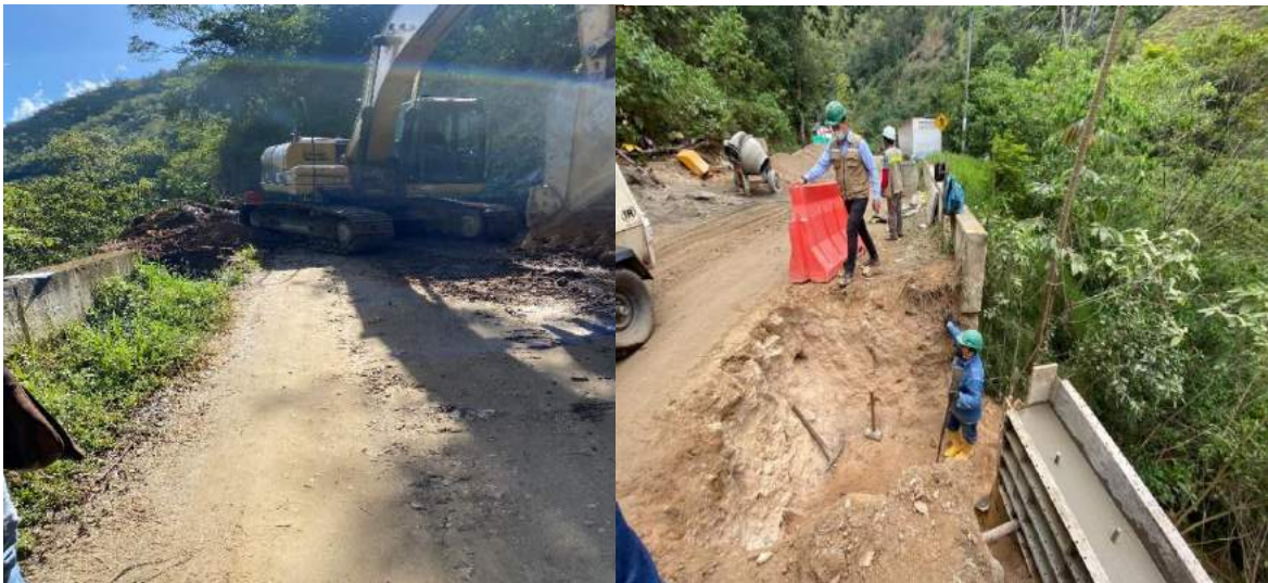
Figura 21. Excavación y nivelación del Box Culvert K13+801
