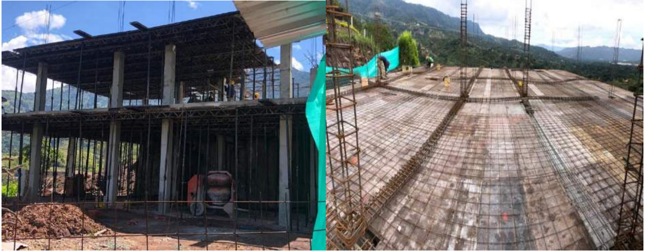
Figura 18. Armado y colocación del acero para la placa del segundo piso
