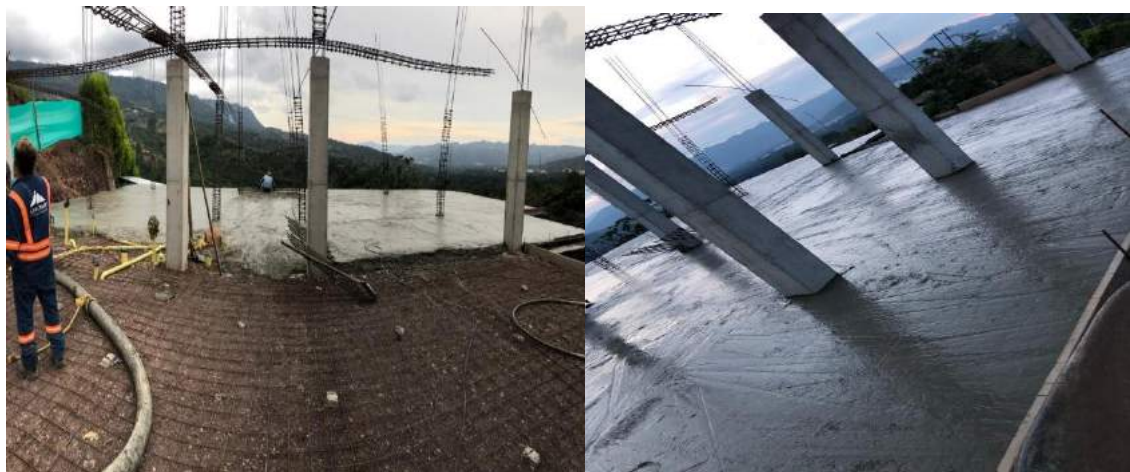
Figura 16. Fundida placa del primer piso
