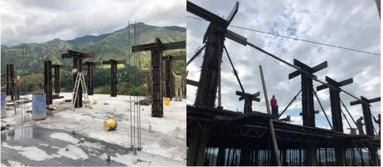
Figura 20. Armado y fundida de columnas de la cubierta
