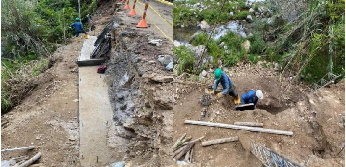
Figura 32. Mejoramiento de suelo en concreto ciclópeo muro en voladizo
