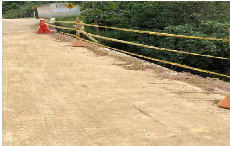
Figura 39. Relleno y compactación muro en voladizo anclado
