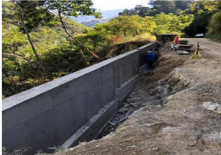
Figura 44. Construcción muro anclado convencional
