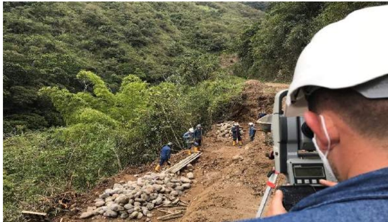
Figura 36. Localización y replanteo muro anclado convencional
