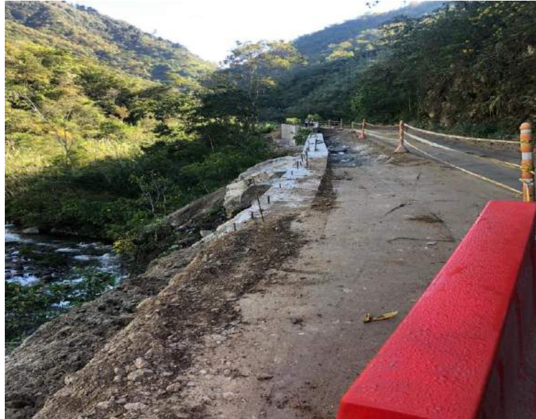
Figura 40. Relleno y compactación viga de cimentación
