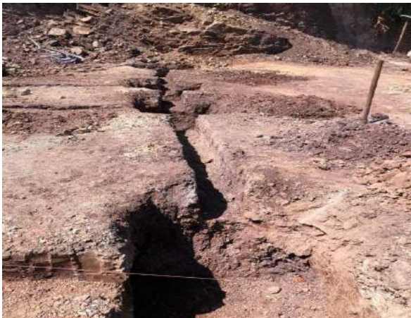
Figura 5. Excavación vigas de cimentación
