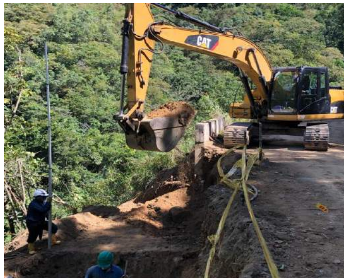
Figura 47. Excavación mecánica muro anclado convencional
