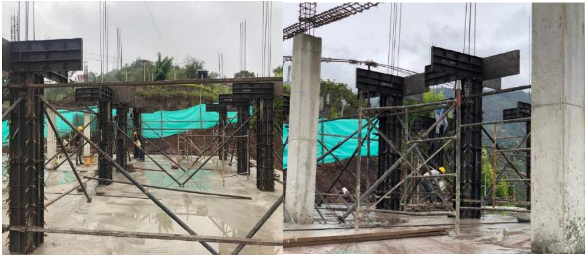
Figura 17. Armado y fundida de columnas faltantes del primer piso
