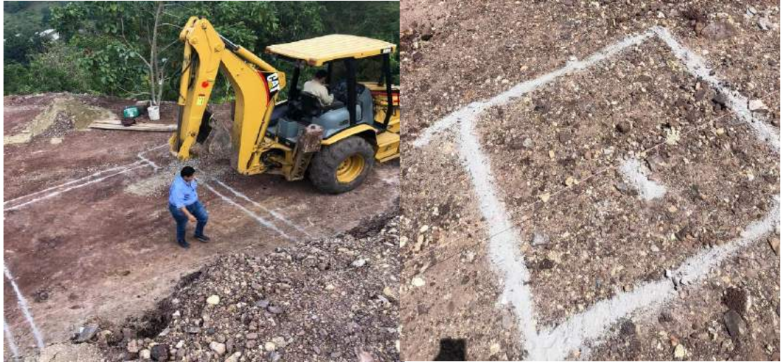
Figura 4. Localización de zapatas
