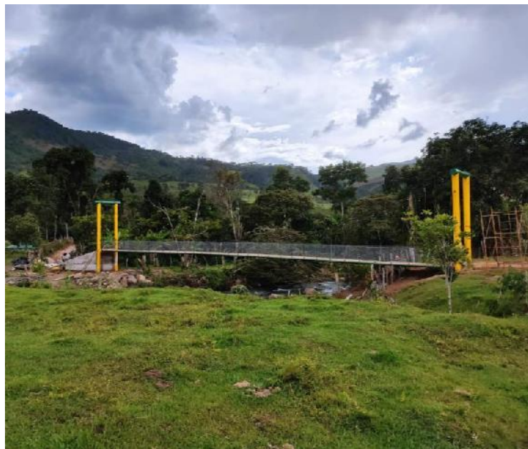
Nuevo puente en Mogotes, Santander peatonal en Mogotes, Santander
