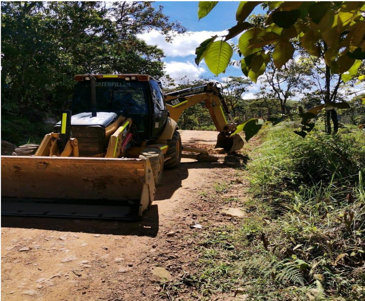
**Figura 2.** Excavación mecánica de la subrasante
