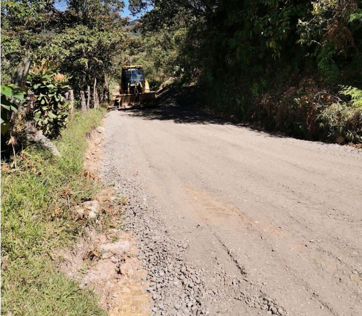
**Figura 3.** *Instalación de la base granular*
