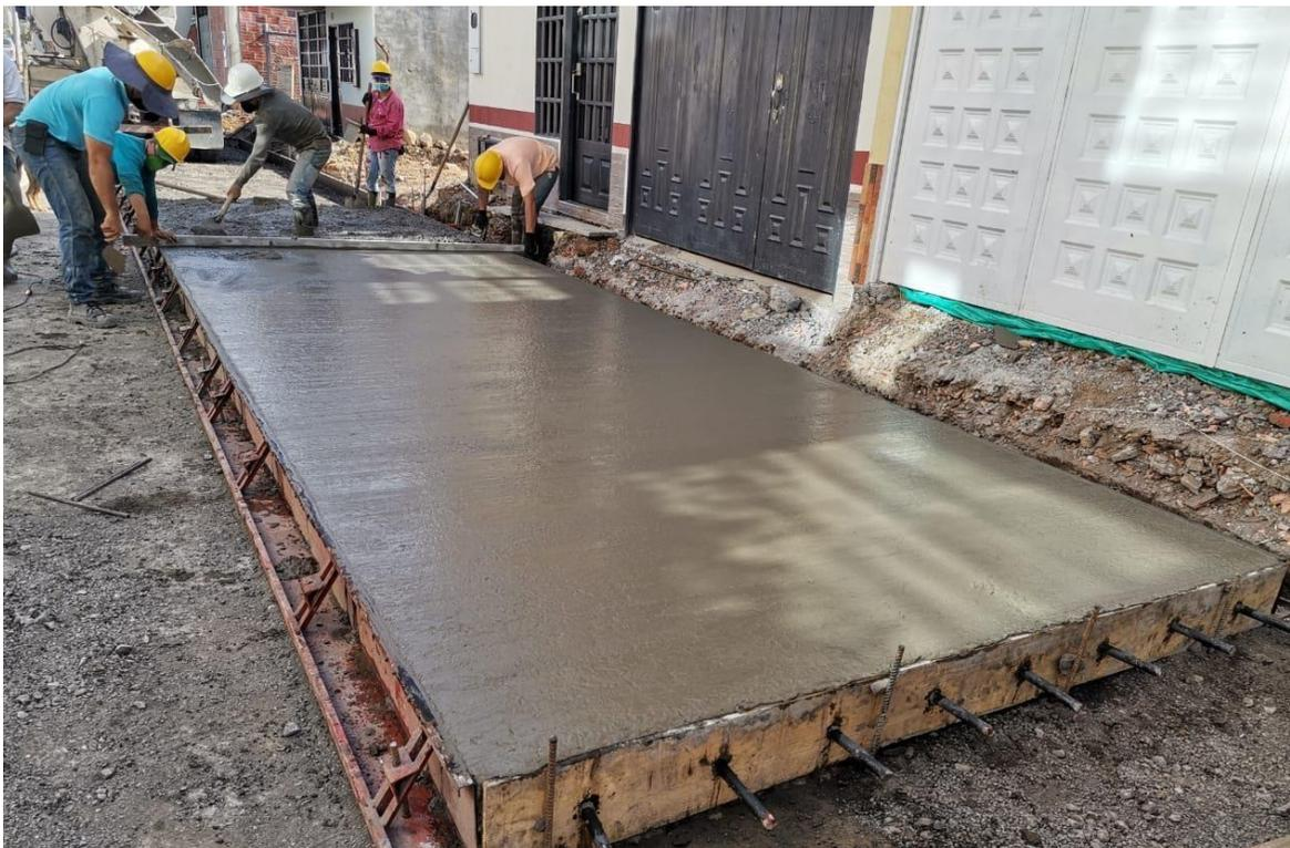
**Figura 9.** Fundida de pavimento rígido
