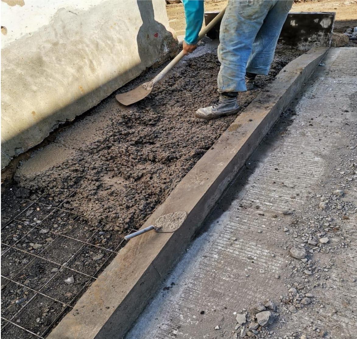
**Figura 13.** *Instalación de malla electrosoldada y fundida de andén*
