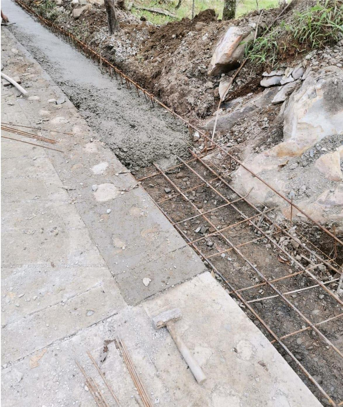
**Figura 4.** *Instalación de acero de refuerzo para cuneta y bordillo y fundida de estas*
