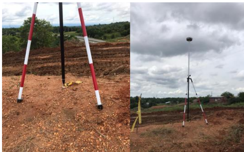
Imagen 20. Ubicación GPS-RTK X900 en mojón proyecto PTAR-Barranca Fuente: Propia
