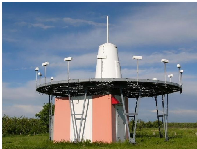
Ilustración 7. Estación en tierra de un VOR tipo D 7
