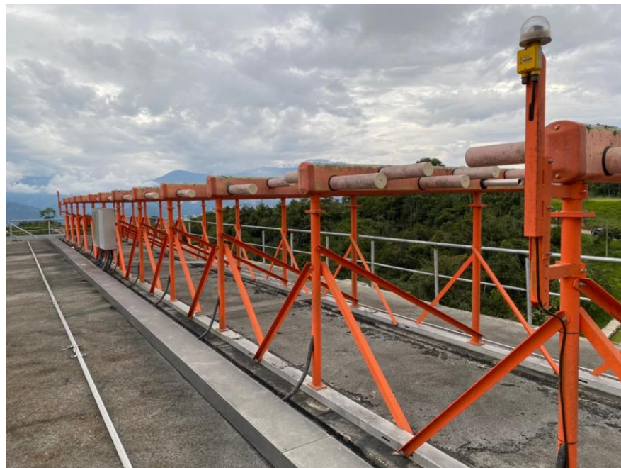
Ilustración 84. Antena localizador ILS Palonegro 84
