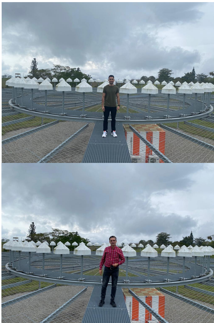
Ilustración 71. Conjunto de antenas para efecto Doppler, D-VOR mesa de Los Santos, aeropuerto Palonegro 71
