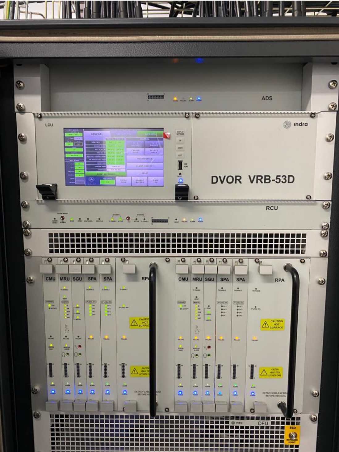
Ilustración 73. Sistema de control D-VOR mesa de Los Santos, aeropuerto de Palonegro 73
