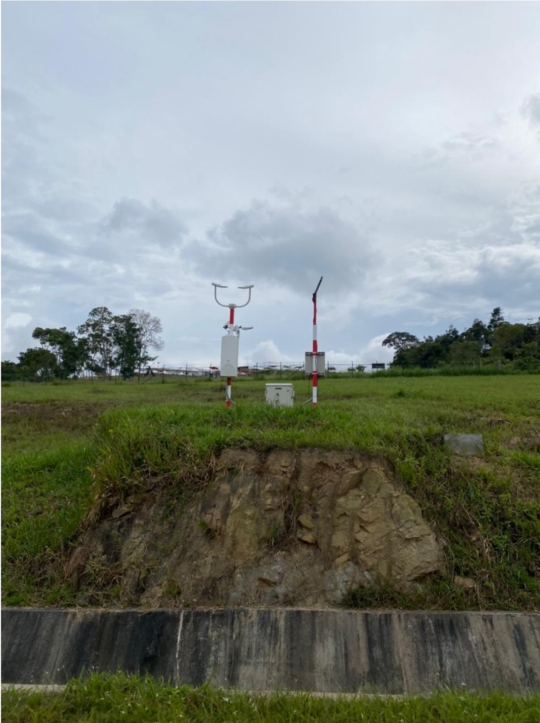
Ilustración 77. Estación meteorológica a final de pista 77
