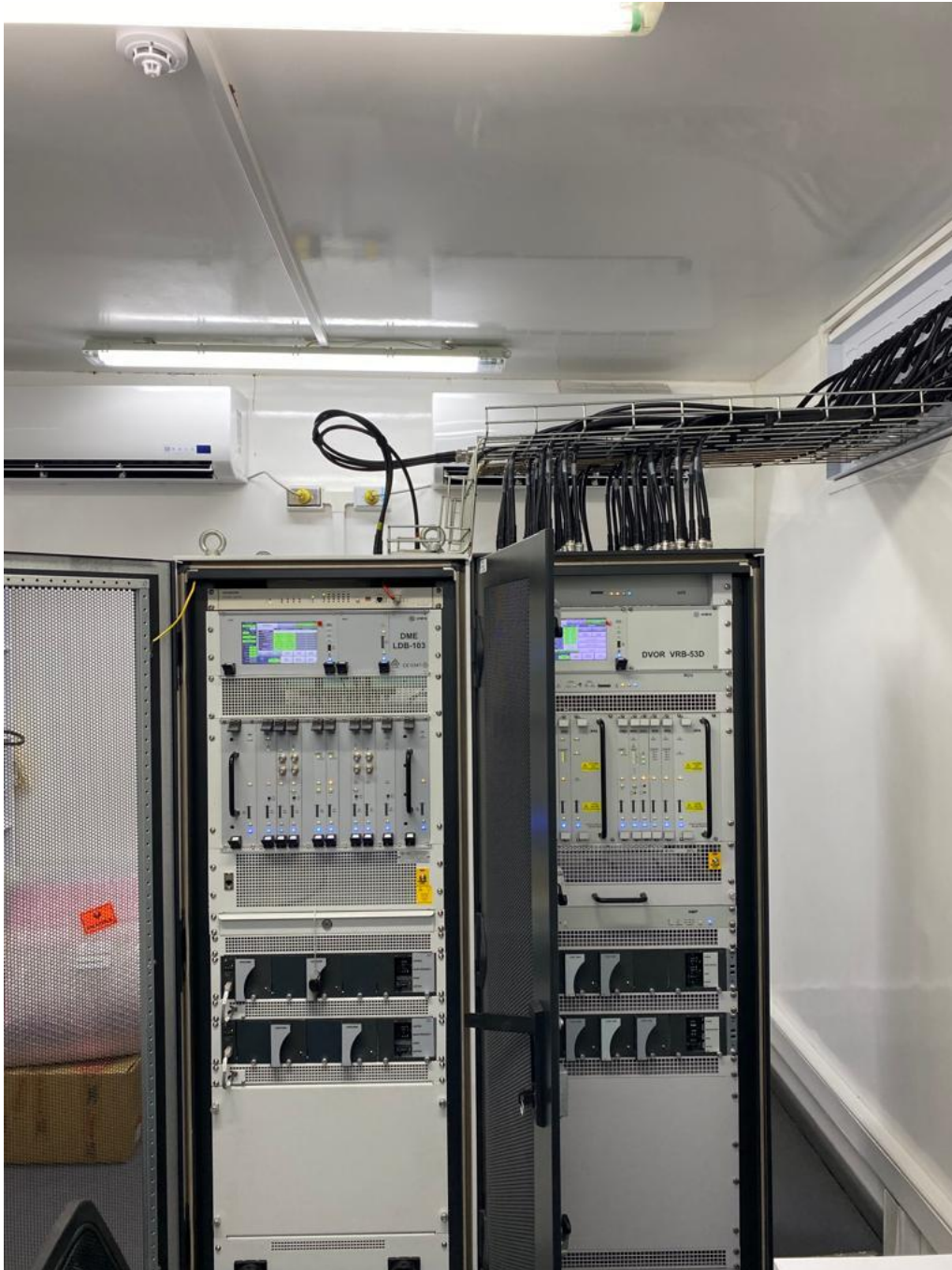
Ilustración 72. Sistema de control Equipo Medidor de Distancia (DME) y VOR 72
