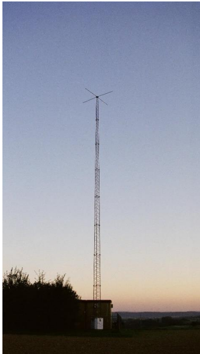
Ilustración 26. Radio baliza no direccional NDB 26
