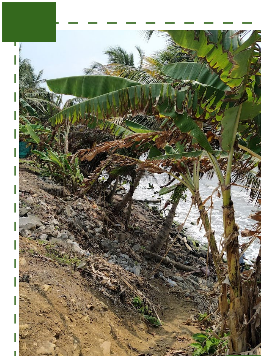
Imagen 73. Zona perdida por erosión. Foto Propia. Año 2024
