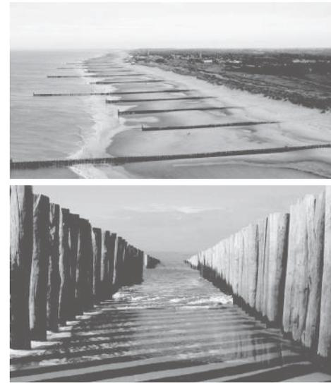
Imagen 40. Espigones en la costa sur-occidental holandesa del delta. Tomada de Rijkswaterstaat.
