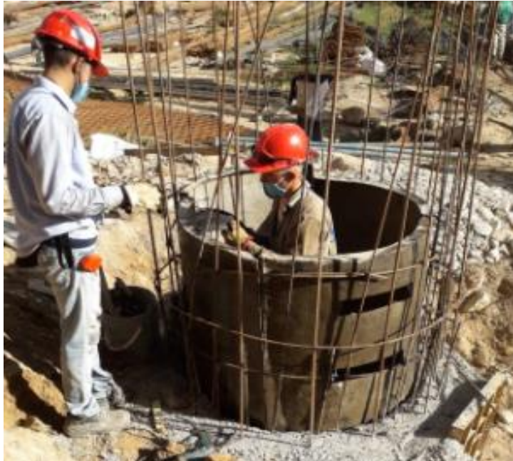
Figura 24. Armado de acero y formateo de cilindro de pozo.
