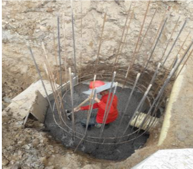
Figura 23. Fundición de piso del pozo.
