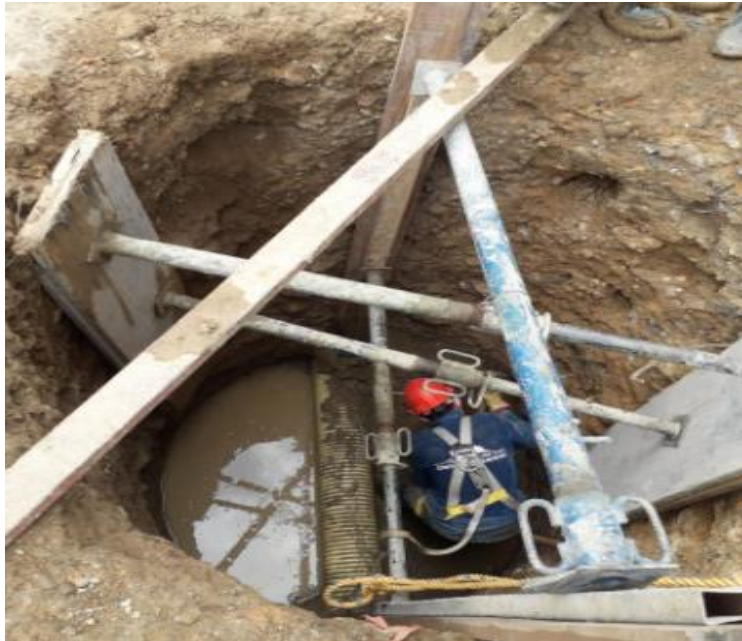
Figura 22. Excavación y entibado para construcción de pozo de inspección.
