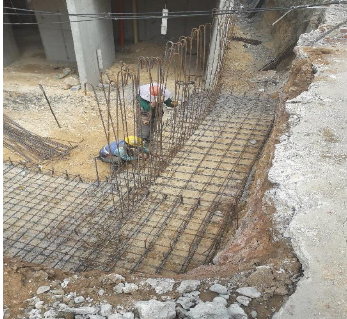
Figura 15. Armado acero viga zarpa.
