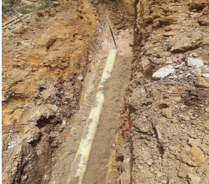
Figura 21. Instalación tubería sanitaria.
