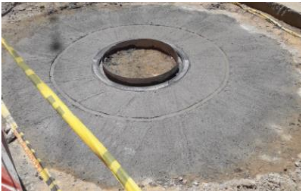
Figura 26. Pozo fundido hasta corona.
