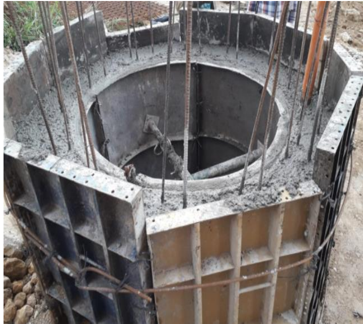
Figura 25. Fundición de primer cilindro.
