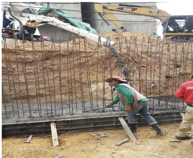
Figura 16. Fundición viga zarpa.
