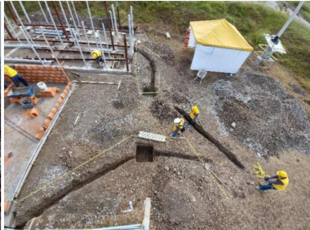
*Fotografía 12. Excavaciones para cajas de inspección y sistema hidrosanitario (Fuente: Propia).*
