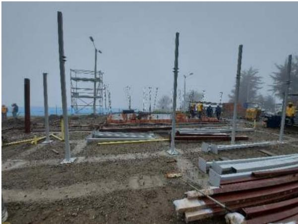
*Fotografía 11. Instalación de estructura metálica sobre bases soldadas y cimentación fundida (Fuente: Propia).*
