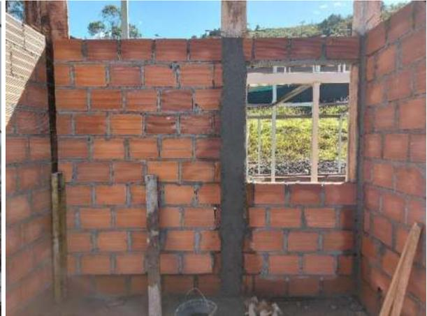
Fotografía 14. Construcción de columnas en vivienda tradicional (Fuente: Propia).
