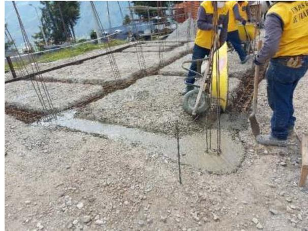
Fotografía 8. Fundida de vigas de cimentación con terreno como formaleta (Fuente: Propia).
