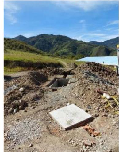
Fotografía 24. Excavación sistema de aguas lluvias (Fuente: Propia).
