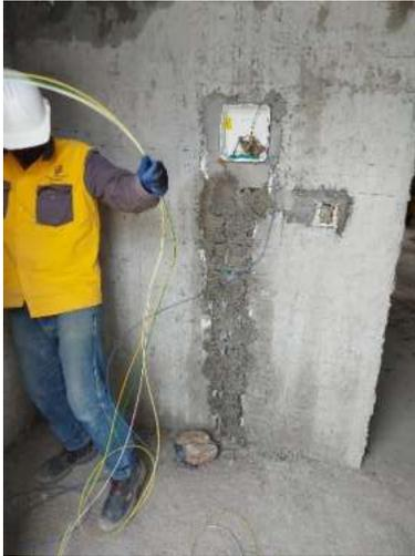
Fotografía 22. Instalación de cables red eléctrica (Fuente: Propia).
