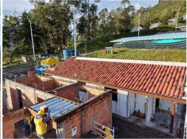
Fotografía 19. Construcción de vigas elevadas en vivienda tradicional (Fuente: Propia).
