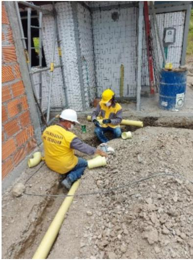
*Fotografía 27. Instalación de tuberías y acometidas (Fuente: Propia).*
