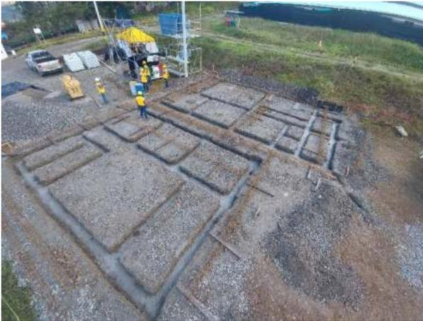
Fotografía 5. Excavaciones con concreto de limpieza [solado] (Fuente: Propia).
