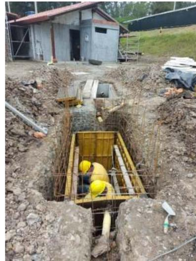
*Fotografía 28. Construcción tanque de almacenamiento de aguas lluvias (Fuente: Propia).*
