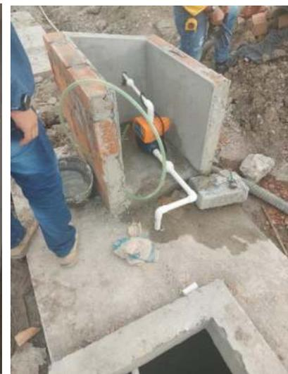
Fotografía 42. Instalación de Hidroflo (Fuente: Propia).
