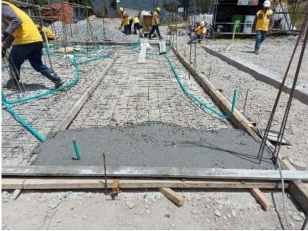
*Fotografía 9. Construcción de antepiso sobre malla electrosoldada distanciada de suelo (Fuente: Propia).*
