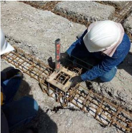
Fotografía 7. Nivelación de bases para estructura metálica (Fuente: Propia).
