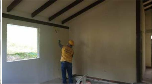
Fotografía 35. Pintura en paredes interiores (Fuente: Propia).
