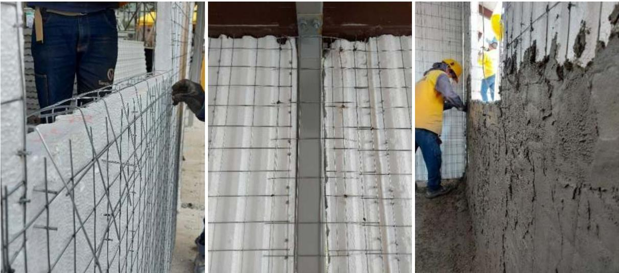
*Fotografía 17. Instalación de Durapanel con núcleo de poliestireno con malla electrosoldada y recubrimiento de concreto, correctamente ancladas a estructura (Fuente: Propia).*
