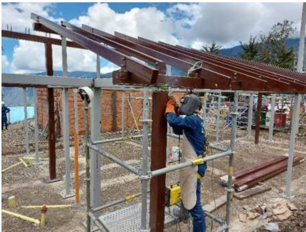
Fotografía 15. Instalación de cubierta en vivienda modular (Fuente: Propia).
