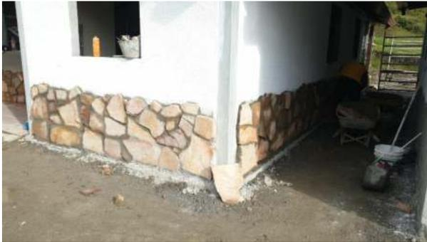
Fotografía 34. Instalación de piedra zócalo en fachada (Fuente: Propia).
