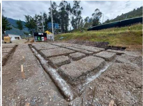
*Fotografía 3. Localización y replanteo (Fuente: Propia).      Fotografía 4. Excavación y agregado de cal (Fuente: Propia).*
