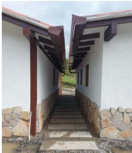
*Fotografía 47. Placa huellas instaladas en pasillo central (Fuente: Propia).*
