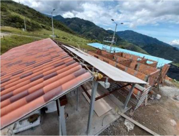
Fotografía 18. Instalación de cubierta en board y teja sevillana vivienda modular (Fuente: Propia).
