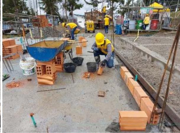
*Fotografía 10. Construcción de muros en mampostería vivienda tradicional (Fuente: Propia).*
