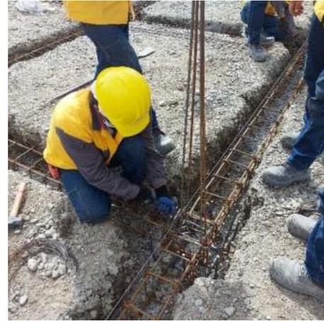
Fotografía 6. Instalación de acero (Fuente: Propia).
