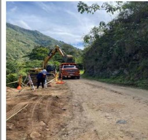
Relleno de la estructura con suelo e instalación de geodrén planar en muro particular ubicado en la abscisa K13+287-K13+332
