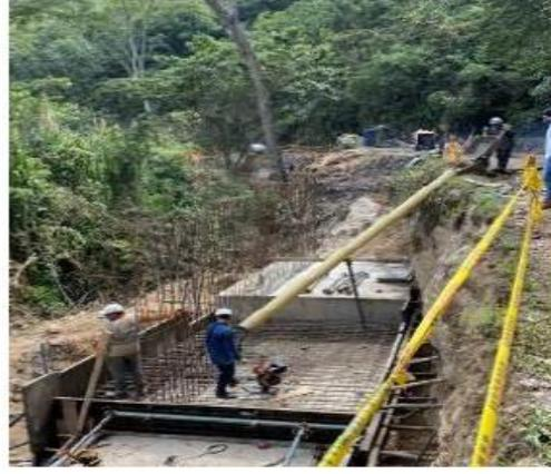
Excavación y nivelación para construcción de muro anclado convencional localizado en la abscisa K13+348 - K13+363.
