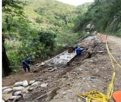
Armado de acero por módulos para zarpa y vástago del muro anclado de la abscisa K13+390.
