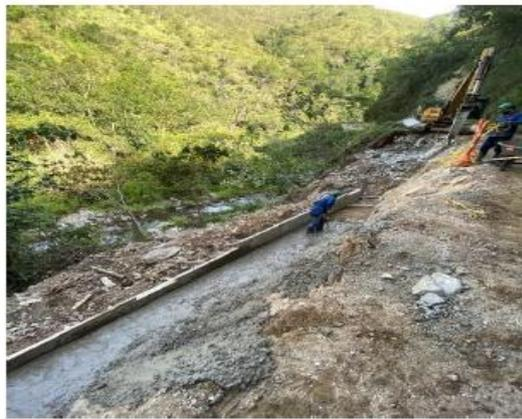
Armado de acero y vaciado de concreto de 4000 PSI para muro voladizo ubicado en la abscisa K13+405-k13+425
