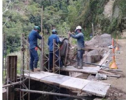
Relleno de estructura con suelo para muro anclado convencional ubicado en la abscisa K13+252.50
