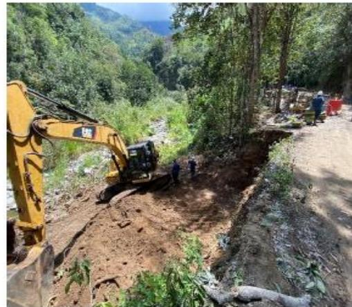
Mejoramiento de suelo en concreto ciclópeo y armado de acero por módulos para zarpa y vástago para muro anclado convencional en la abscisa k13+252.50 al k13+277.50
