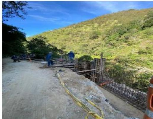
Excavación y nivelación de suelo para muro voladizo ubicado en la abscisa K13+ 802.40 - K13+818,80.
