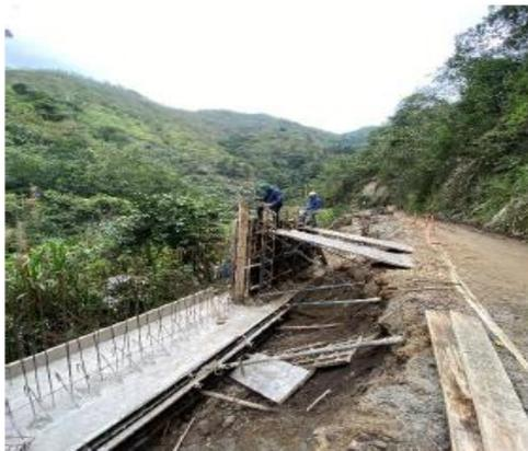
Instalación de geodrén planar y relleno de la estructura con suelo en muro ubicado en la abscisa K13+390- K13+405.
