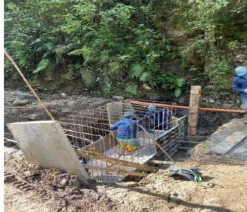
Vaciado de concreto de 4000 psi para box culvert K13+160.
