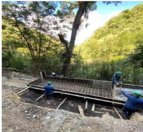
Vaciado de concreto de 4000 PSI para zarpas y vástagos del muro K13+390-K13+405.
