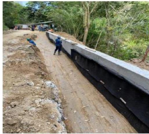
Excavación y nivelación para muro voladizo ubicado en la abscisa K13+575 a K13+620.
