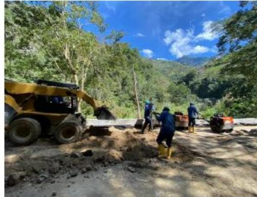
Construcción de muro de empalme ubicado en la abscisa K13+335 a K13+348 con sus respectivos anclajes.
