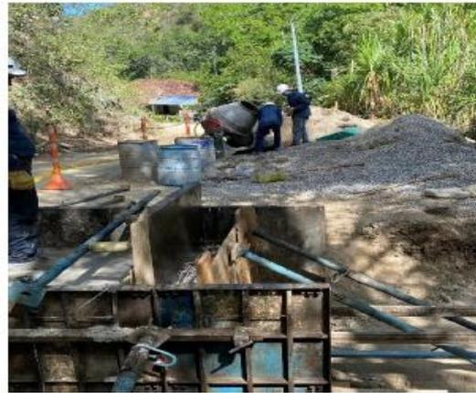
Excavación y nivelación para muro de contención particular localizado en la abscisa K13+287-K13+332.
