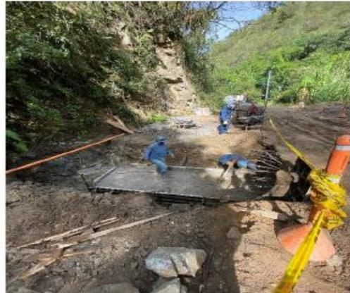
Armado de acero para box culvert ubicado en la abscisa k13+160.
