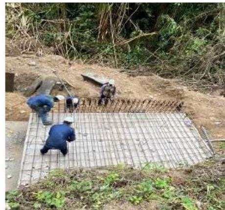
Vaciado de concreto de 4000 psi para zarpa en muro particular ubicado en la abscisa K13+287- K13+332.
