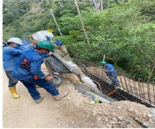
Armado de acero y mejoramiento del suelo en concreto ciclópeo del muro voladizo ubicado en las abscisas K13+925-K13+970
