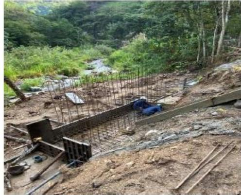
Armado de acero y vaciado de concreto de 28 Mpa para box culvert ubicado en la abscisa K13+375.
