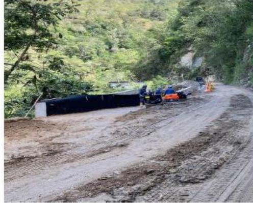
Excavación y nivelación para muro voladizo ubicado en la abscisa K13+405- K13+425
