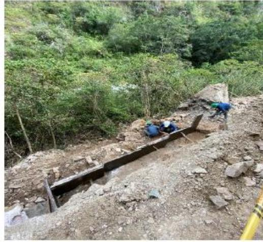
Armado de acero y vaciado de concreto de 4000 PSI en muro voladizo ubicado en la abscisa K13+575 a K13+620.
