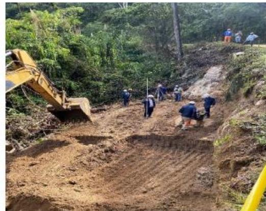
Mejoramiento de suelo en concreto ciclópeo en muros de contención de las abscisas K13+287-K13+332 y K13+348-K13+363.
