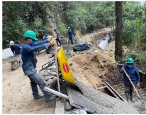
Instalación de geodrén planar para muro anclado ubicado en la K13+348 a K13+363 y su respectivo relleno.
