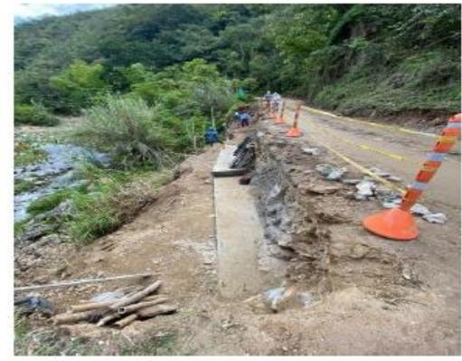
Excavación y nivelación para muro anclado ubicado en la abscisa K14+080-K14+090
