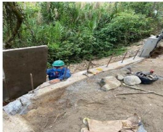
Excavación y nivelación para muro anclado ubicado en la abscisa K13+ 252.50 a k13+277.50
