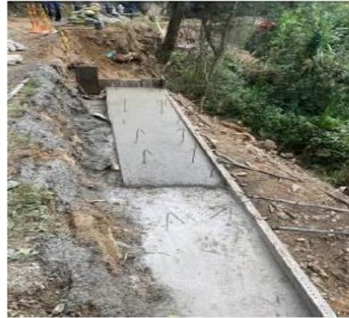
Armado de acero por módulos del muro de contención ubicado en la abscisa K13+287-K13+332.
