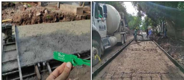
Ilustración 11 – Recibo de tique y fundida de placas de concreto.
