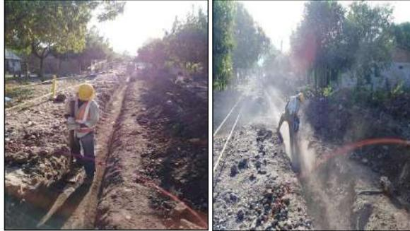
Fotografía 19 – Compactación de zanjas de excavación.
