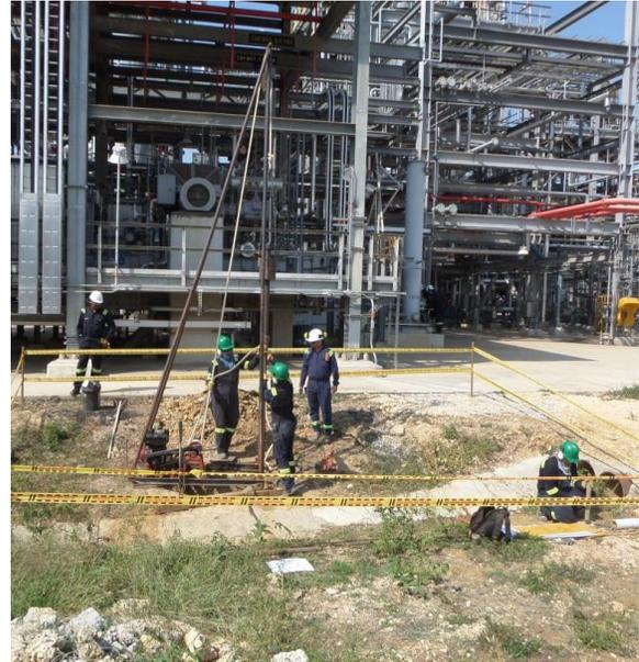
*Ilustración 3. Equipo de perforación a rotación y percusión
