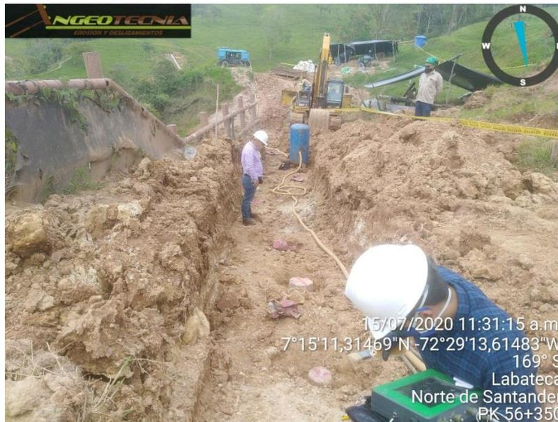
*Ilustración 10. Ensayo PIT en micropilote
