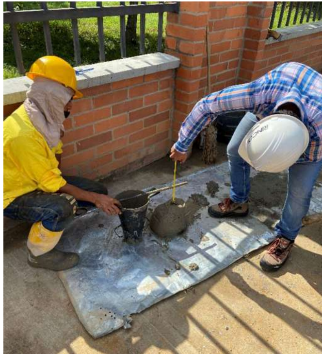
Figura 8 Ensayo de Asentamiento del Concreto
