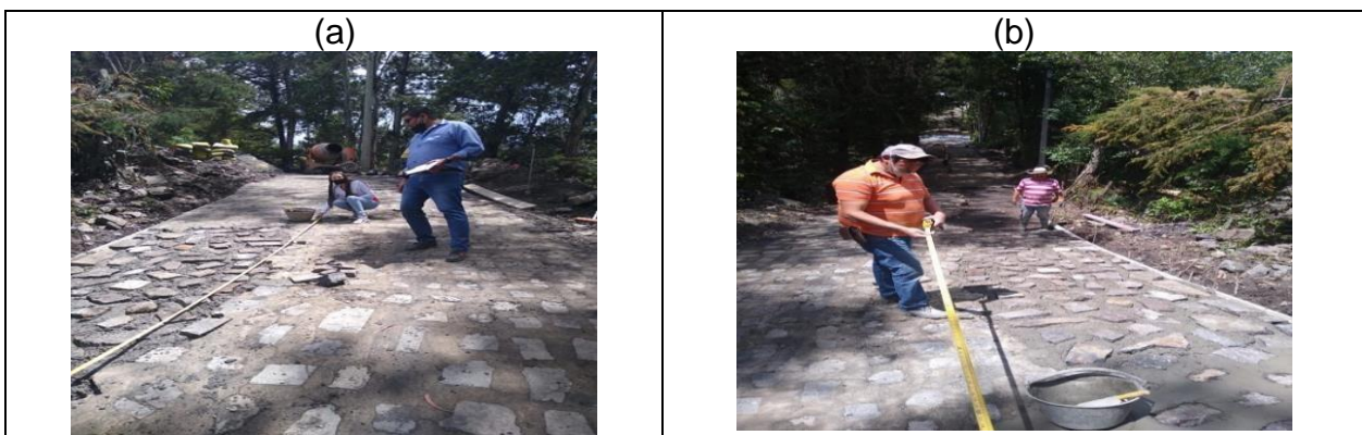
Figura 3. Visita a red de alcantarillado urbana del municipio de Chiscas, Boyacá. Fuente: Propio
