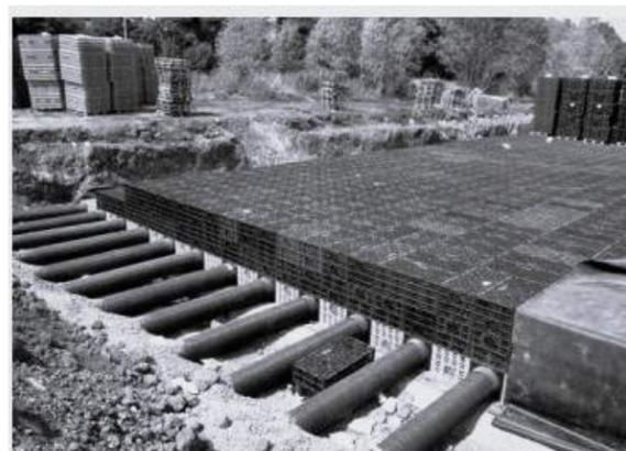
Ilustración 13. Tanque almacenamiento Fuente: lineamientos del componente paisajístico EAAB
