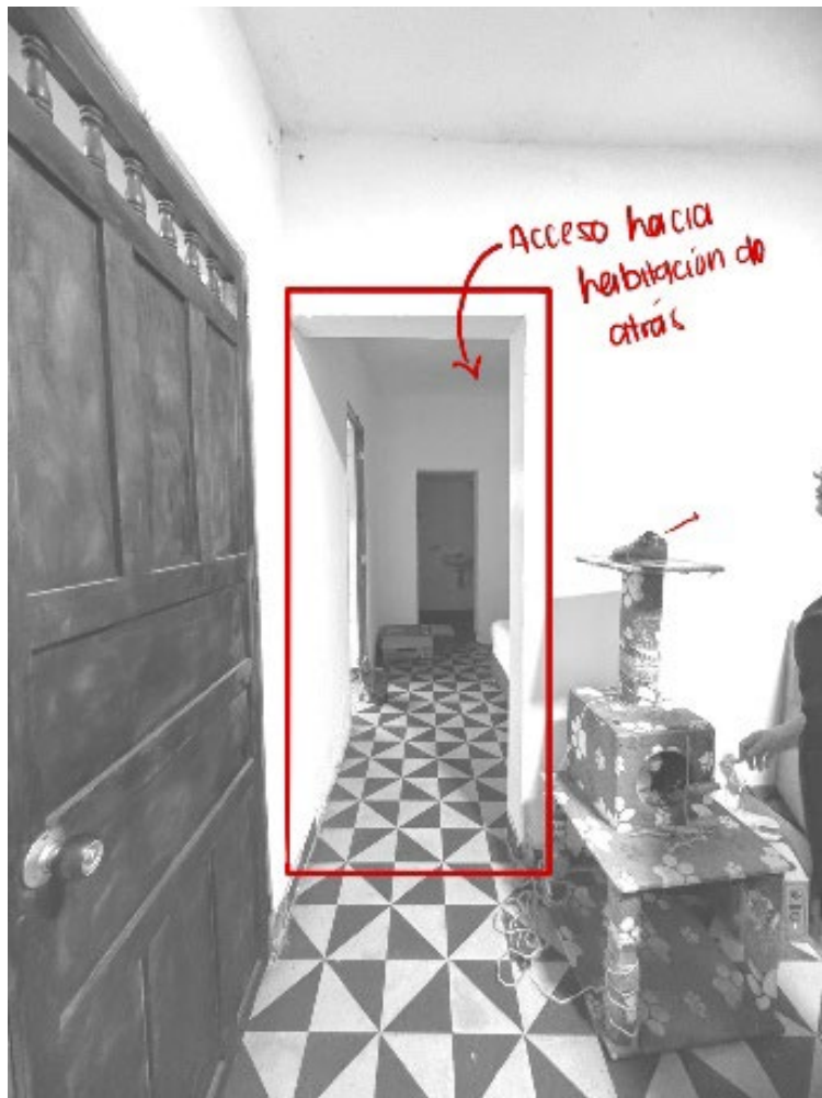
Imagen 50, conexión entre habitaciones. Fuente propia.
