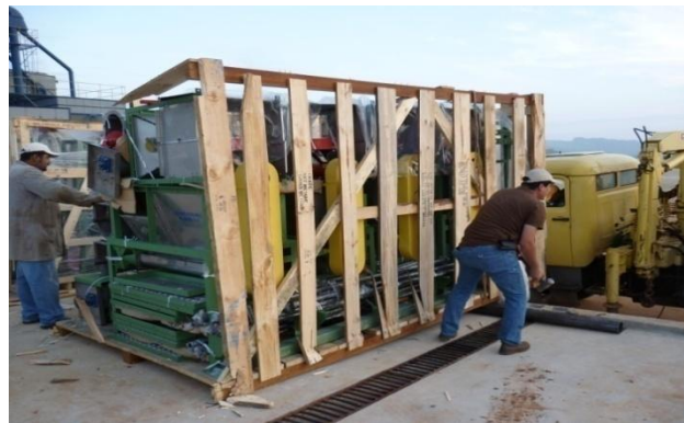
Ilustración17. Engucalado de las máquinas
